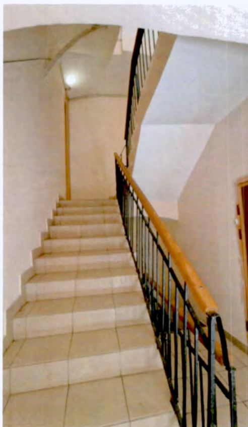
6. Лестница Л-3 (Фотография от 24.05.2024).
