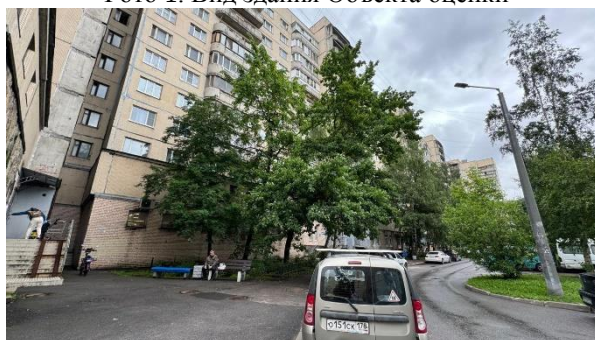
Фото 3. Вид здания Объекта оценки. Дворовая территория
