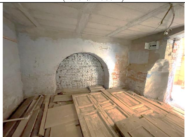
Фото 28. Типичное состояние Объекта оценки (помещение 38-Н)
