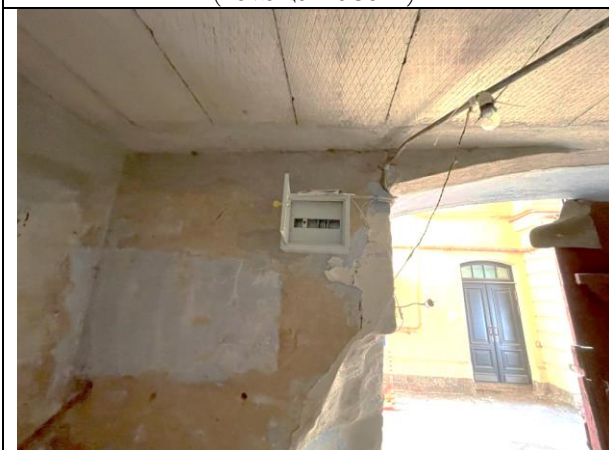
Фото 27. Типичное состояние Объекта оценки (помещение 38-Н)
