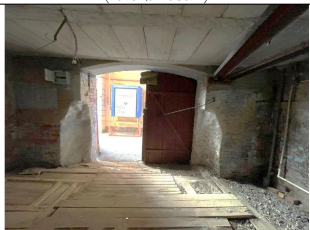
Фото 26. Типичное состояние Объекта оценки (помещение 38-Н)
