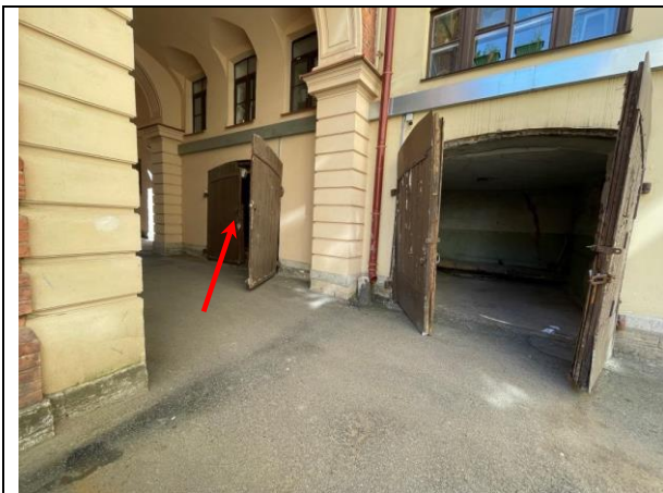
Фото 23. Входная группа Объекта оценки (помещение 38-Н)
