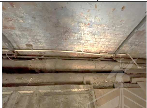
Фото 30. Типичное состояние Объекта оценки (помещение 38-Н)
