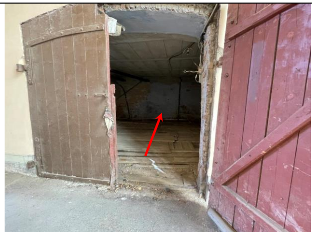
Фото 24. Входная группа Объекта оценки (помещение 38-Н)
