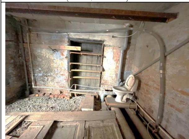
Фото 29. Типичное состояние Объекта оценки (помещение 38-Н)
