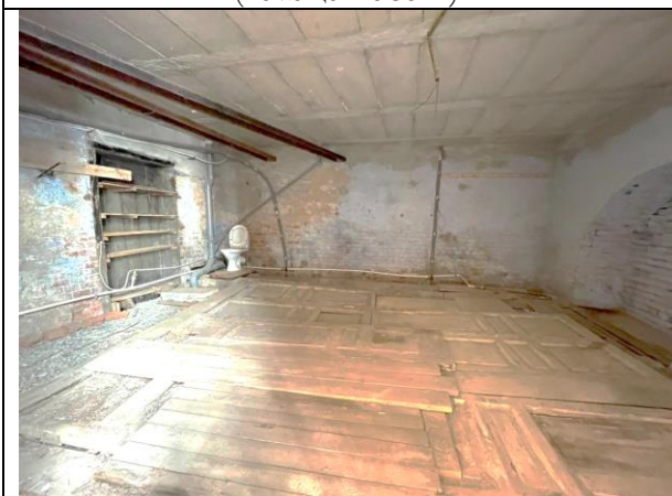
Фото 25. Типичное состояние Объекта оценки (помещение 38-Н)
