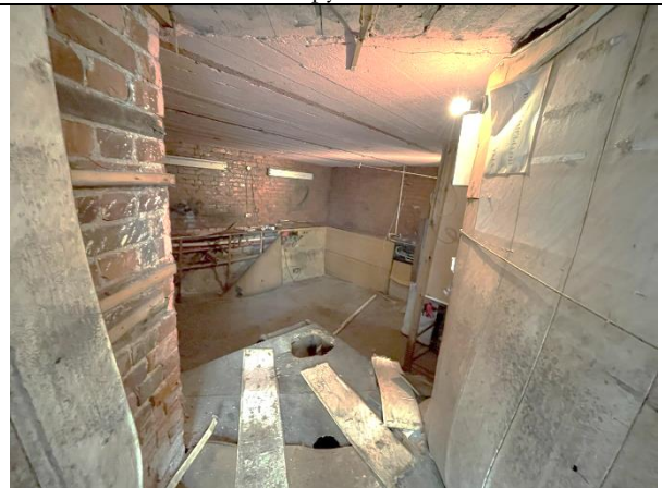
Фото 16. Типичное состояние Объекта оценки
