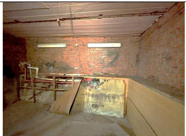
Фото 18. Типичное состояние Объекта оценки
