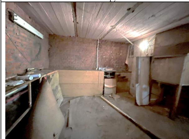
Фото 17. Типичное состояние Объекта оценки
