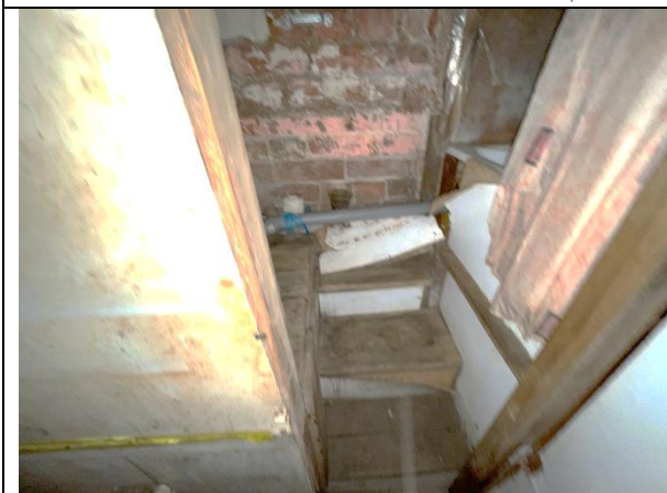
Фото 19. Типичное состояние Объекта оценки
