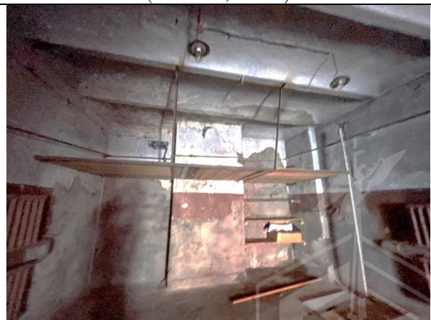
Фото 30. Типичное состояние Объекта оценки (пом.40-Н, лит.Ш)
