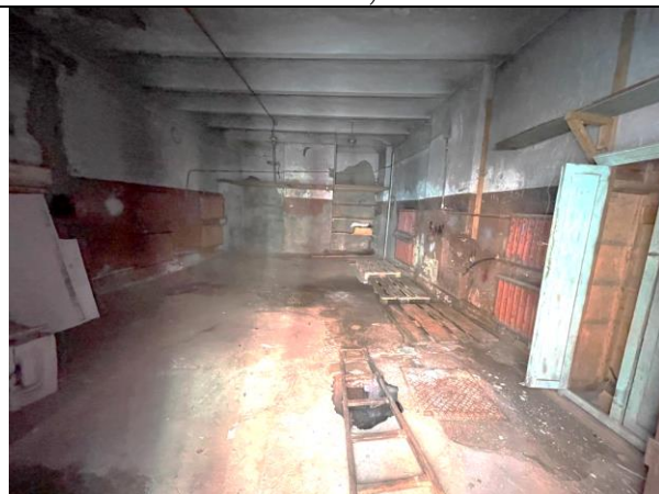
Фото 29. Типичное состояние Объекта оценки (пом.40-Н, лит.Ш)
