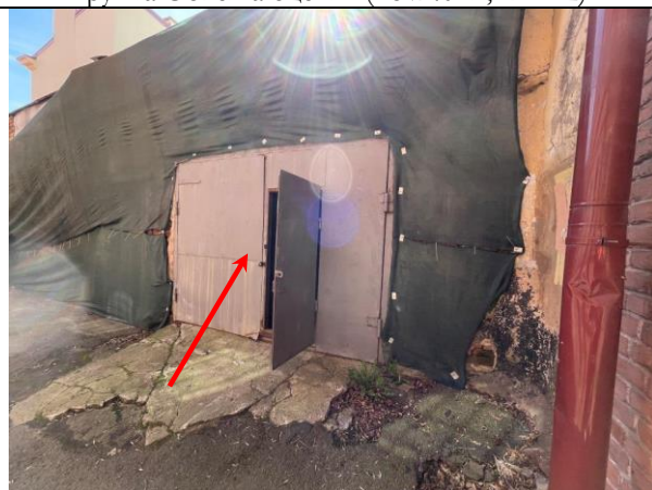
Фото 27. Входная группа Объекта оценки (пом.40-Н, лит.Ш)
