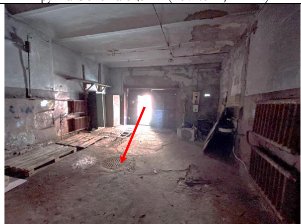
Фото 28. Типичное состояние Объекта оценки (пом.40-Н, лит.Ш)
