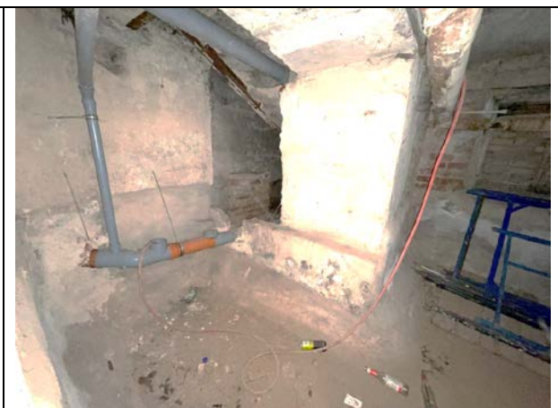
Фото 34. Типичное состояние объекта оценки
