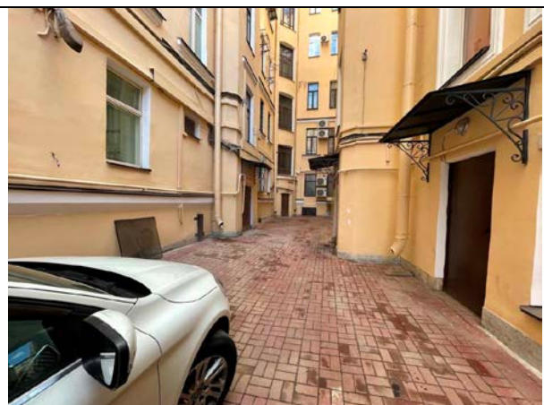
Фото 26. Вид здания расположения Объекта оценки
