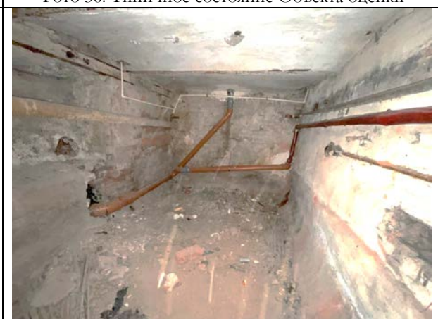
Фото 38. Типичное состояние Объекта оценки
