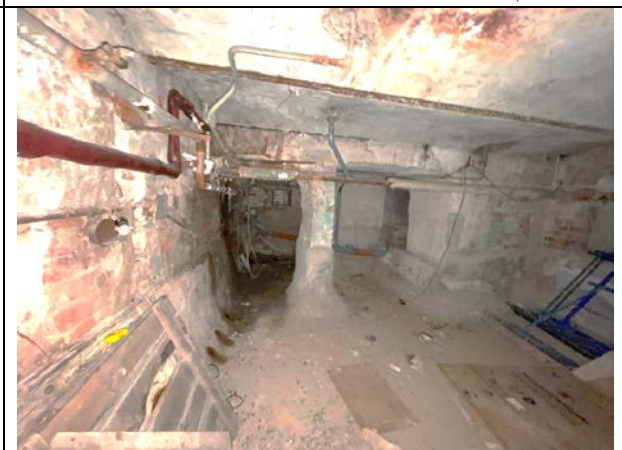
Фото 36. Типичное состояние Объекта оценки
