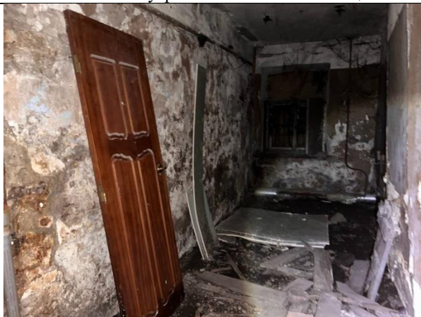
Фото № 9 – Внутреннее состояние помещения
