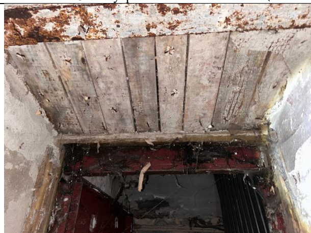
Фото № 20 – Внутреннее состояние помещения
