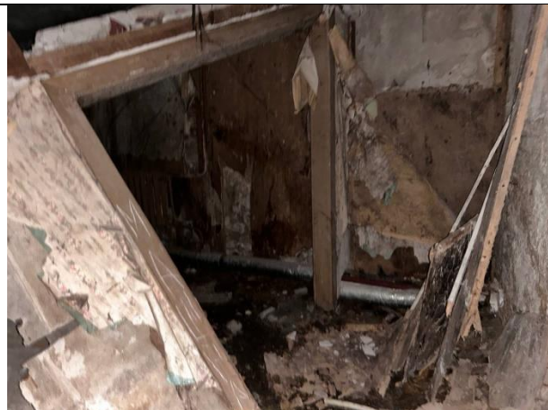
Фото № 16 – Внутреннее состояние помещения
