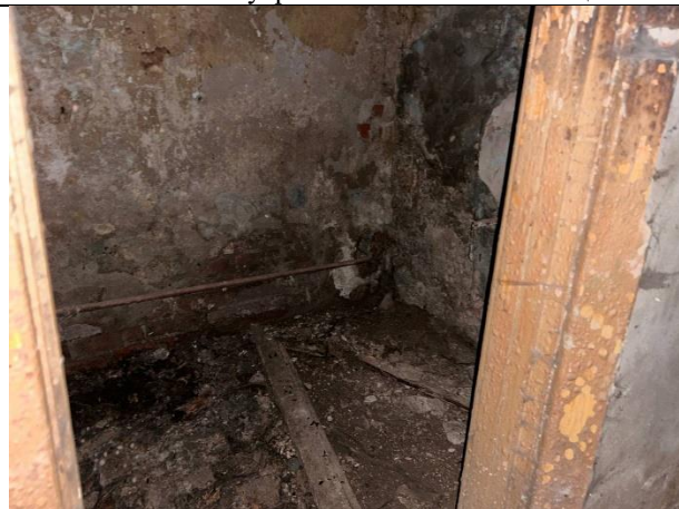
Фото № 18 – Внутреннее состояние помещения
