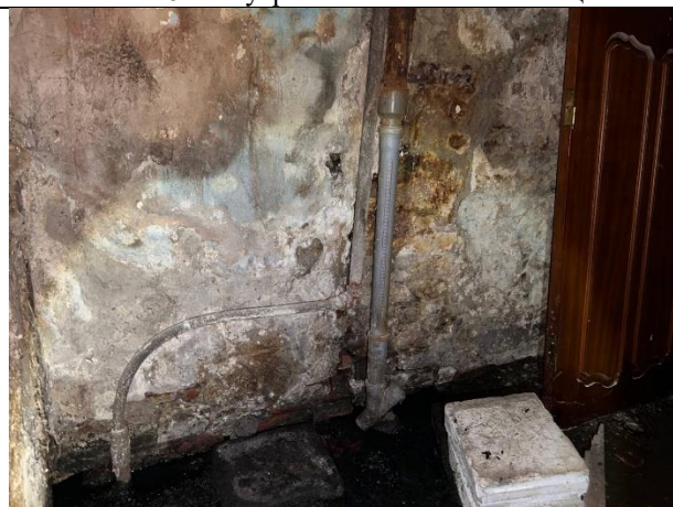
Фото № 12 – Внутреннее состояние помещения
