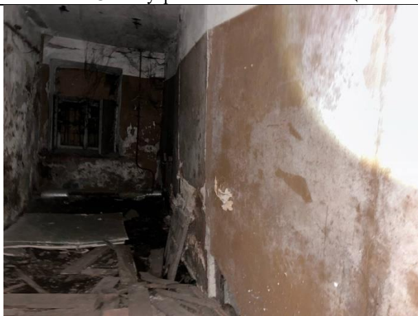
Фото № 11 – Внутреннее состояние помещения
