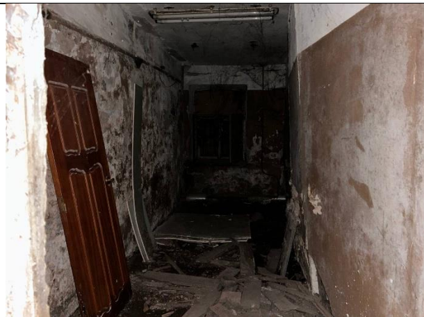
Фото № 8 – Внутреннее состояние помещения
