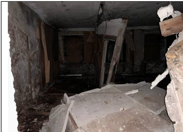
Фото № 15 – Внутреннее состояние помещения
