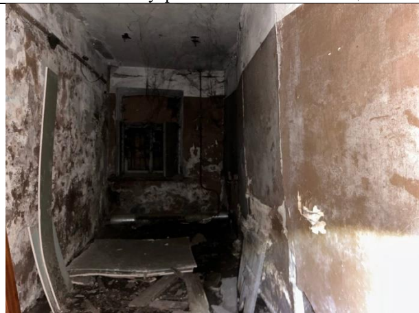
Фото № 10 – Внутреннее состояние помещения
