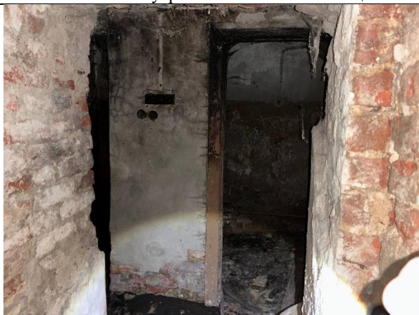
Фото № 13 – Внутреннее состояние помещения
