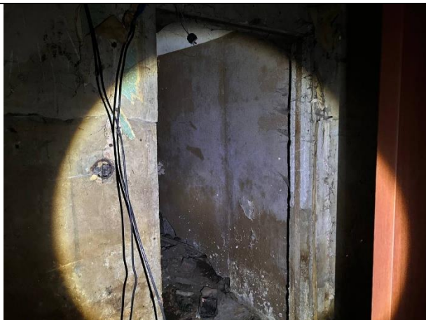
Фото № 7 – Внутреннее состояние помещения
