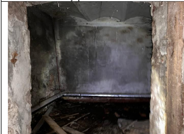
Фото № 17 – Внутреннее состояние помещения
