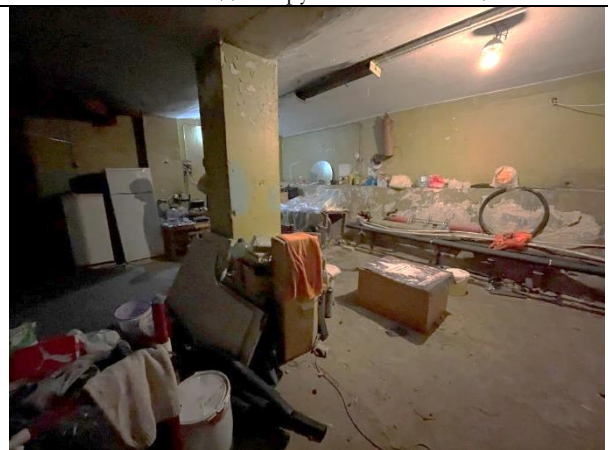
Фото 28. Типичное состояние Объекта оценки
