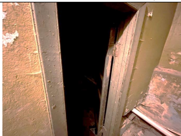
Фото 39. Типичное состояние Объекта оценки
