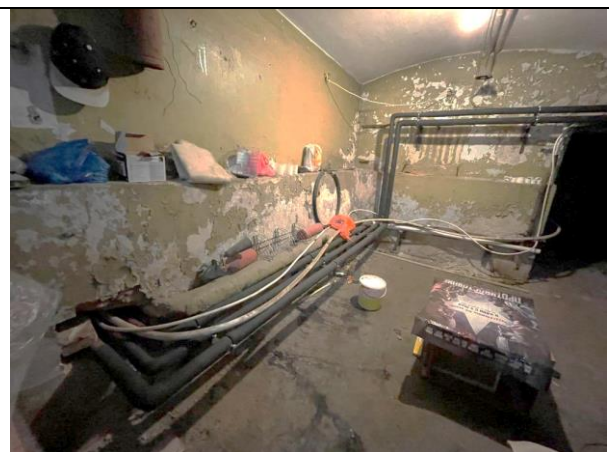
Фото 42. Типичное состояние Объекта оценки
