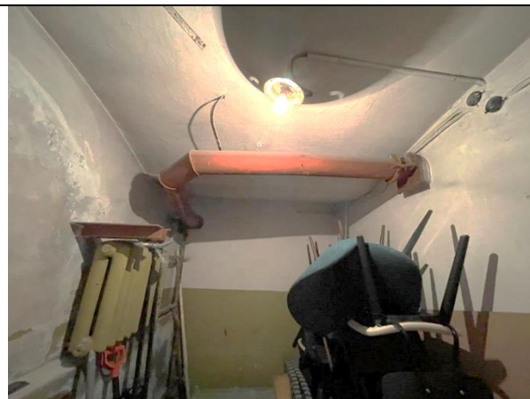
Фото 34. Типичное состояние Объекта оценки
