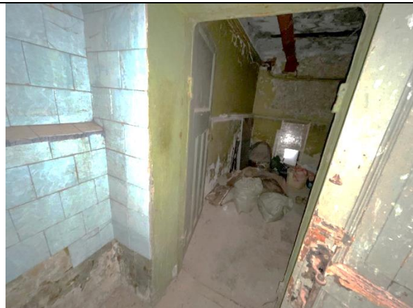
Фото 35. Типичное состояние Объекта оценки
