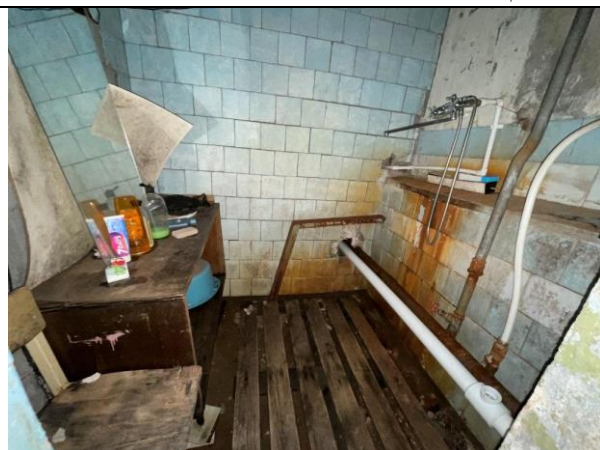
Фото 37. Типичное состояние Объекта оценки
