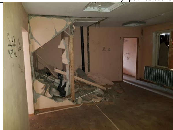
Фото 9. Внутреннее состояние Объекта оценки
