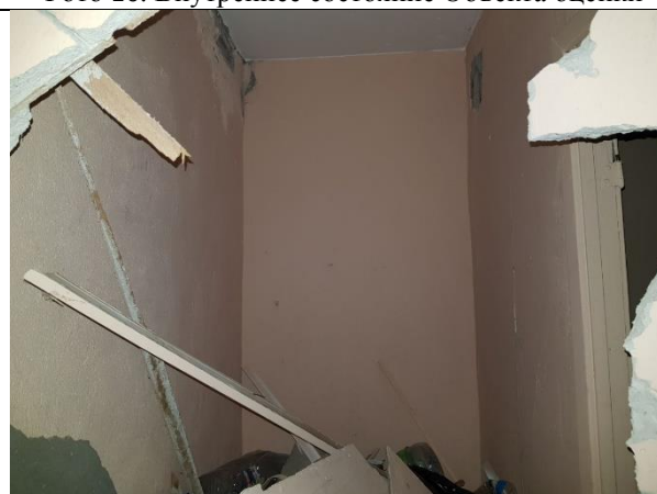
Фото 12. Внутреннее состояние Объекта оценки
