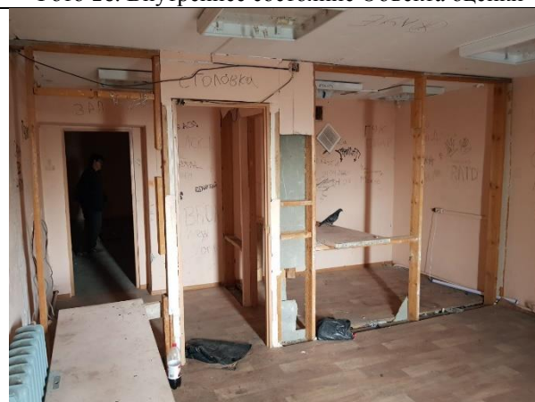
Фото 18. Внутреннее состояние Объекта оценки
