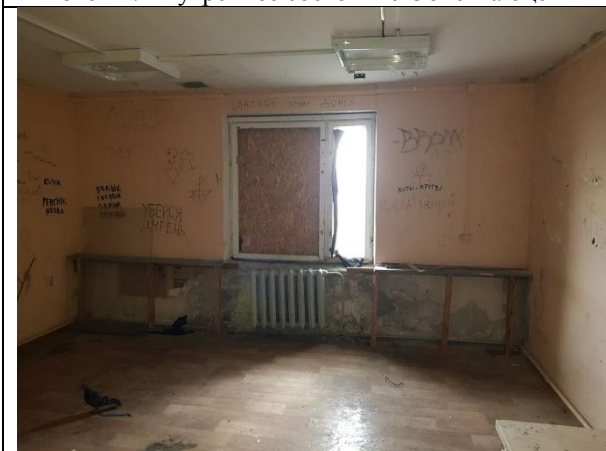
Фото 19. Внутреннее состояние Объекта оценки
