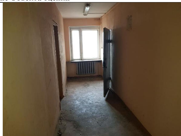
Фото 10. Внутреннее состояние Объекта оценки
