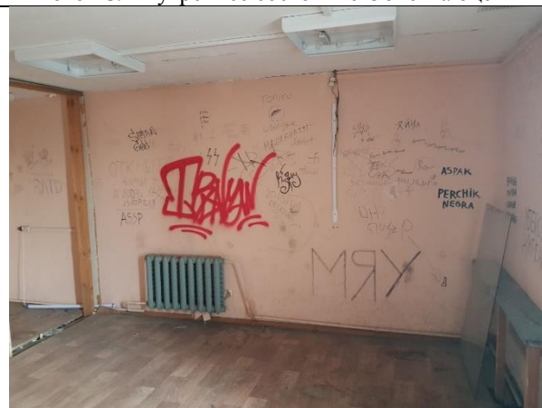
Фото 20. Внутреннее состояние Объекта оценки
