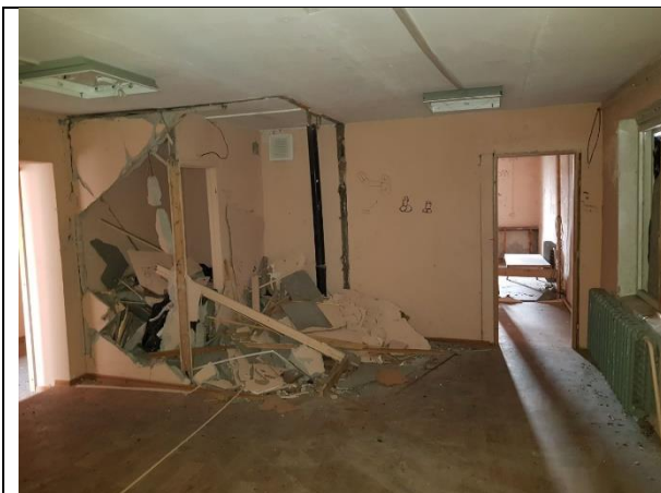
Фото 15. Внутреннее состояние Объекта оценки
