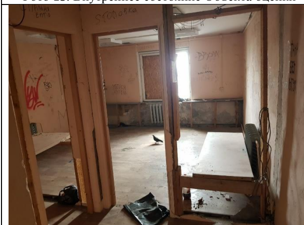
Фото 17. Внутреннее состояние Объекта оценки
