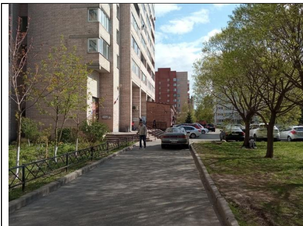
Фото 3. Ближайшее окружение. Дворовая территория
