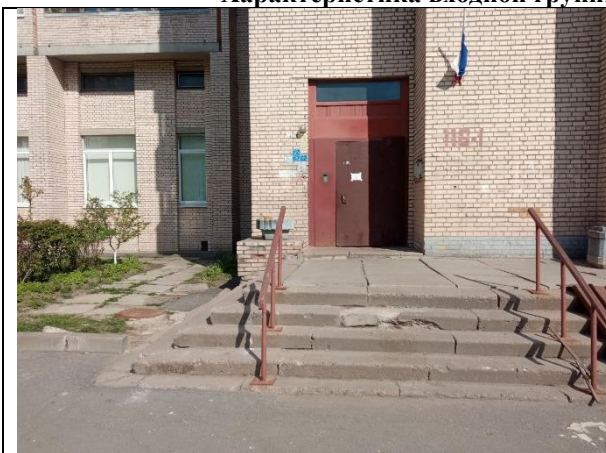
Фото 5. Общий вход со двора
