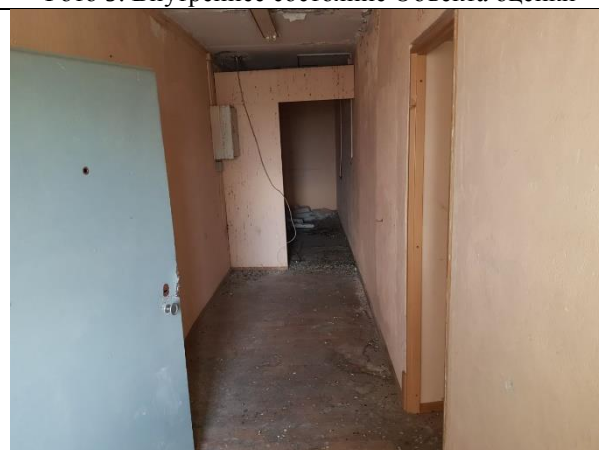
Фото 11. Внутреннее состояние Объекта оценки
