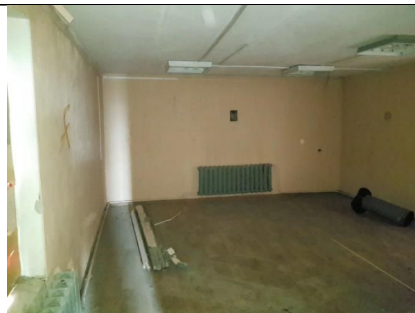
Фото 16. Внутреннее состояние Объекта оценки
