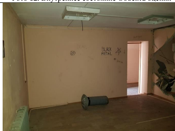
Фото 14. Внутреннее состояние Объекта оценки
