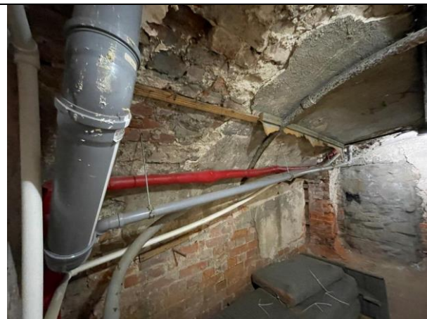
Фото 38. Типичное состояние Объекта оценки
