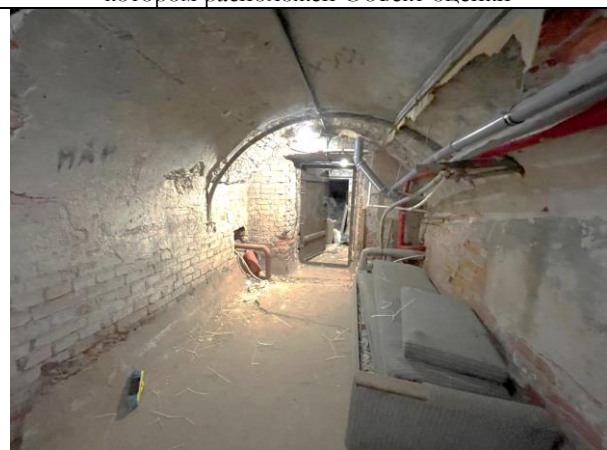
Фото 26. Типичное состояние Объекта оценки
