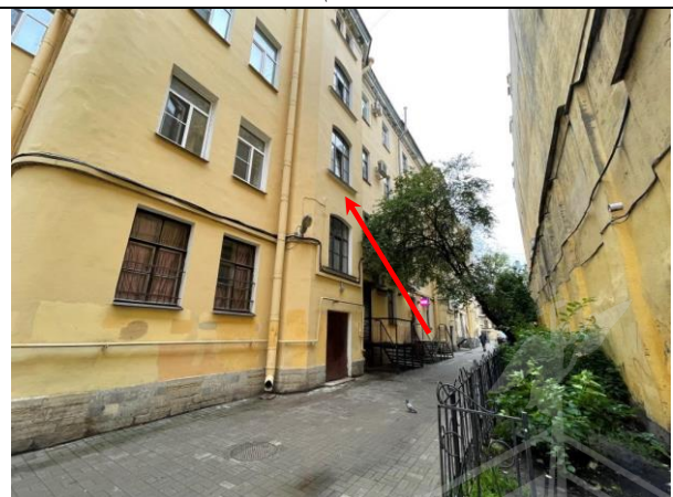
Фото 20. Вид здания расположения Объекта оценки
