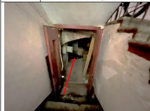
Фото 23. Входная группа подвального этажа здания, в котором расположен Объект оценки
