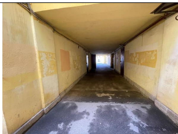
Фото 11. Проход через арку
