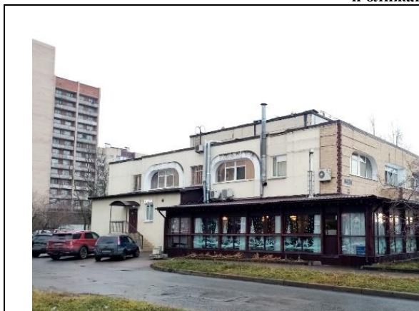
Фото 1. Вид здания, в котором расположен Объект оценки
