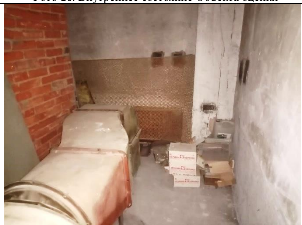
Фото 18. Внутреннее состояние Объекта оценки (ч.п. 4)
