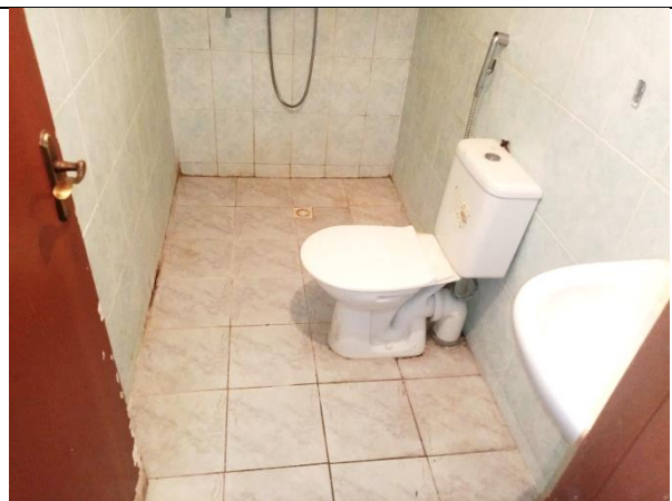
Фото 16. Внутреннее состояние Объекта оценки
