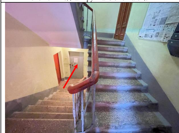
Фото 17. Лестничный проём Объекта оценки, входная группа Объекта оценки помещение 7-Н
