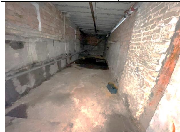
Фото 27. Типичное состояние Объекта оценки (помещение 7-Н)
