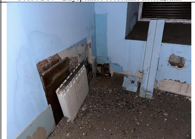
Фото № 16 – Внутреннее состояние помещения
