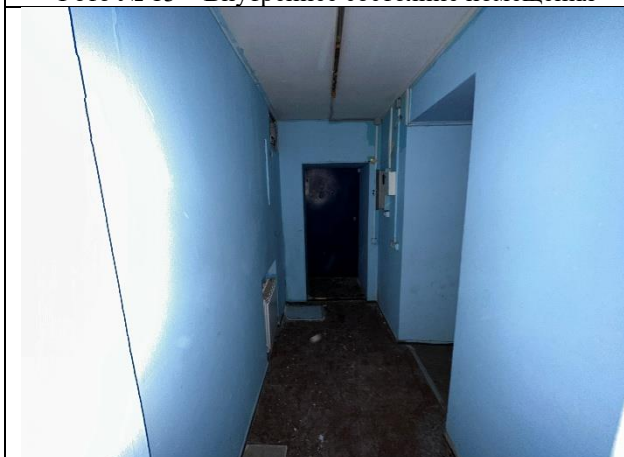
Фото № 15 – Внутреннее состояние помещения
