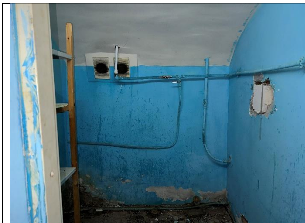
Фото № 13 – Внутреннее состояние помещения
