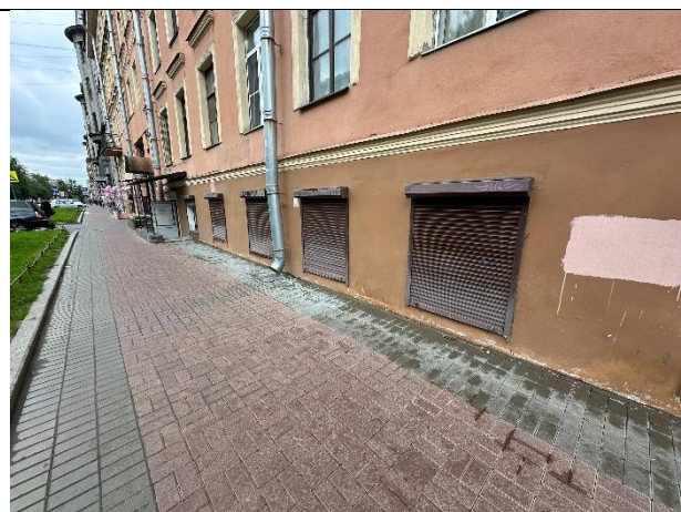
Фото № 2 – Подъездные пути
