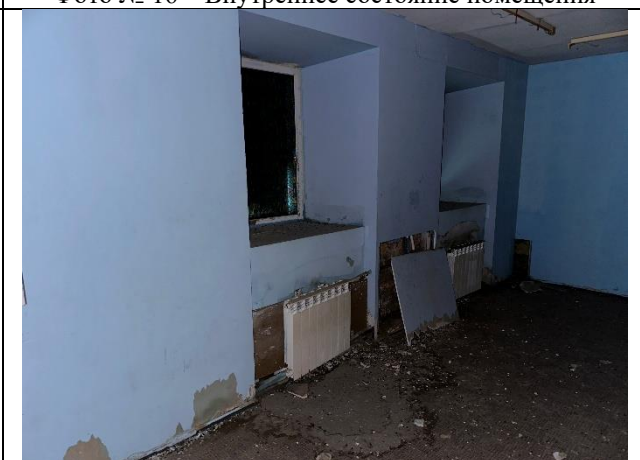
Фото № 18 – Внутреннее состояние помещения
