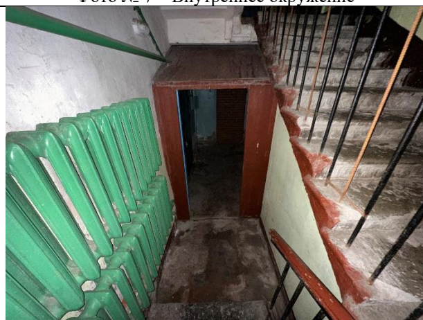
Фото № 9 – Вход в помещение
