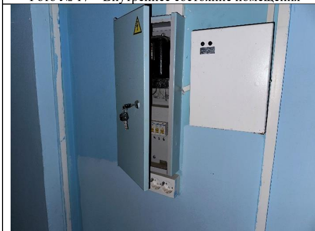
Фото № 19 – Внутреннее состояние помещения
