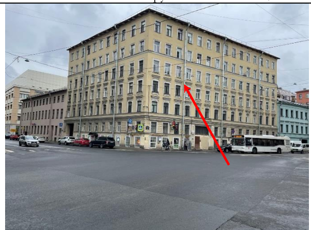
Фото 20. Вид здания расположения Объекта оценки
