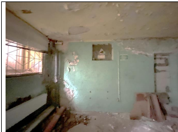
Фото 41. Типичное состояние Объекта оценки
