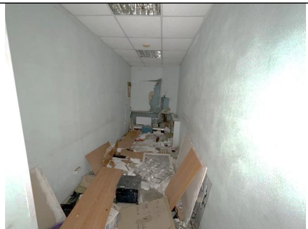
Фото 42. Типичное состояние Объекта оценки
