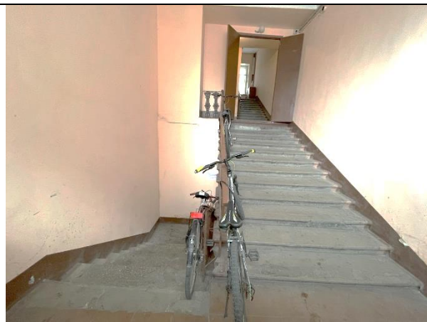
Фото 25. Лестничный проём Объекта оценки
