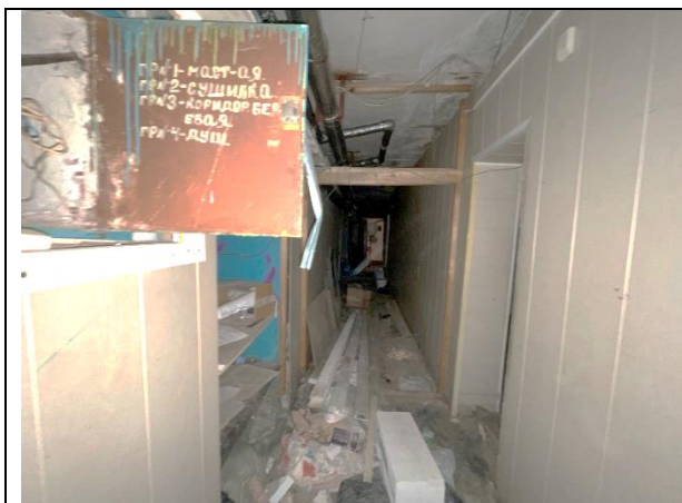
Фото 33. Типичное состояние Объекта оценки
