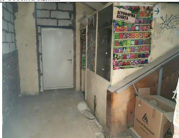
Фото 8. Внутреннее состояние Объекта оценки
