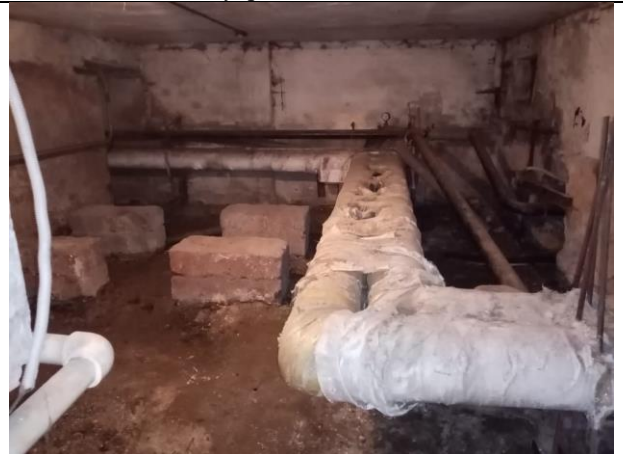
Фото № 18 – Внутреннее состояние помещения
