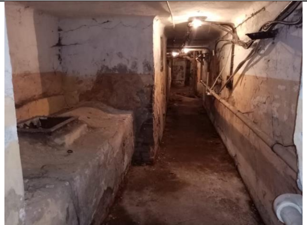
Фото № 16 – Внутреннее состояние помещения
