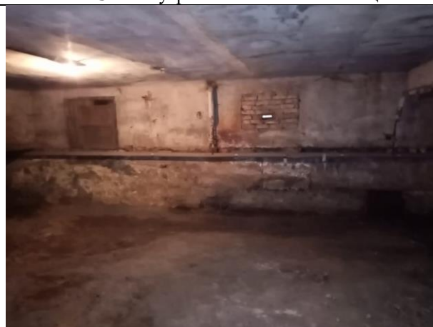
Фото № 36 – Внутреннее состояние помещения
