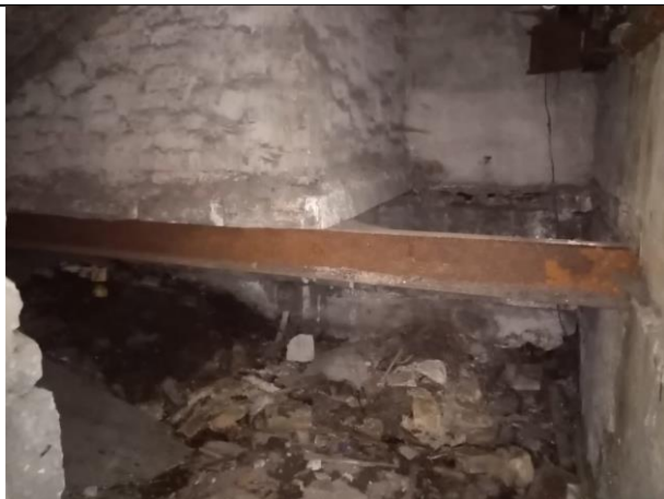
Фото № 31 – Внутреннее состояние помещения
