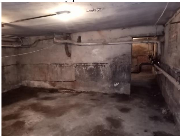
Фото № 19 – Внутреннее состояние помещения
