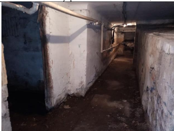
Фото № 13 – Внутреннее состояние помещения
