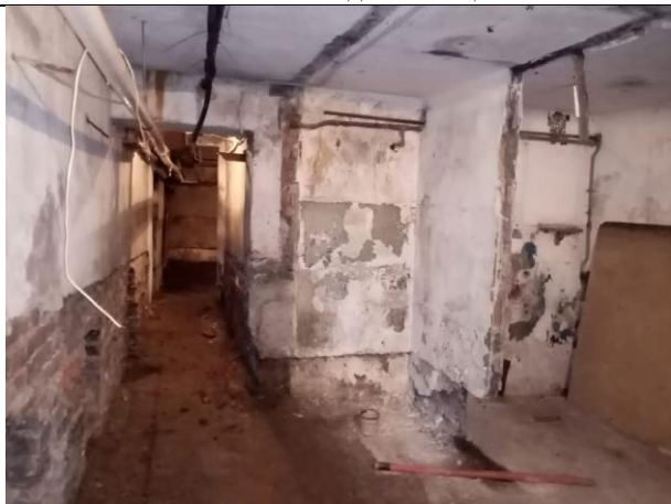
Фото № 9 – Внутреннее состояние помещения
