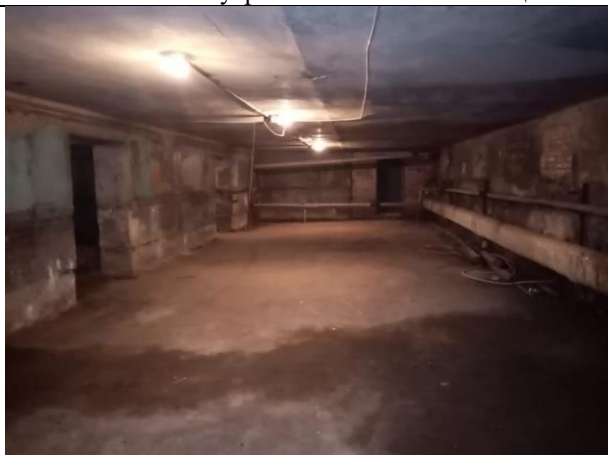
Фото № 29 – Внутреннее состояние помещения
