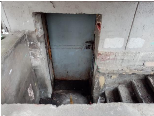
Фото № 7 – Вход в помещение
