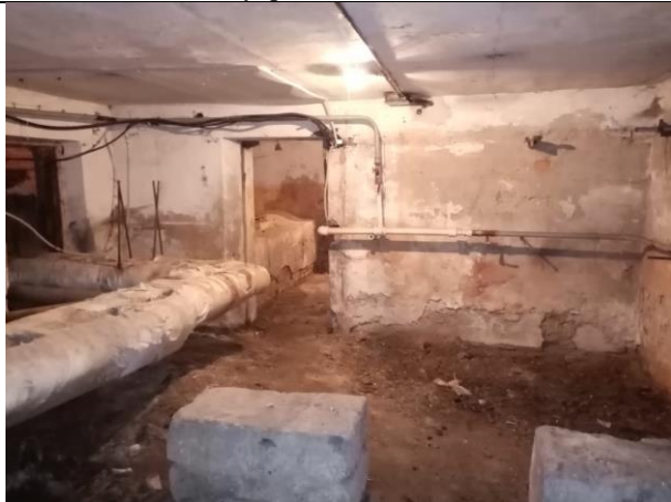
Фото № 17 – Внутреннее состояние помещения
