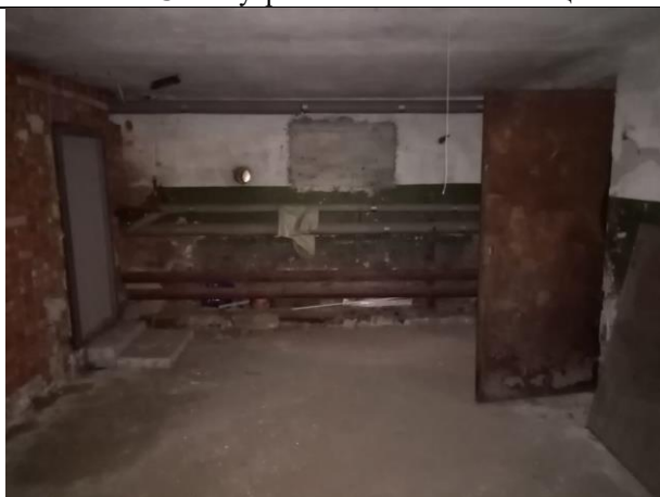
Фото № 27 – Внутреннее состояние помещения
