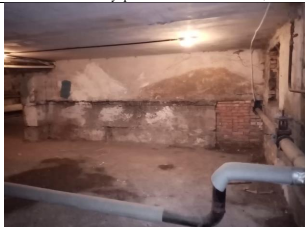
Фото № 26 – Внутреннее состояние помещения
