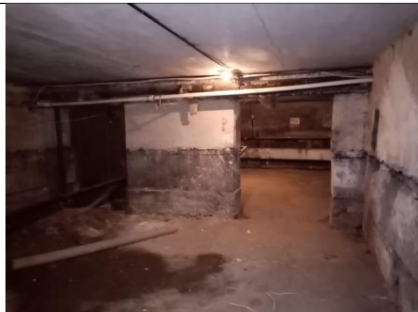
Фото № 24 – Внутреннее состояние помещения
