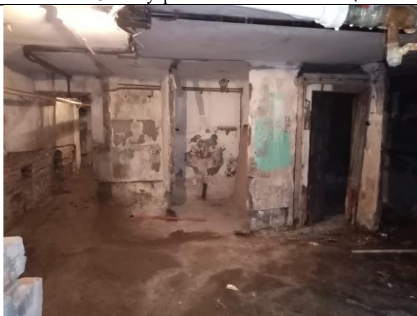
Фото № 11 – Внутреннее состояние помещения
