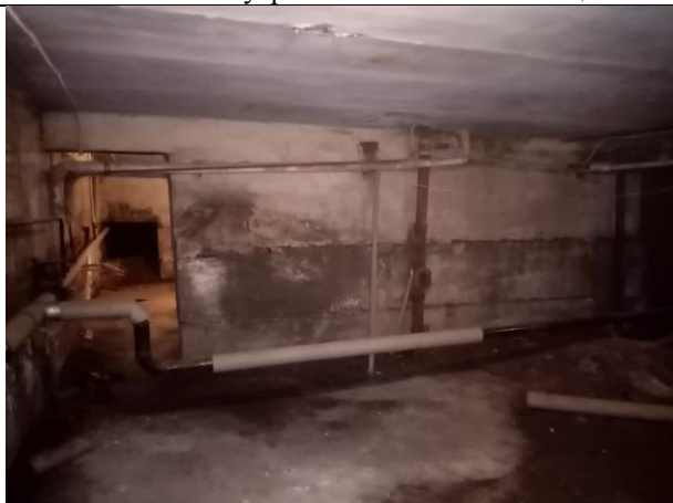
Фото № 25 – Внутреннее состояние помещения
