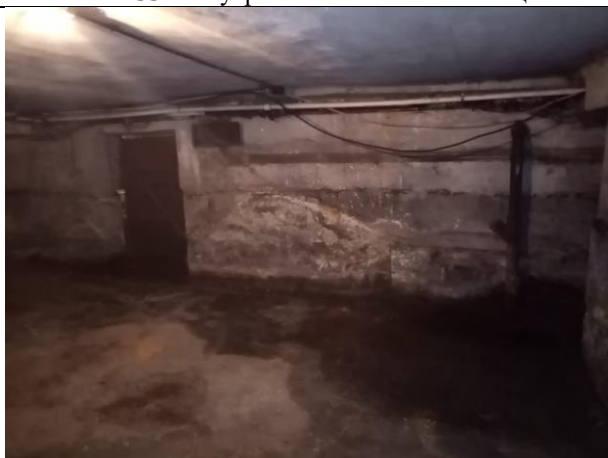
Фото № 35 – Внутреннее состояние помещения
