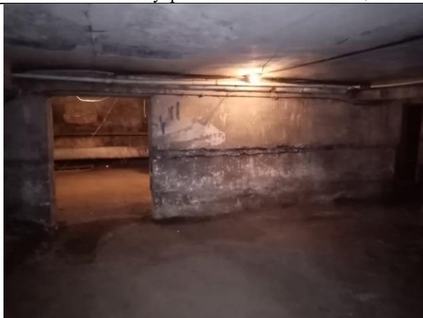
Фото № 33 – Внутреннее состояние помещения
