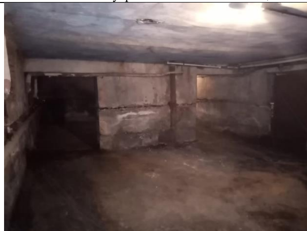
Фото № 34 – Внутреннее состояние помещения
