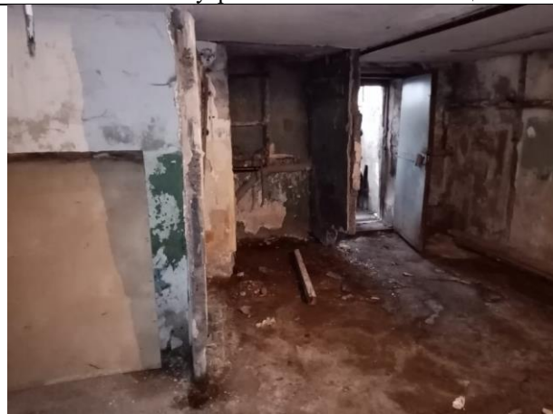
Фото № 10 – Внутреннее состояние помещения
