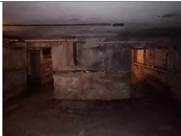
Фото № 32 – Внутреннее состояние помещения
