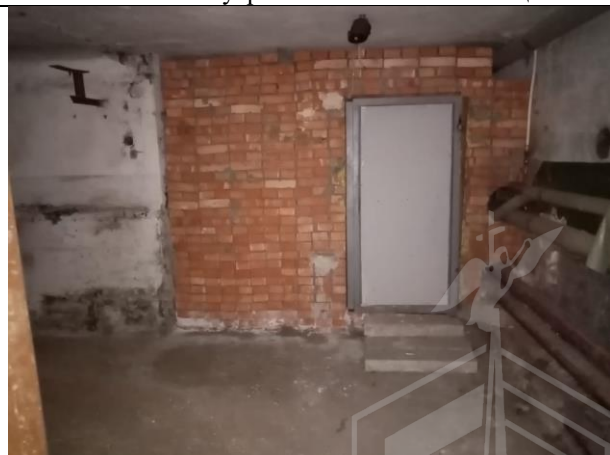
Фото № 30 – Внутреннее состояние помещения
