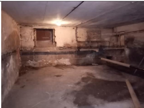
Фото № 23 – Внутреннее состояние помещения
