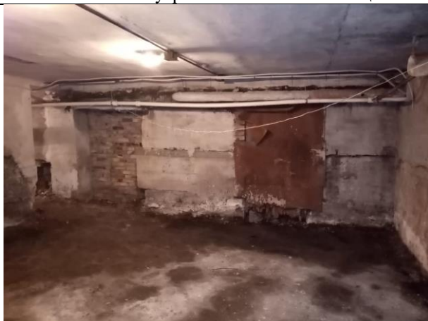
Фото № 21 – Внутреннее состояние помещения
