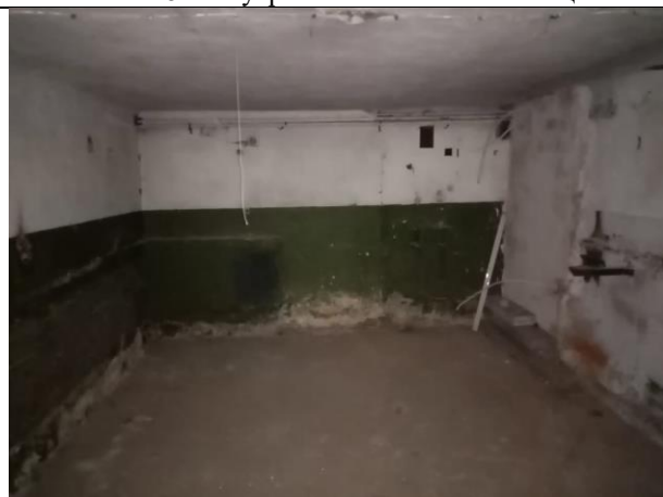
Фото № 28 – Внутреннее состояние помещения
