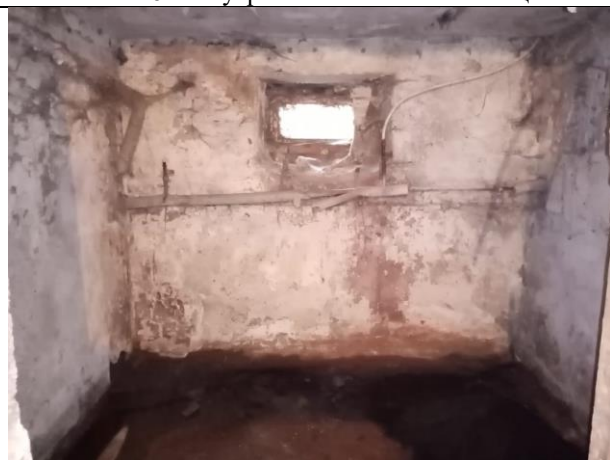
Фото № 12 – Внутреннее состояние помещения
