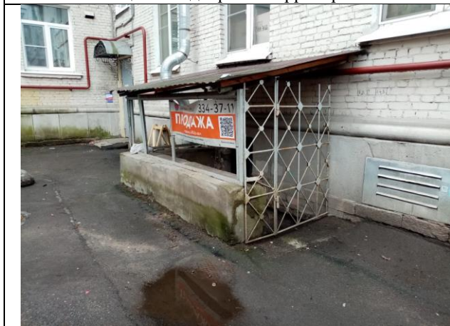
Фото № 5 – Вход в помещение
