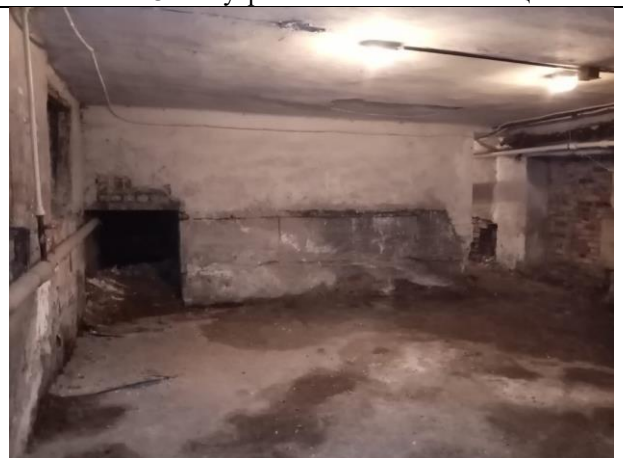
Фото № 20 – Внутреннее состояние помещения
