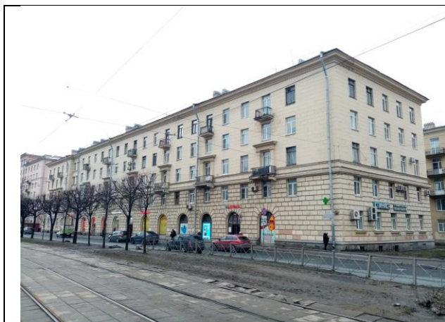
Фото № 1 – Здание, в котором находится Объект оценки
