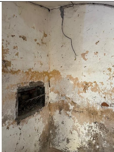
Фото № 10 – Внутреннее состояние помещения
