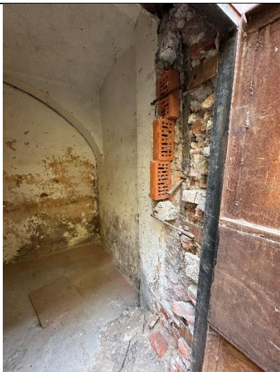
Фото № 15 – Внутреннее состояние помещения
