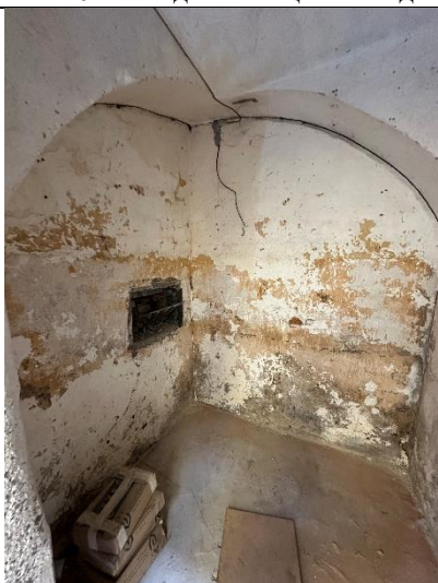
Фото № 11 – Внутреннее состояние помещения
