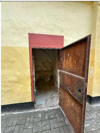
Фото № 9 – Вход в помещение со двора
