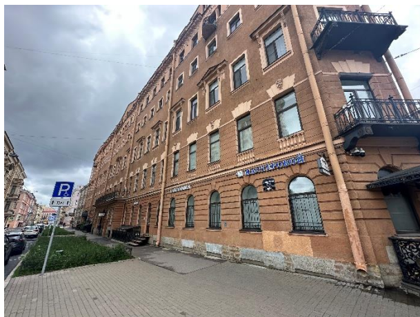
Фото № 3 – Здание, в котором находится Объект оценки
