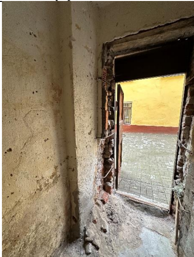
Фото № 13 – Внутреннее состояние помещения
