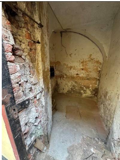
Фото № 16 – Внутреннее состояние помещения
