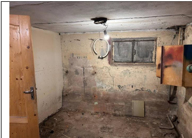
Фото № 17 – Внутреннее состояние помещения
