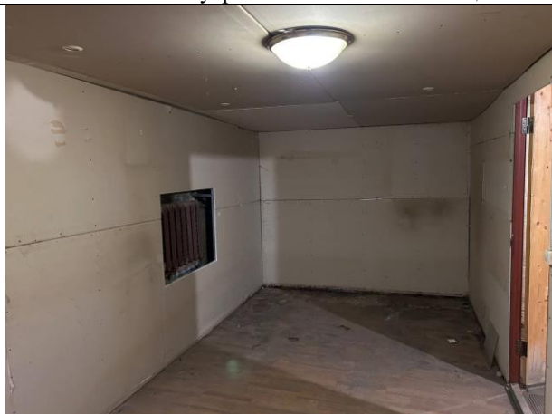
Фото № 20 – Внутреннее состояние помещения
