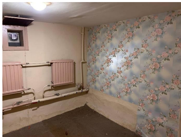
Фото № 12 – Внутреннее состояние помещения
