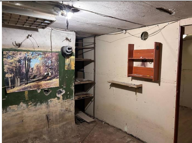
Фото № 15 – Внутреннее состояние помещения
