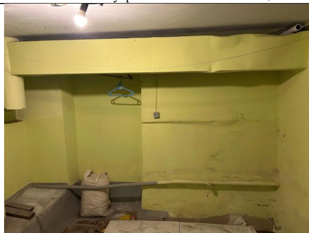
Фото № 14 – Внутреннее состояние помещения
