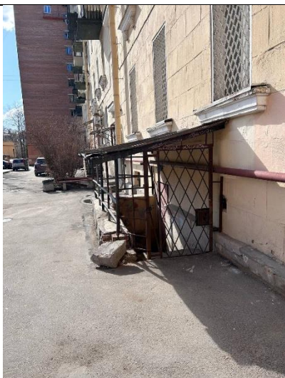
Фото № 5 – Вход в помещение
