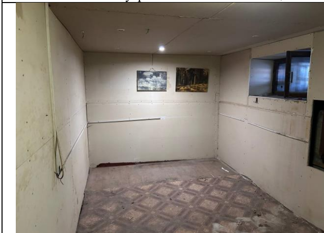
Фото № 19 – Внутреннее состояние помещения
