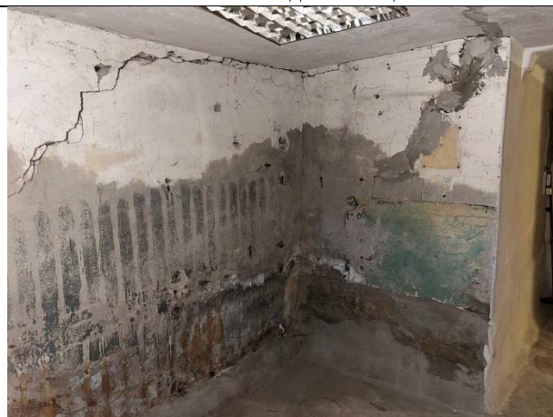
Фото № 8 – Внутреннее состояние помещения
