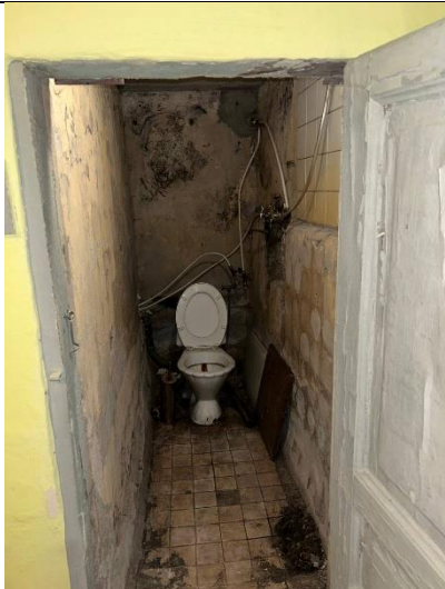
Фото № 11 – Внутреннее состояние помещения
