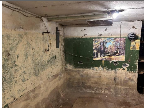
Фото № 16 – Внутреннее состояние помещения
