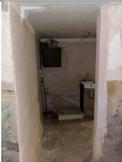
Фото № 9 – Внутреннее состояние помещения
