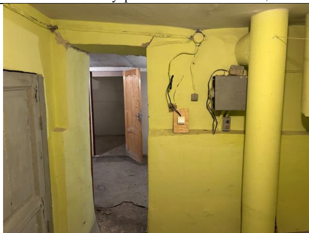
Фото № 13 – Внутреннее состояние помещения
