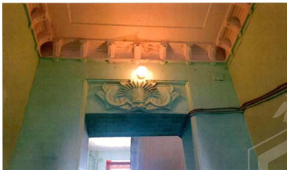
14. Интерьер. Пространство ЛК-1.
