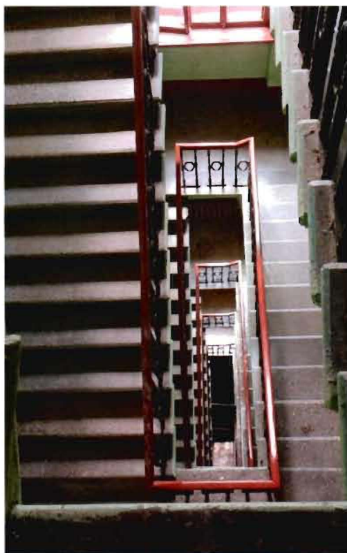
16. Интерьер. Пространство ЛК-9.
