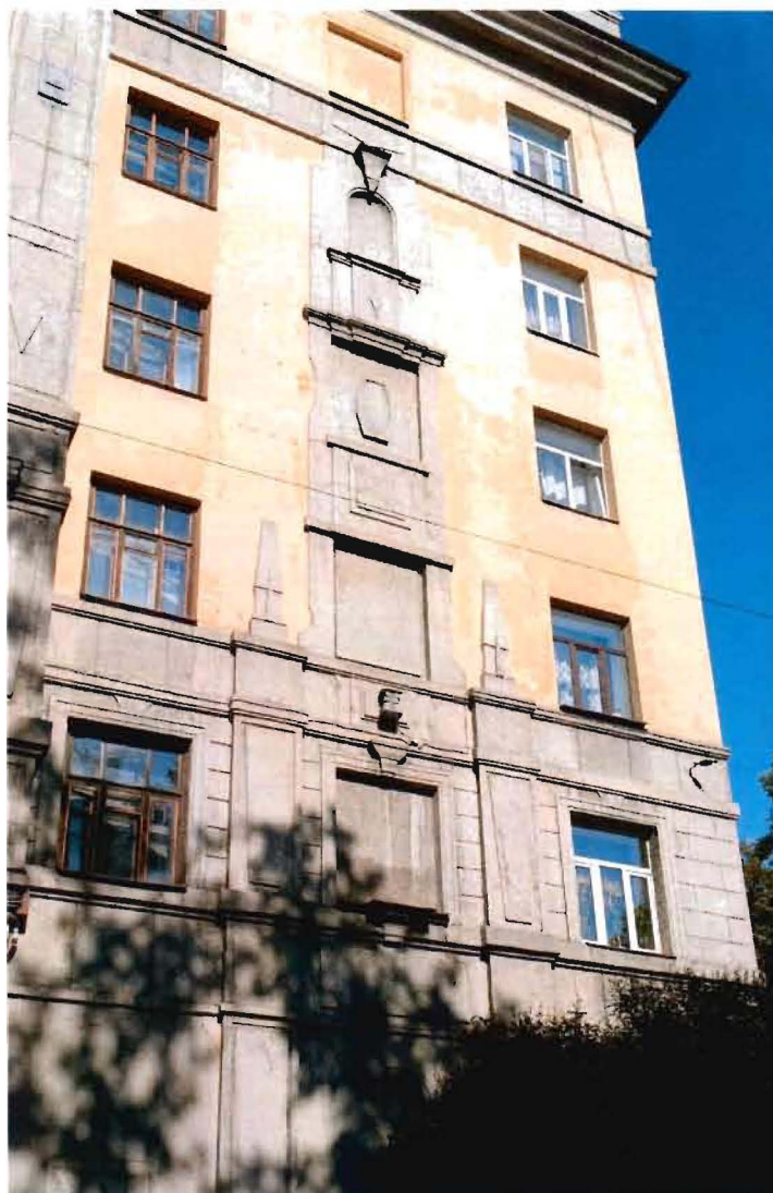
13. Фрагмент. Северный фасад северного флигеля.
