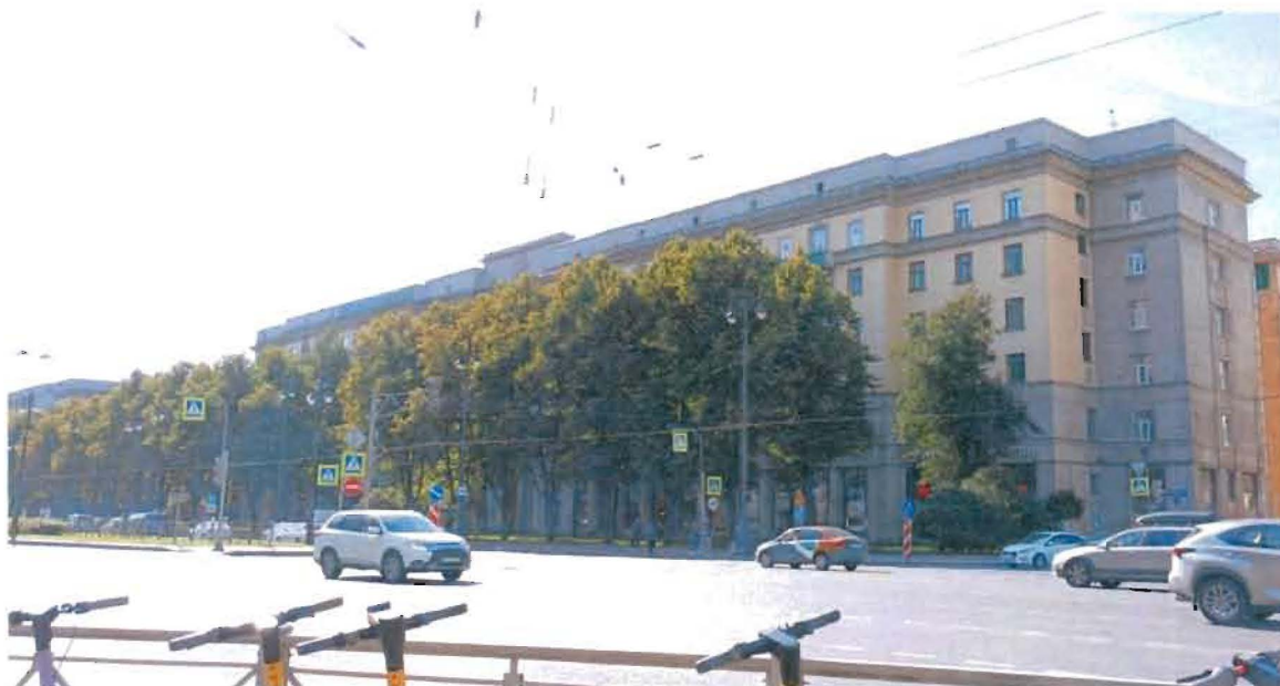
1. Общий вид. Восточный фасад северного флигеля.
