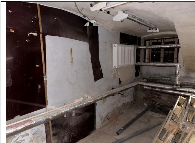
Фото № 11 – Внутреннее состояние помещения
