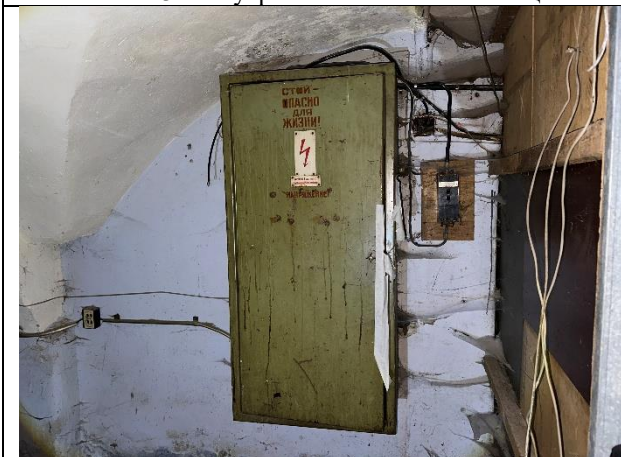
Фото № 25 – Внутреннее состояние помещения
