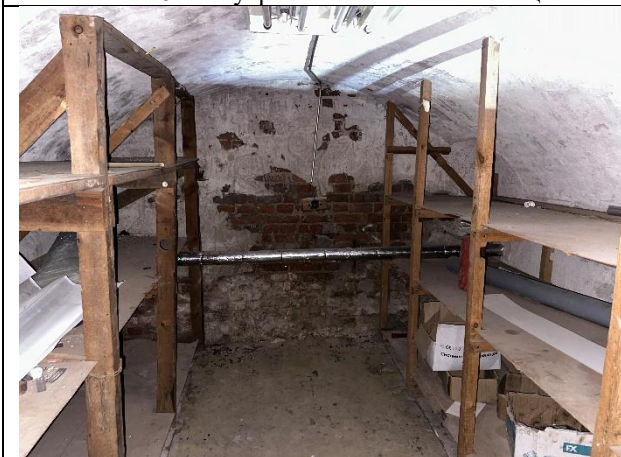
Фото № 17 – Внутреннее состояние помещения
