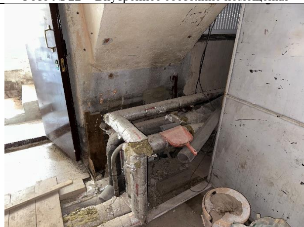
Фото № 24 – Внутреннее состояние помещения
