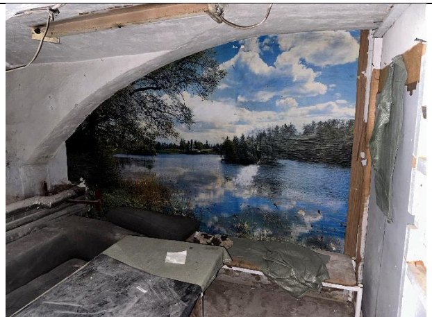
Фото № 12 – Внутреннее состояние помещения
