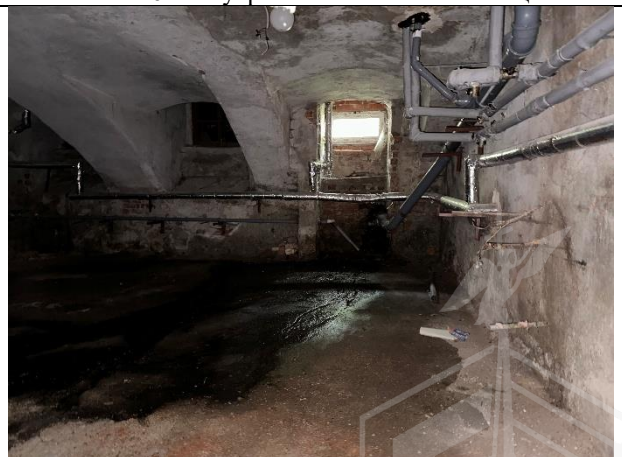
Фото № 18 – Внутреннее состояние помещения
