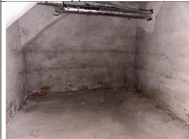
Фото № 21 – Внутреннее состояние помещения
