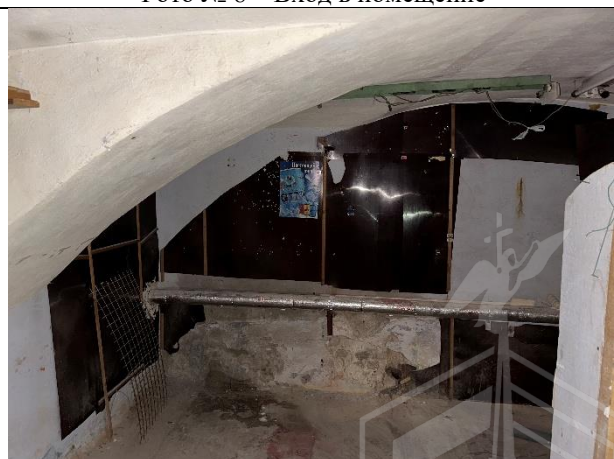
Фото № 10 – Внутреннее состояние помещения
