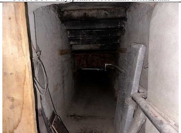
Фото № 16 – Внутреннее состояние помещения
