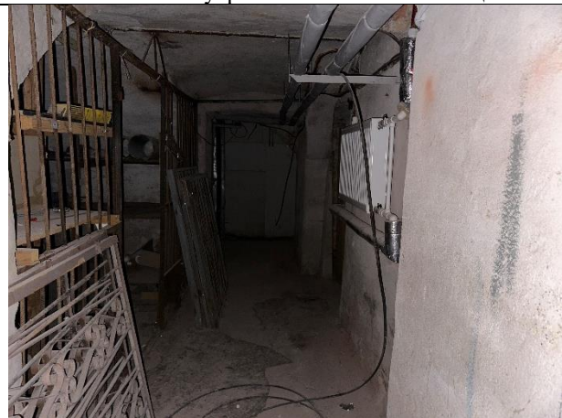
Фото № 22 – Внутреннее состояние помещения
