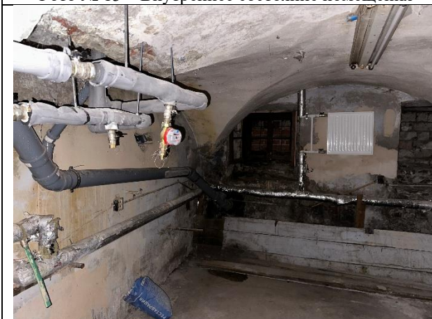
Фото № 15 – Внутреннее состояние помещения
