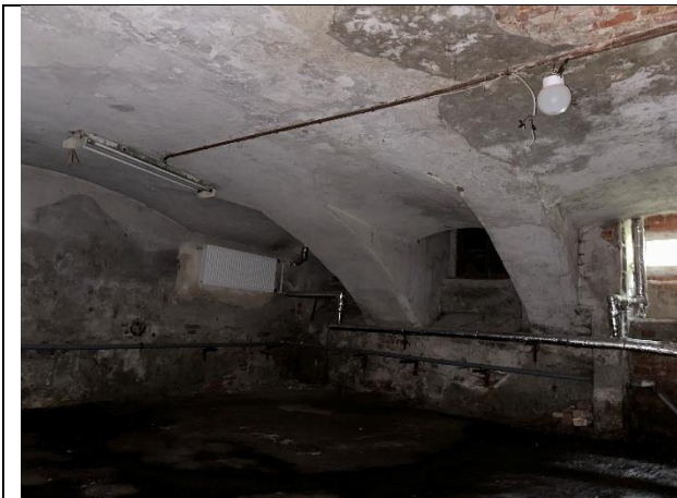
Фото № 19 – Внутреннее состояние помещения
