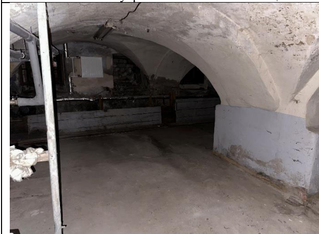
Фото № 13 – Внутреннее состояние помещения
