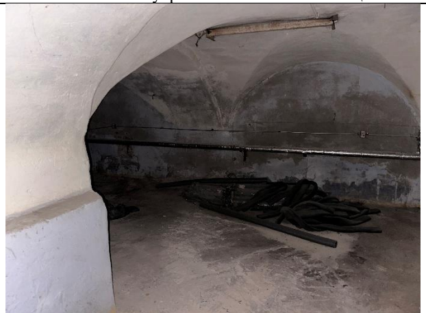
Фото № 14 – Внутреннее состояние помещения
