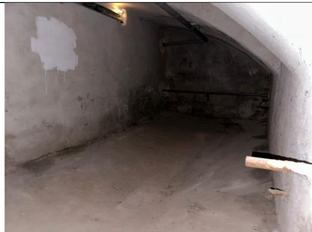
Фото № 20 – Внутреннее состояние помещения
