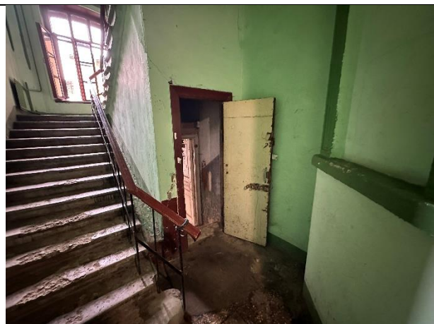
Фото № 8 – Вход в помещение с лестничной клетки
