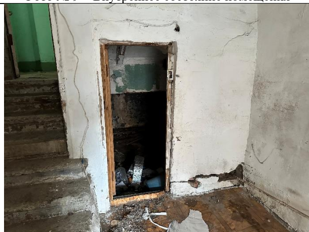
Фото № 11 – Внутреннее состояние помещения
