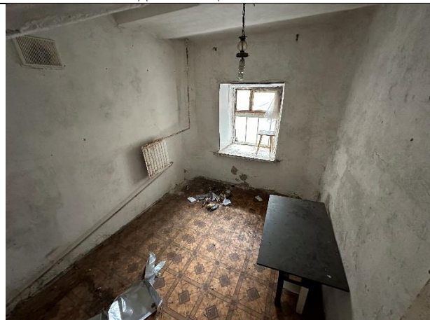
Фото № 10 – Внутреннее состояние помещения
