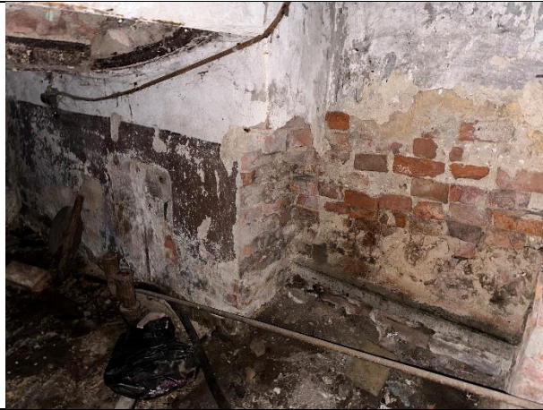
Фото № 15 – Внутреннее состояние помещения
