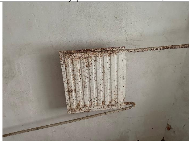
Фото № 13 – Внутреннее состояние помещения
