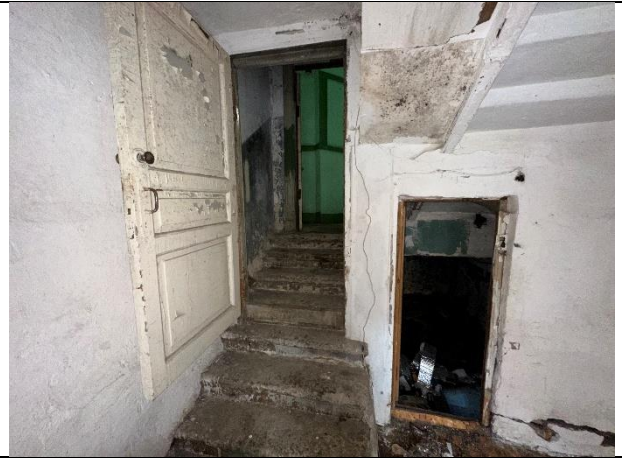
Фото № 16 – Внутреннее состояние помещения
