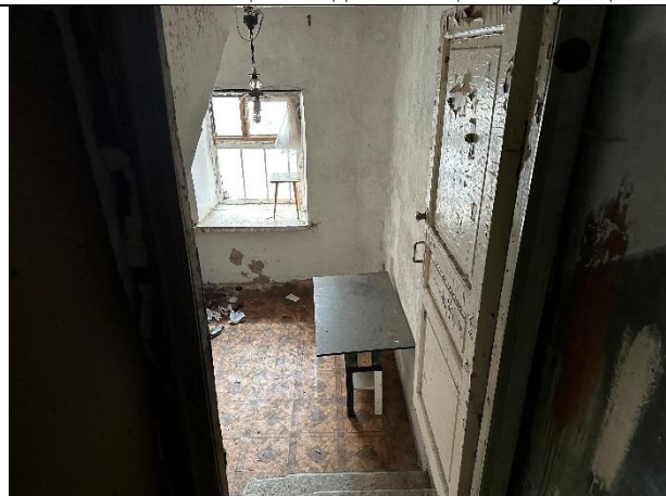
Фото № 9 – Внутреннее состояние помещения
