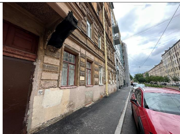
Фото № 4 – Подъездные пути
