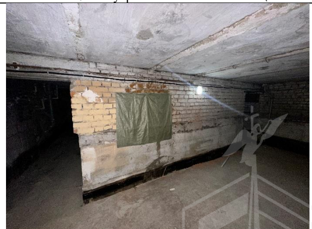
Фото № 12 – Внутреннее состояние помещения
