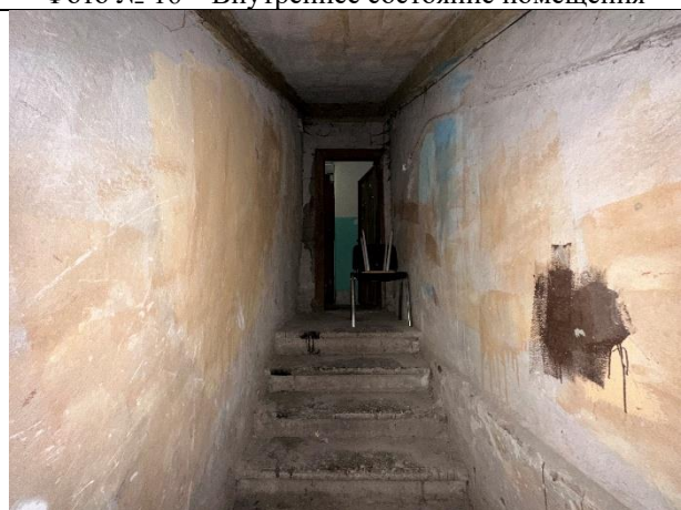
Фото № 18 – Внутреннее состояние помещения
