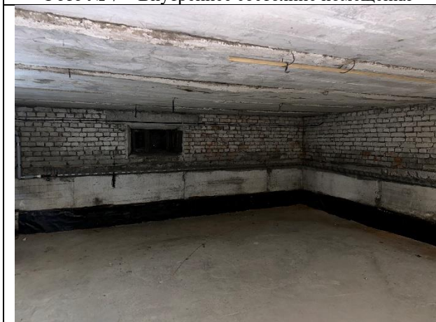
Фото № 9 – Внутреннее состояние помещения
