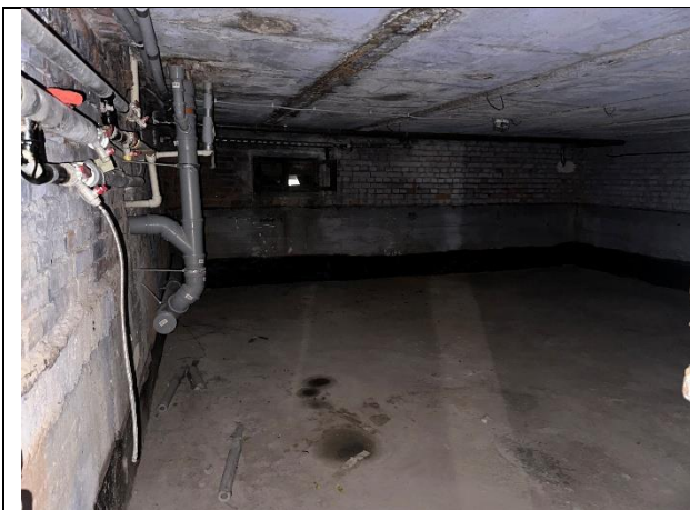
Фото № 13 – Внутреннее состояние помещения
