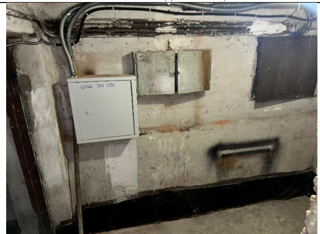
Фото № 8 – Внутреннее состояние помещения
