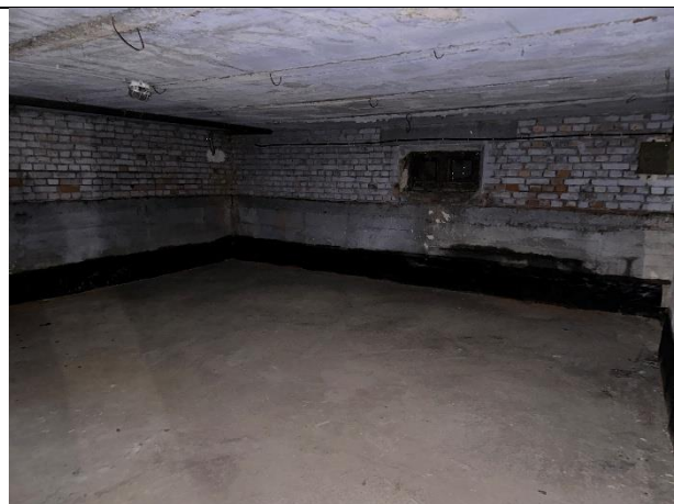
Фото № 14 – Внутреннее состояние помещения
