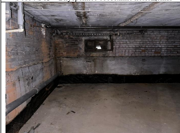
Фото № 15 – Внутреннее состояние помещения
