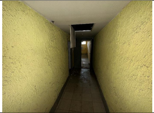
Фото № 32 – Внутреннее состояние помещения
