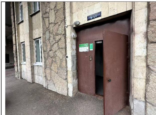
Фото № 7 – Вход общий со двора
