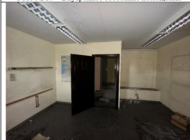
Фото № 19 – Внутреннее состояние помещения
