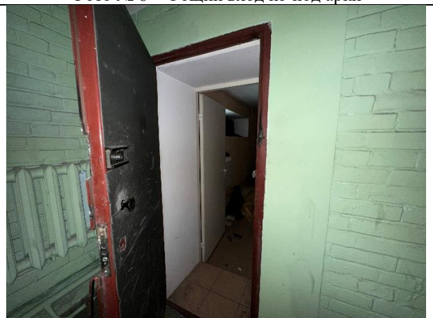
Фото № 10 – Входы в помещение
