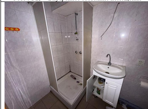
Фото № 25 – Внутреннее состояние помещения
