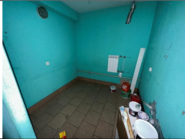
Фото № 31 – Внутреннее состояние помещения
