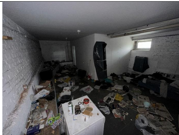
Фото № 16 – Внутреннее состояние помещения
