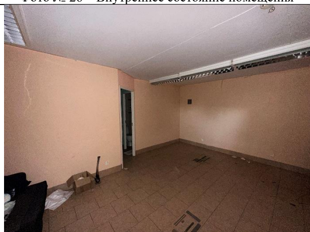
Фото № 28 – Внутреннее состояние помещения
