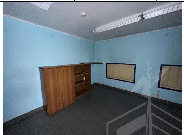
Фото № 38 – Внутреннее состояние помещения
