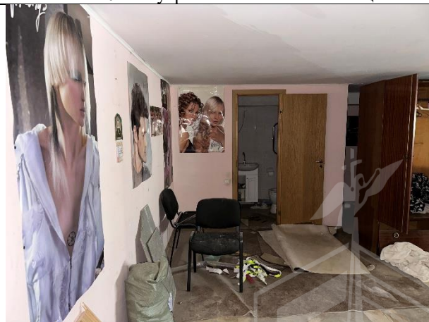
Фото № 22 – Внутреннее состояние помещения
