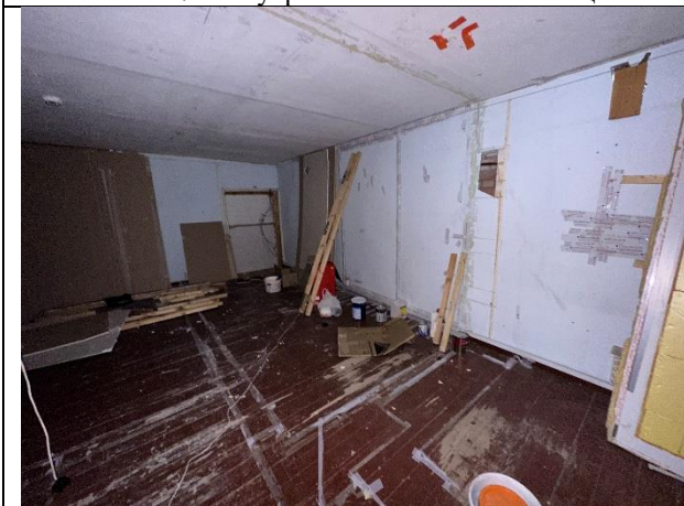
Фото № 29 – Внутреннее состояние помещения
