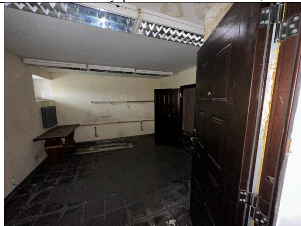
Фото № 18 – Внутреннее состояние помещения
