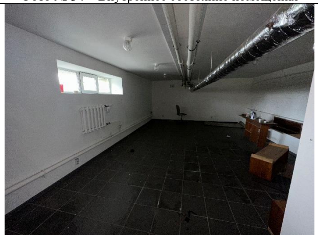
Фото № 36 – Внутреннее состояние помещения
