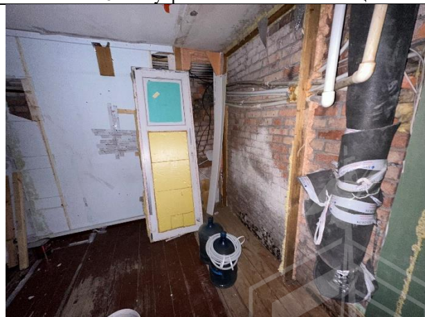
Фото № 30 – Внутреннее состояние помещения
