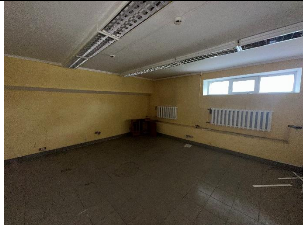
Фото № 33 – Внутреннее состояние помещения
