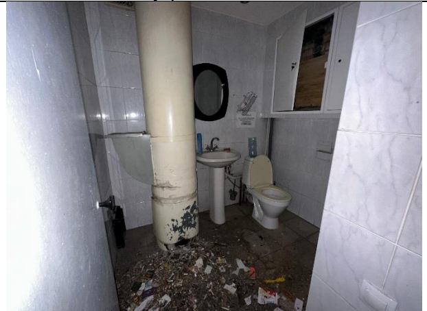
Фото № 34 – Внутреннее состояние помещения
