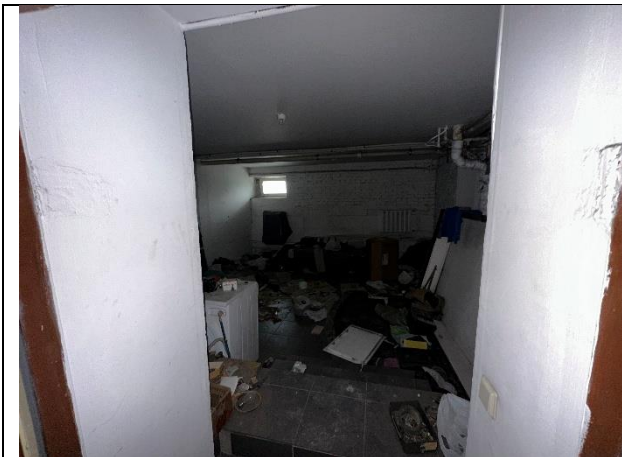
Фото № 15 – Внутреннее состояние помещения
