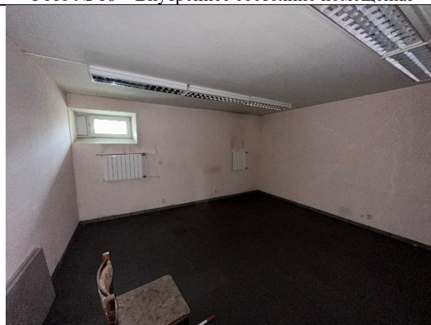
Фото № 20 – Внутреннее состояние помещения
