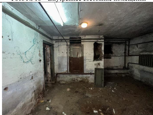
Фото № 12 – Внутреннее состояние помещения
