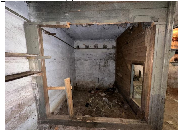
Фото № 9 – Внутреннее состояние помещения
