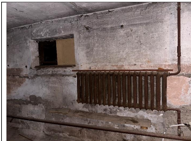
Фото № 15 – Внутреннее состояние помещения
