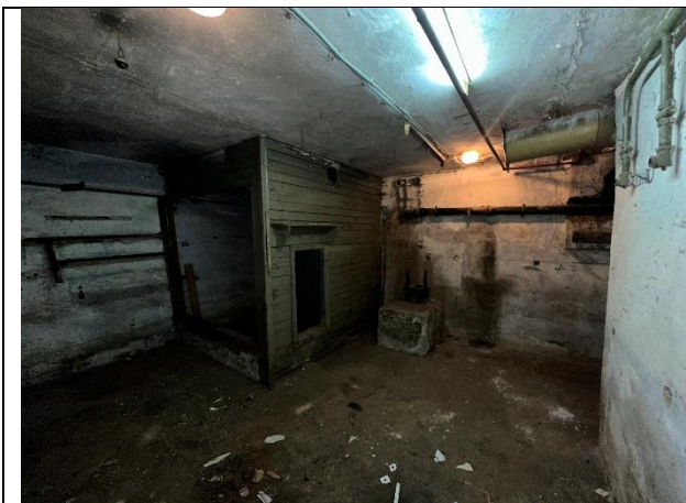
Фото № 7 – Внутреннее состояние помещения
