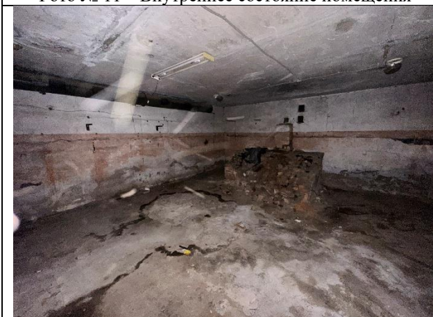
Фото № 13 – Внутреннее состояние помещения
