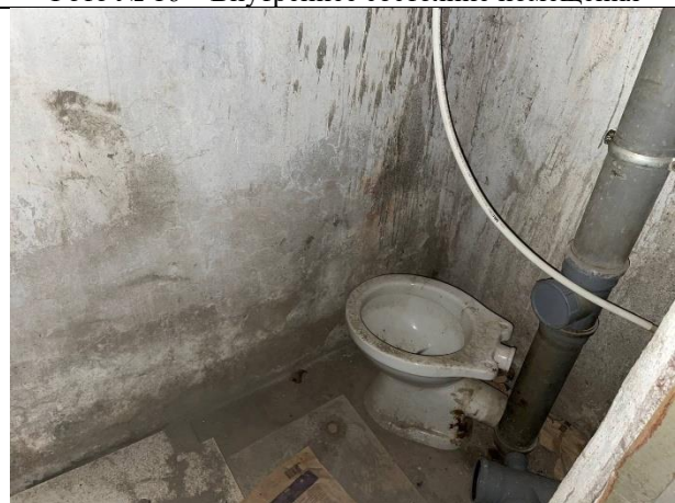
Фото № 18 – Внутреннее состояние помещения
