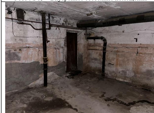
Фото № 17 – Внутреннее состояние помещения
