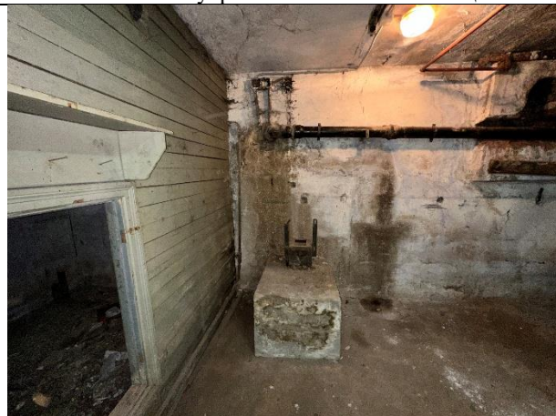
Фото № 10 – Внутреннее состояние помещения
