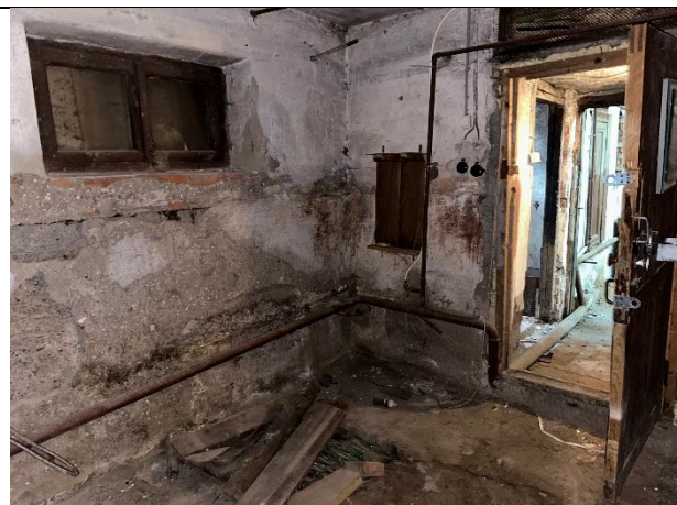
Фото № 16 – Внутреннее состояние помещения
