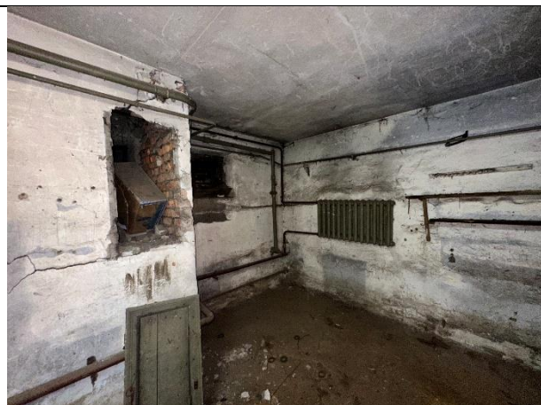
Фото № 8 – Внутреннее состояние помещения
