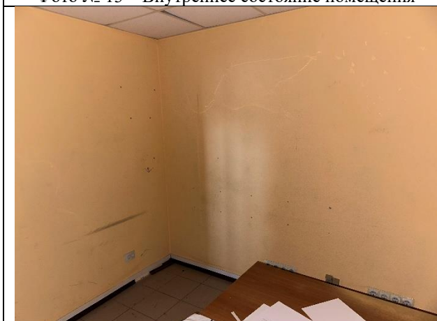
Фото № 15 – Внутреннее состояние помещения
