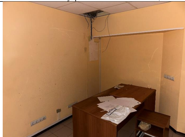
Фото № 14 – Внутреннее состояние помещения
