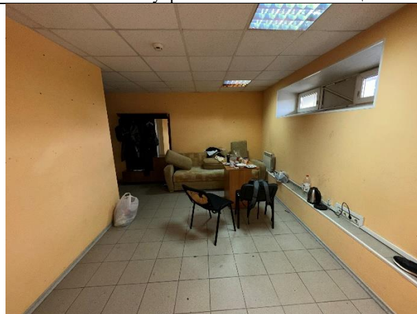
Фото № 22 – Внутреннее состояние помещения
