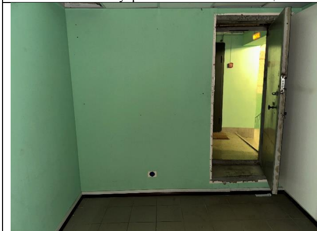
Фото № 13 – Внутреннее состояние помещения
