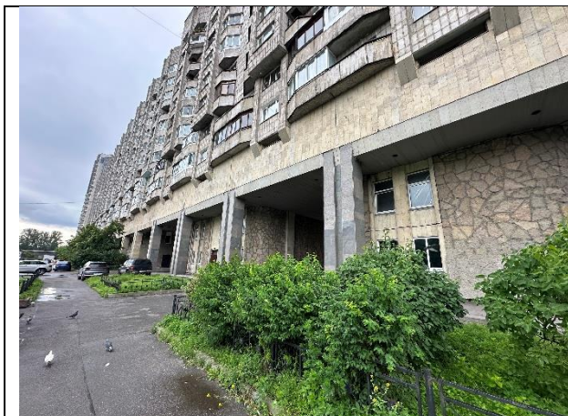
Фото № 3 – Здание, в котором находится Объект оценки
