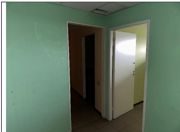
Фото № 11 – Внутреннее состояние помещения
