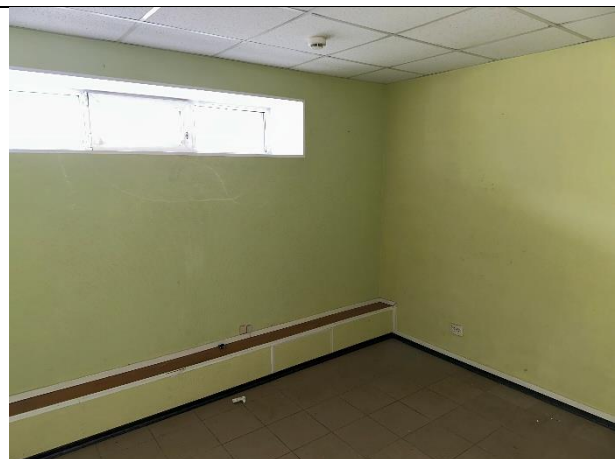
Фото № 12 – Внутреннее состояние помещения
