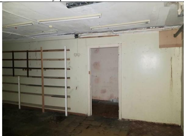
Фото 20. Внутреннее состояние Объекта оценки
