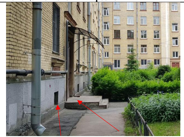
Фото 8. Окно и общий вход со двора
