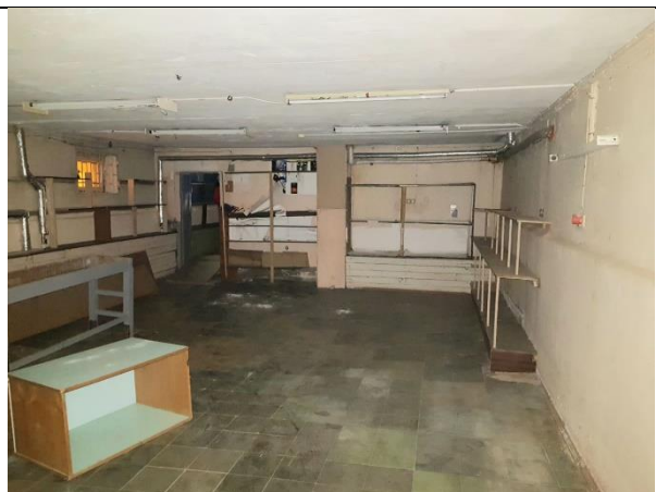
Фото 18. Внутреннее состояние Объекта оценки
