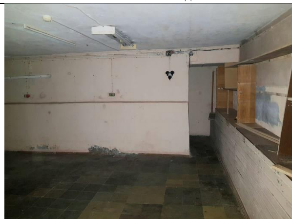
Фото 14. Внутреннее состояние Объекта оценки
