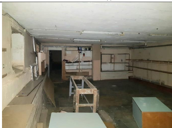
Фото 13. Внутреннее состояние Объекта оценки
