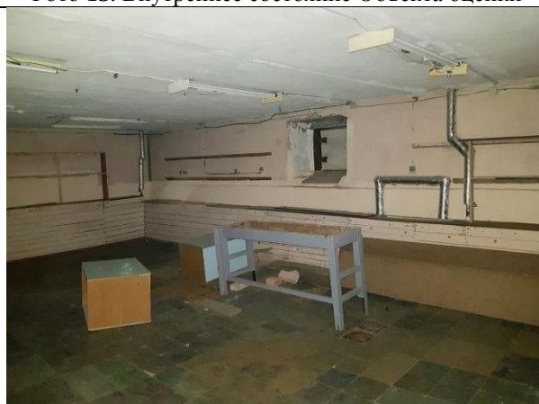
Фото 15. Внутреннее состояние Объекта оценки
