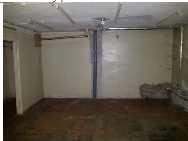
Фото 21. Внутреннее состояние Объекта оценки
