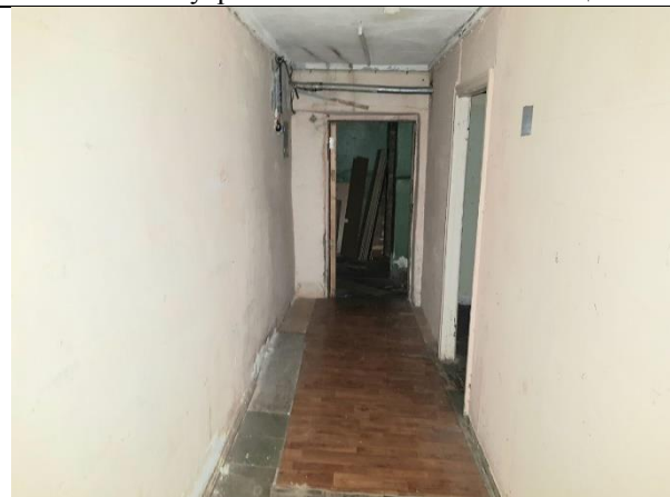
Фото 19. Внутреннее состояние Объекта оценки
