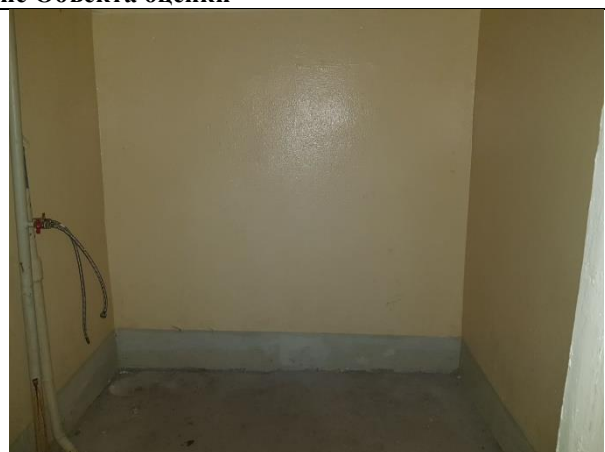
Фото 8. Внутреннее состояние Объекта оценки
