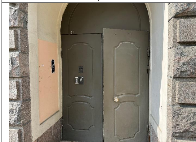
Фото № 5 – Общий вход в помещение
