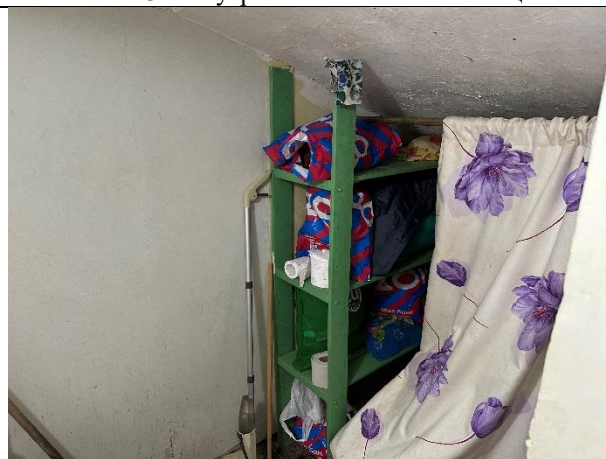
Фото № 10 – Внутреннее состояние помещения
