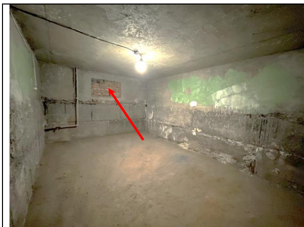
Фото 21. Типичное состояние Объекта оценки (помещение 8-Н)
