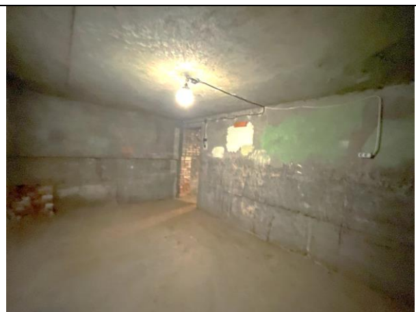
Фото 22. Типичное состояние Объекта оценки (помещение 8-Н)
