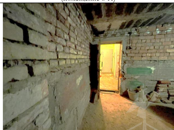
Фото 20. Типичное состояние Объекта оценки (помещение 8-Н)
