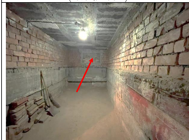
Фото 23. Оконная группа Объекта оценки (помещение 8-Н)
