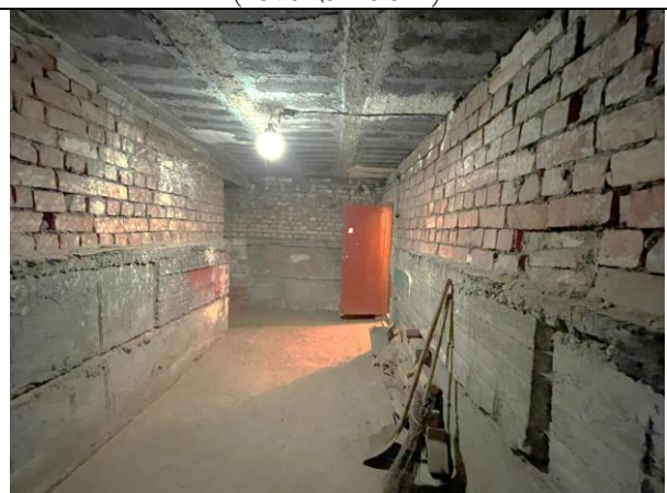
Фото 24. Типичное состояние Объекта оценки (помещение 8-Н)
