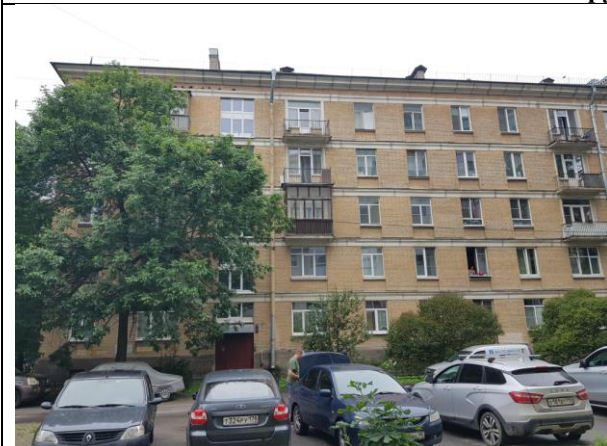
Фото 1. Вид здания, в котором расположен Объект оценки
