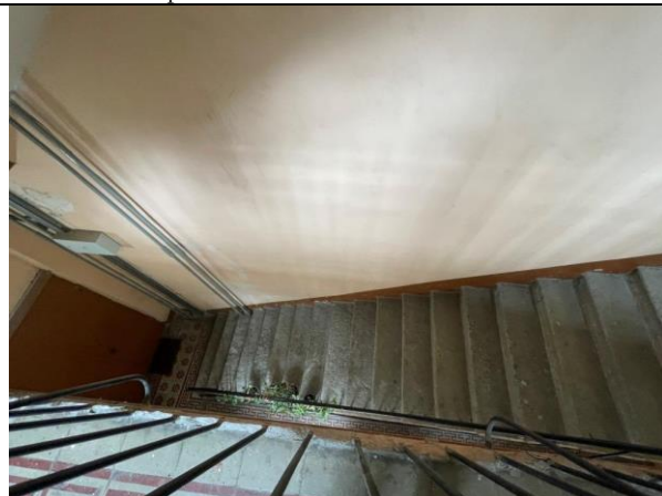
Фото 19. Лестничный проём здания, в котором расположен Объект оценки
