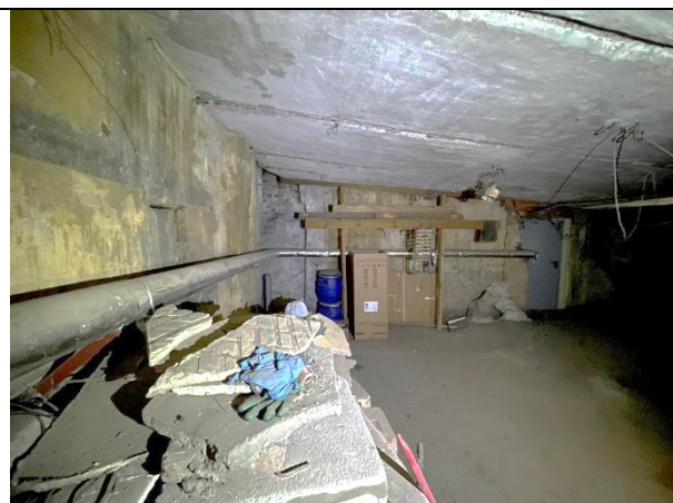
Фото 26. Типичное состояние Объекта оценки
