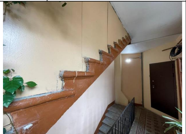
Фото 20. Лестничный проём здания, в котором расположен Объект оценки
