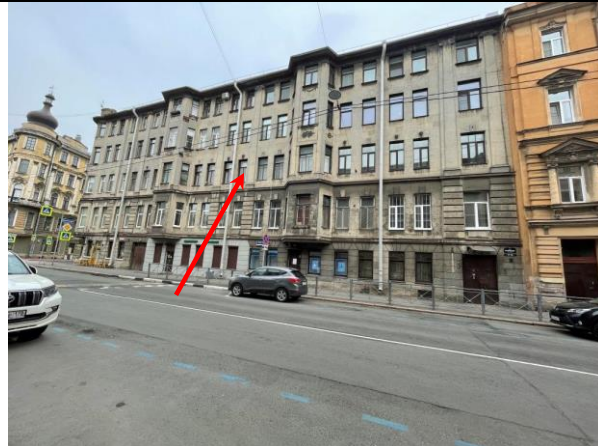
Фото 11. Вид здания Объекта оценки
