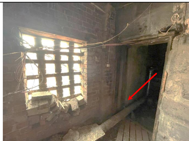
Фото 28. Типичное состояние Объекта оценки (проход на чердак)
