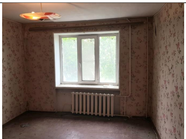
Фото 16. Внутреннее состояние Объекта оценки
