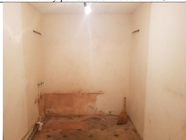
Фото 14. Внутреннее состояние Объекта оценки
