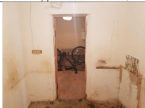
Фото 13. Внутреннее состояние Объекта оценки
