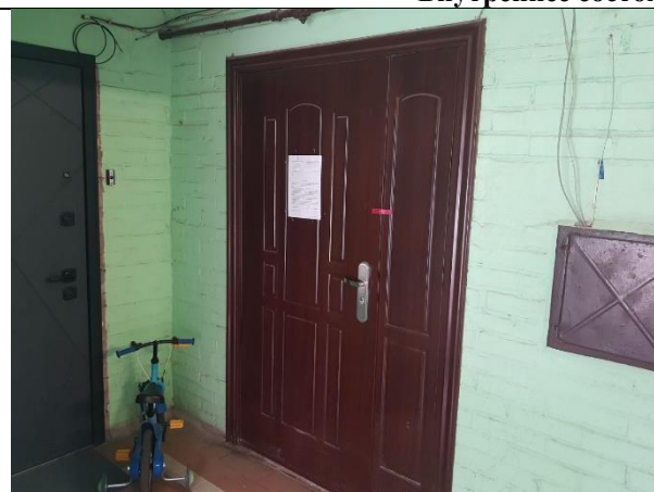
Фото 9. Внутреннее состояние Объекта оценки
