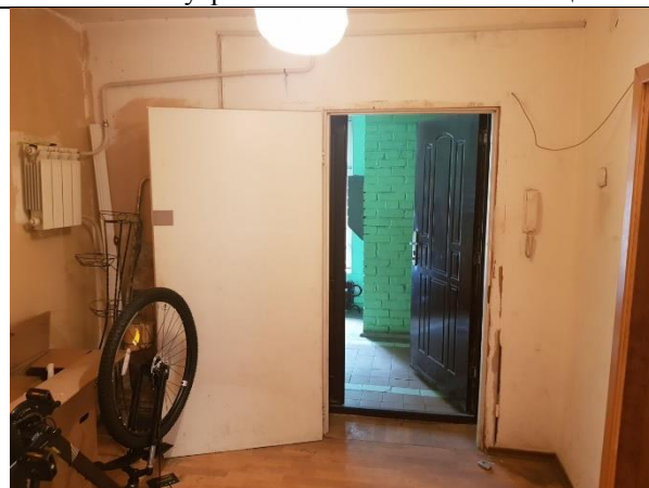
Фото 12. Внутреннее состояние Объекта оценки
