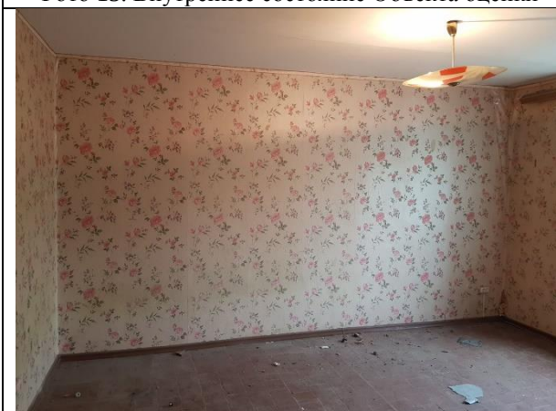
Фото 17. Внутреннее состояние Объекта оценки
