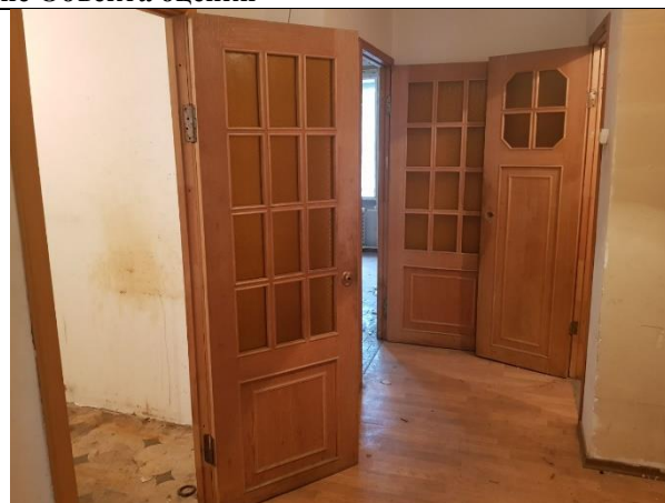
Фото 10. Внутреннее состояние Объекта оценки
