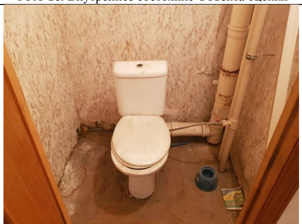
Фото 18. Внутреннее состояние Объекта оценки
