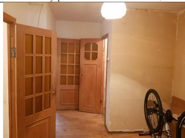
Фото 11. Внутреннее состояние Объекта оценки
