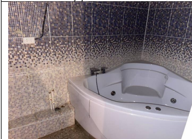
Фото № 15 – Внутреннее состояние помещения
