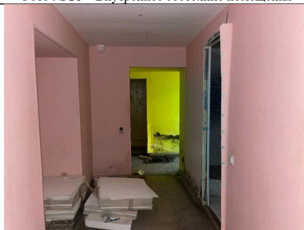
Фото № 32 – Внутреннее состояние помещения
