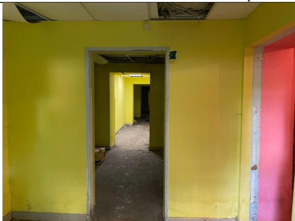
Фото № 11 – Внутреннее состояние помещения
