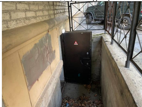
Фото № 10 – Вход в помещение со двора
