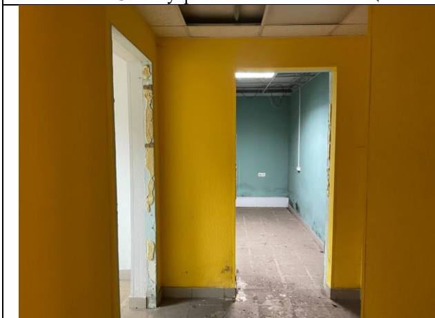
Фото № 17 – Внутреннее состояние помещения
