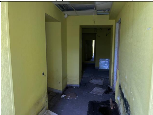
Фото № 27 – Внутреннее состояние помещения
