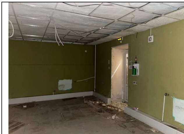
Фото № 29 – Внутреннее состояние помещения
