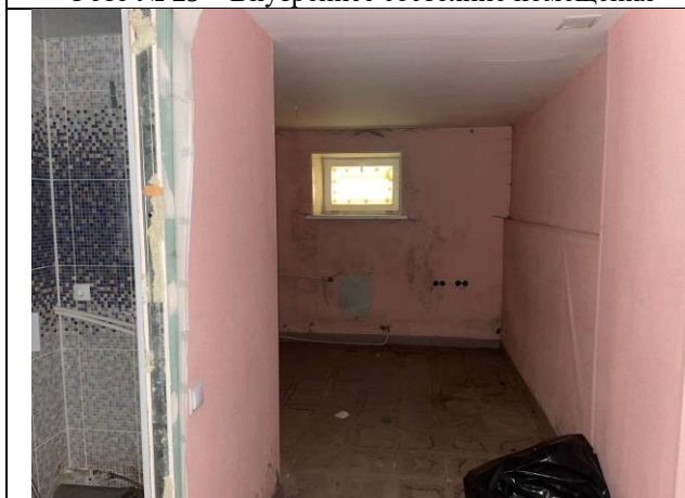
Фото № 31 – Внутреннее состояние помещения
