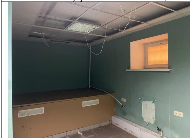
Фото № 19 – Внутреннее состояние помещения
