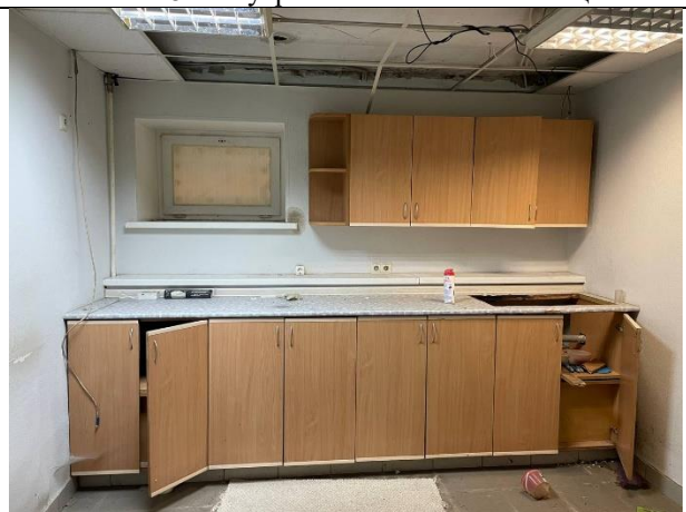
Фото № 18 – Внутреннее состояние помещения
