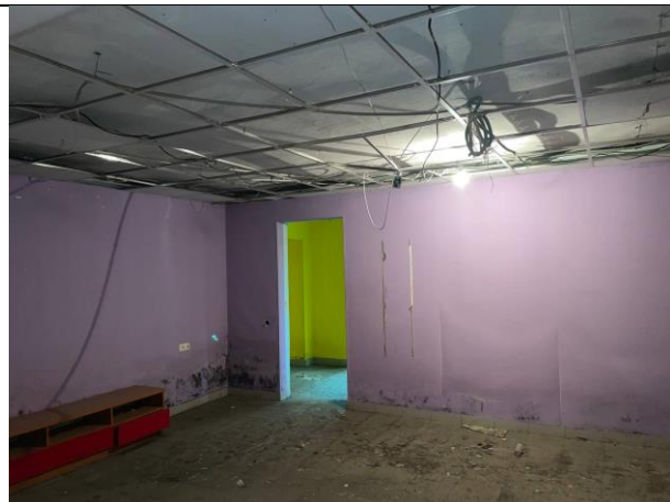
Фото № 22 – Внутреннее состояние помещения
