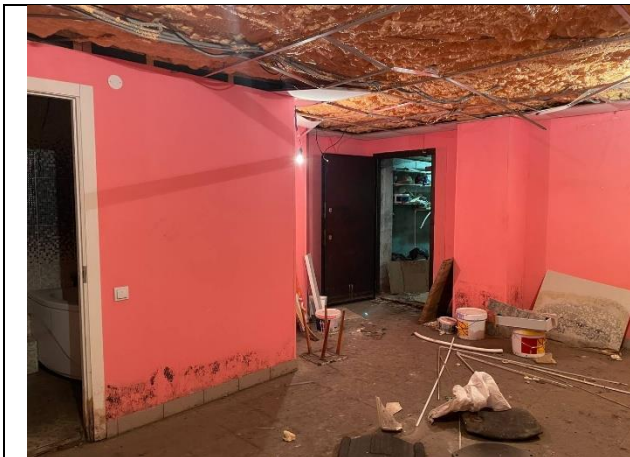
Фото № 13 – Внутреннее состояние помещения
