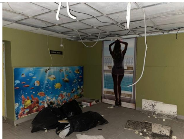
Фото № 30 – Внутреннее состояние помещения
