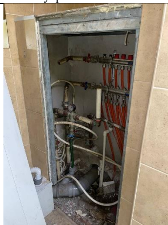
Фото № 26 – Внутреннее состояние помещения
