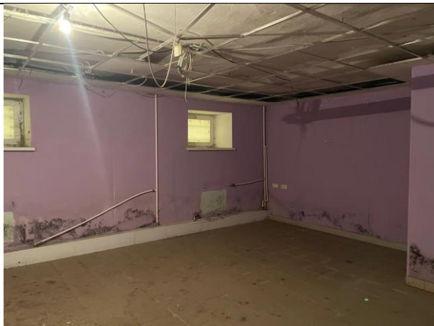
Фото № 21 – Внутреннее состояние помещения
