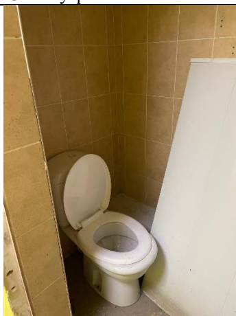
Фото № 25 – Внутреннее состояние помещения
