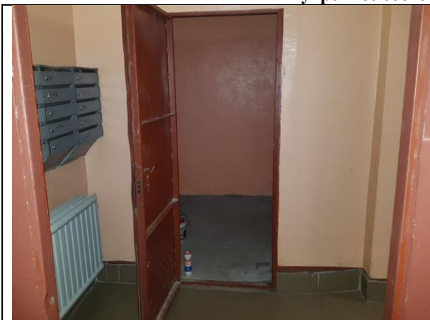
Фото 7. Внутреннее состояние Объекта оценки
