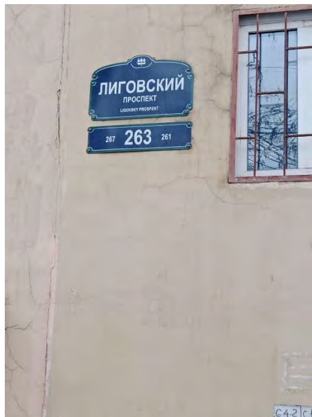
Вход в помещение
