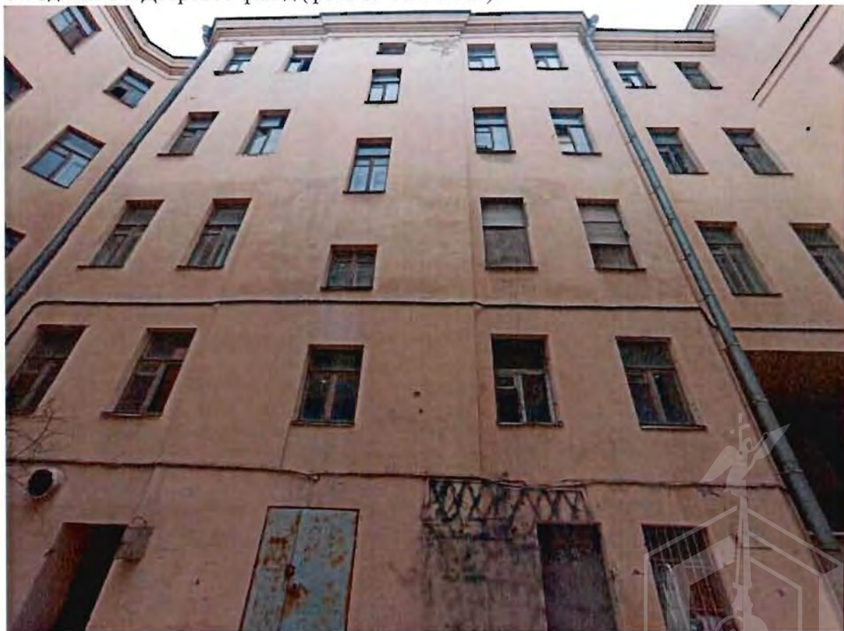
14. Здание 14. Дворовой фасад (фото от 24.03.2023).
