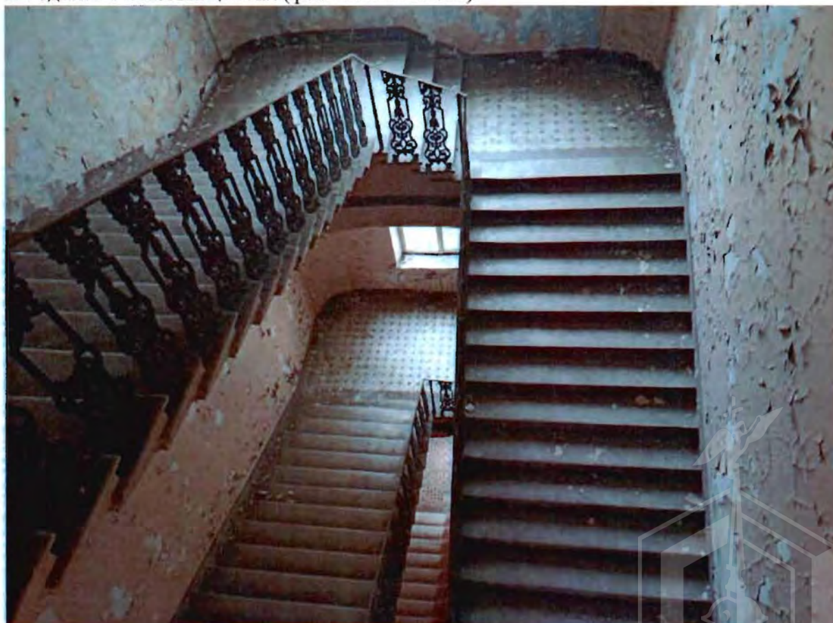
22. Здание 14. Лестница 5ЛК (фото от 24.03.2023).
