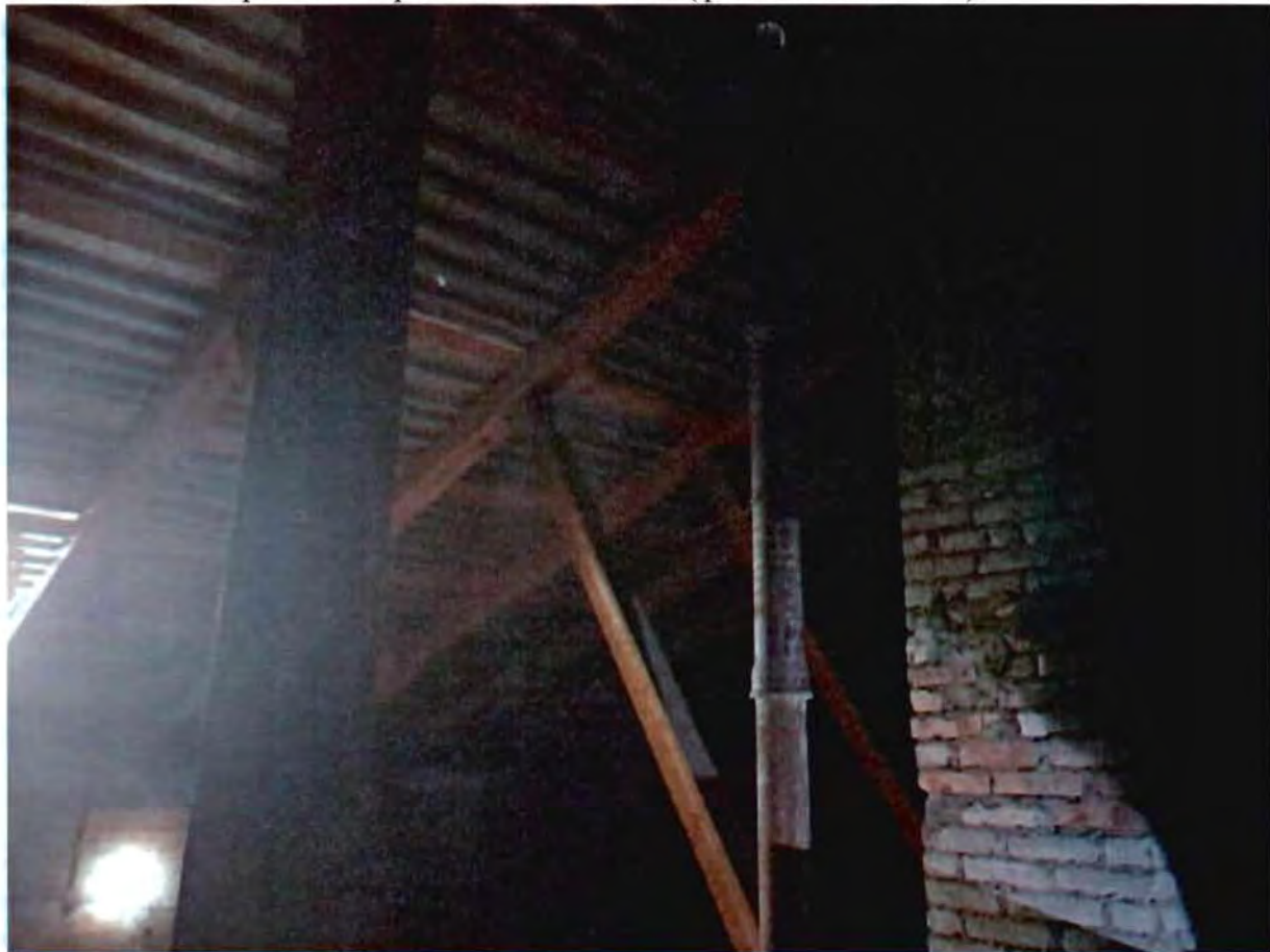
37. Здание 14. Фрагмент стропильной системы (фото от 24.03.2023).
