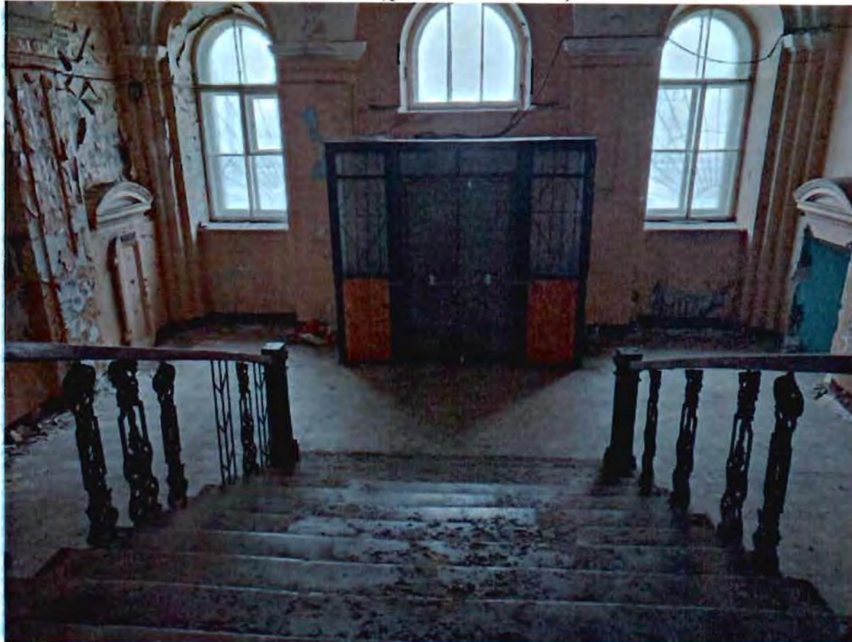
21. Здание 14.Парадная лестница 6ЛК (фото от 24.03.2023).
