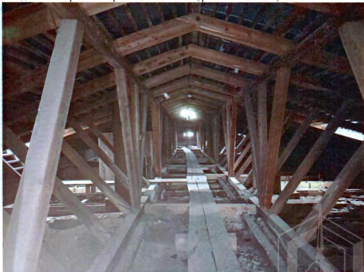
36. Здание 14. Фрагмент стропильной системы (фото от 24.03.2023).
