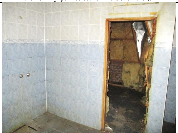
Фото 18. Внутреннее состояние Объекта оценки
