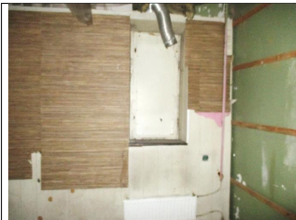
Фото 15. Внутреннее состояние Объекта оценки
