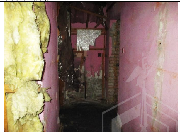
Фото 14. Внутреннее состояние Объекта оценки
