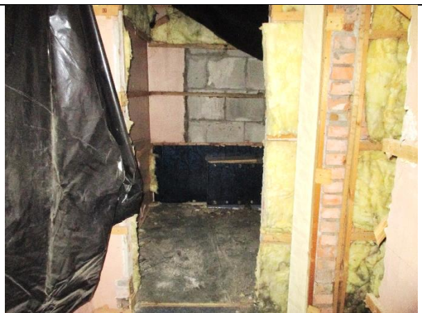
Фото 16. Внутреннее состояние Объекта оценки
