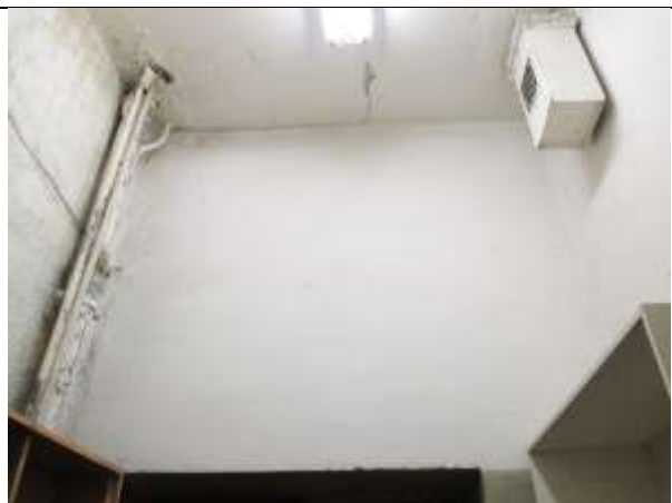
Фото 10. Внутреннее состояние Объекта оценки
