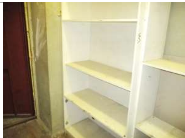
Фото 9. Внутреннее состояние Объекта оценки
