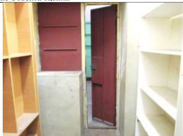
Фото 8. Внутреннее состояние Объекта оценки
