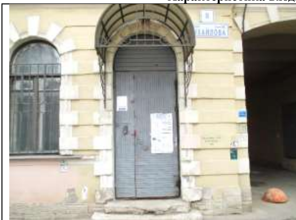
Фото 5. Общий вход с улицы
