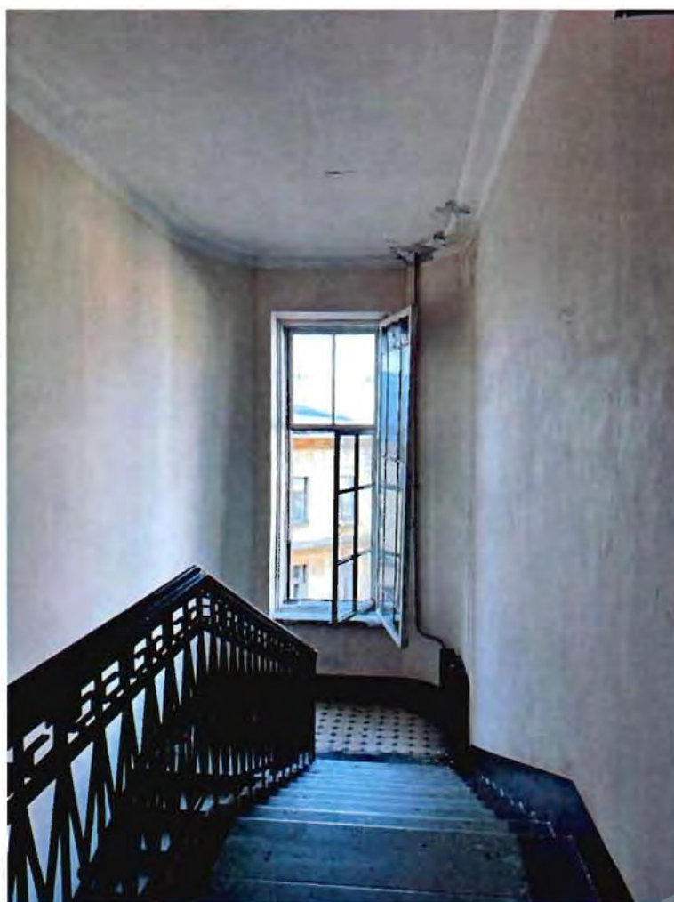
8. Лестница 2ЛК объекта культурного наследия.
