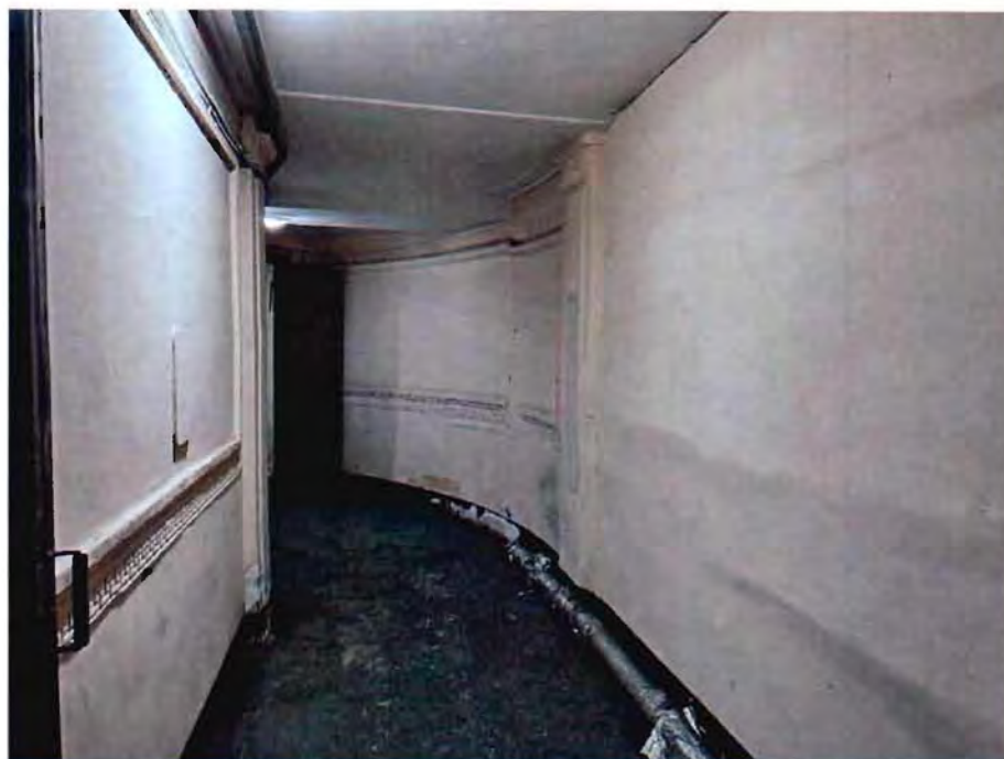
7. Помещение 2ЛК объекта культурного наследия.
