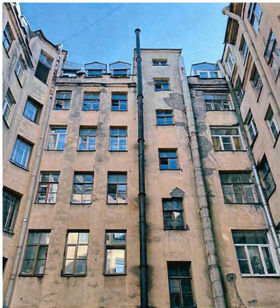
4. Дворовые фасады объекта культурного наследия.
