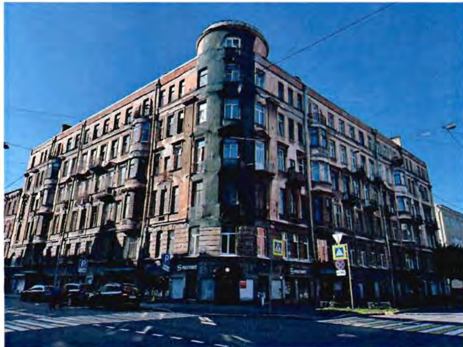
1. Общий вид на объект культурного наследия.
