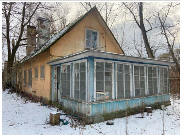
Фото № 7. Внешний вид здания литера Б
