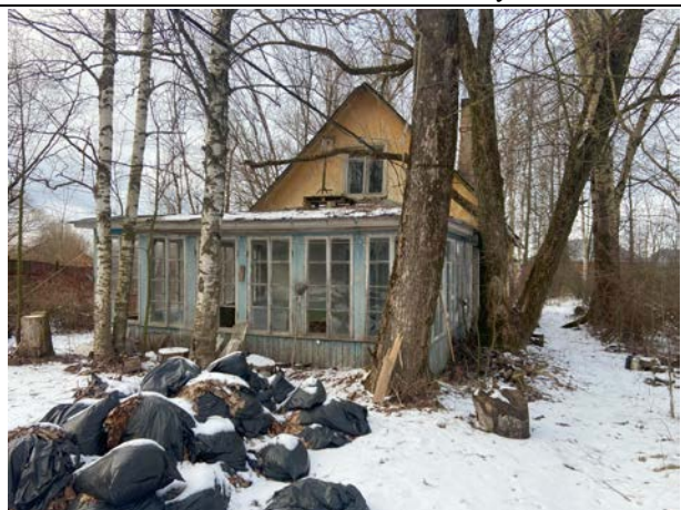
Фото № 6. Внешний вид здания литера А
