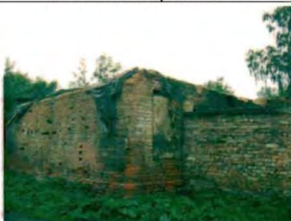
Фото 187. Северный фасад. Общий вид.
