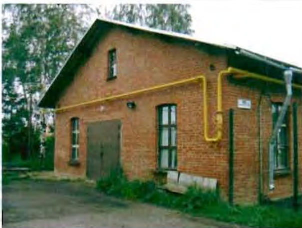
Фото 20. Северный фасад. Общий вид.
