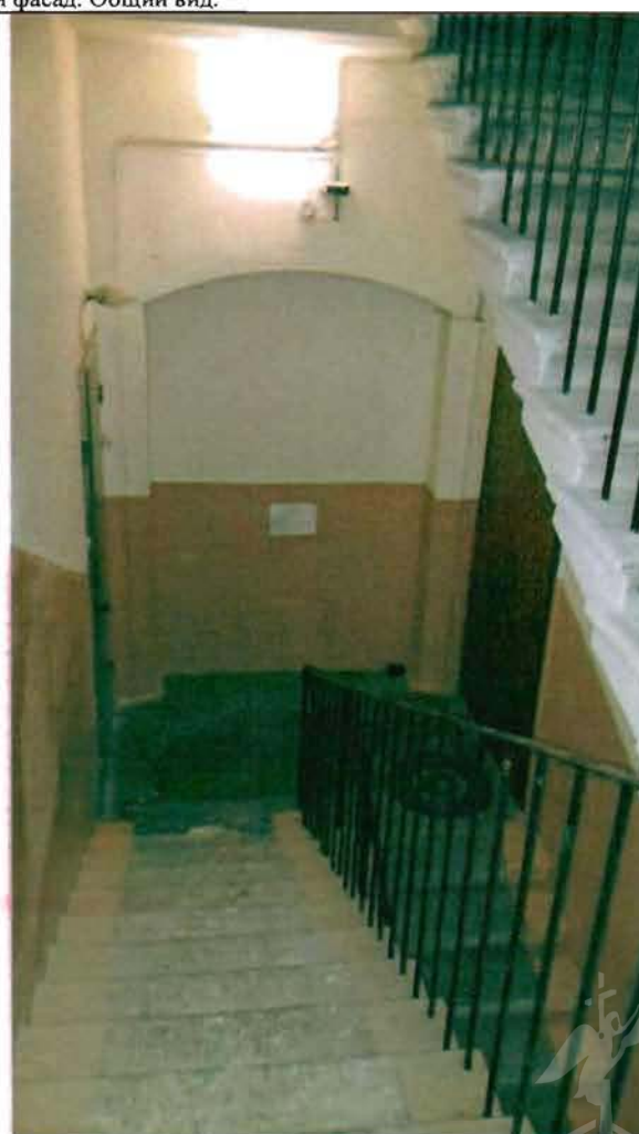
Фото 173. Лестница № 1 в северной части здания. Фрагмент.
