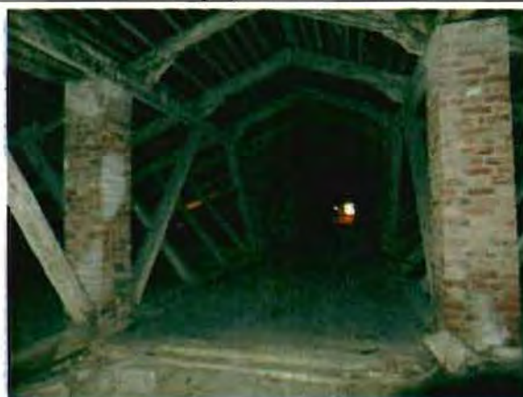
Фото 12. Конструкции крыши. Общий вид. 29.12.2015.
