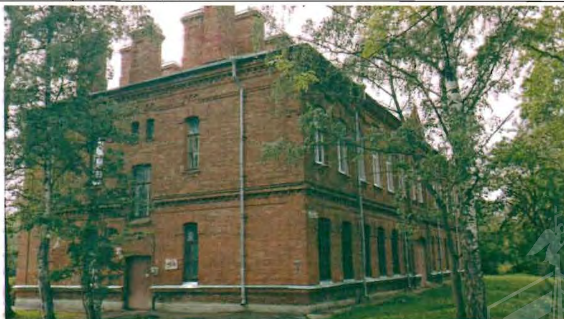
Фото 170. Северный, западный фасады. Общий вид.
