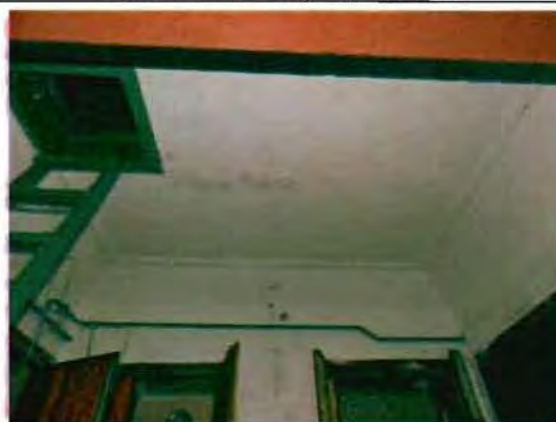
Фото 102. Отделка потолка тамбура. Общий вид.
