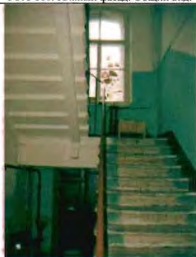
Фото 168. Лестница в южной части здания. Общий вид.
