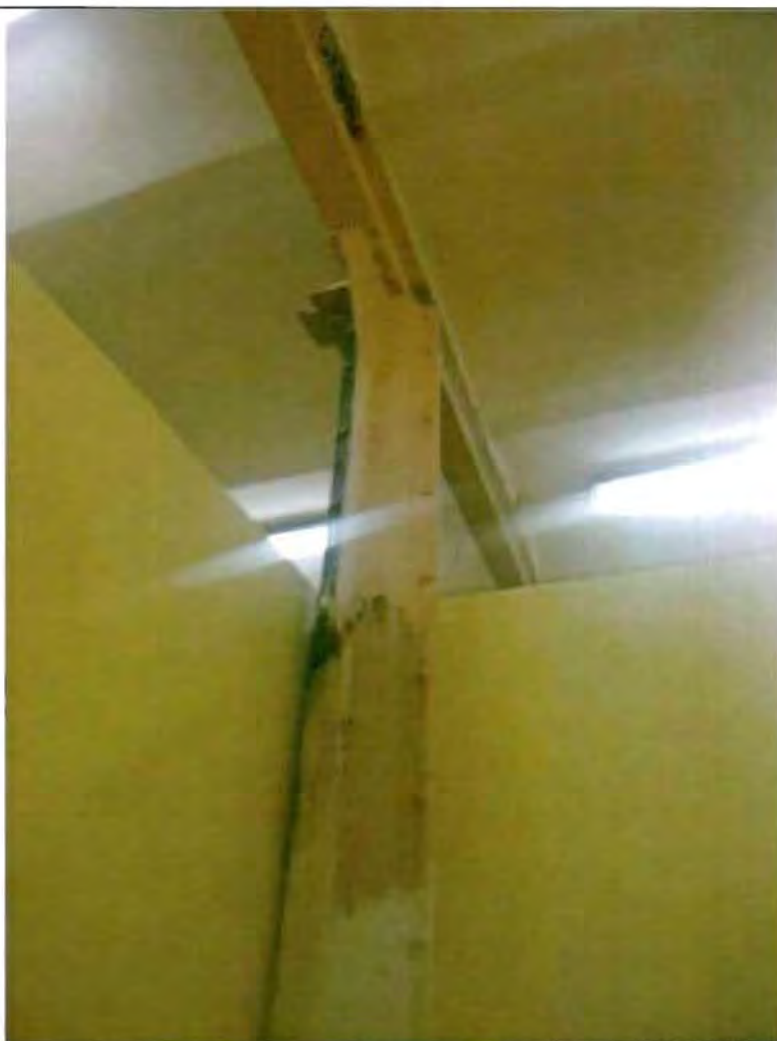
Металлические клёпанные колонны и балки, кирпичные своды. Съёмка 20.11.2012, Воронина Н.В.
