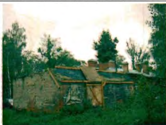
Фото 186. Западный, северный фасады. Общий вид.
