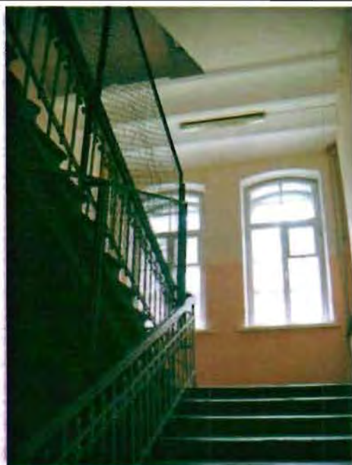
Фото 56. Лестница в центральной части здания. Фрагмент.
