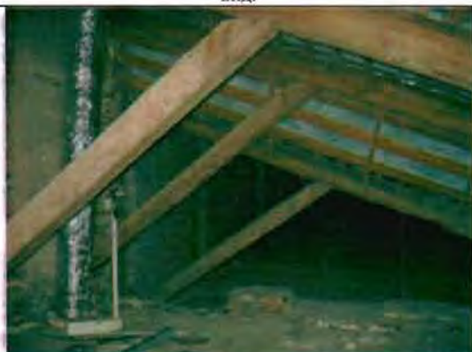
Фото 76. Конструкции крыши. Общий вид.
