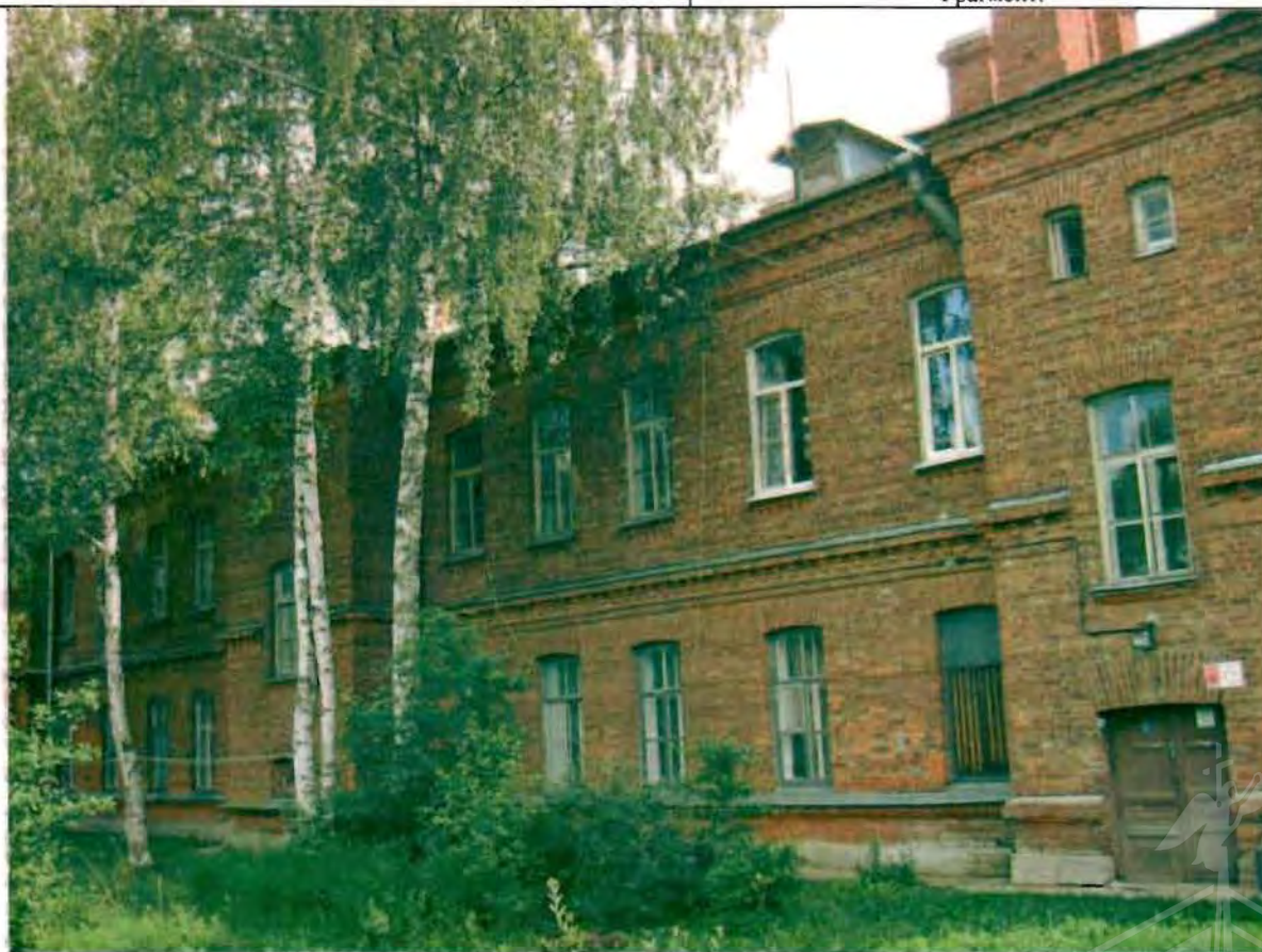
Фото 179. Западный фасад. Общий вид.
