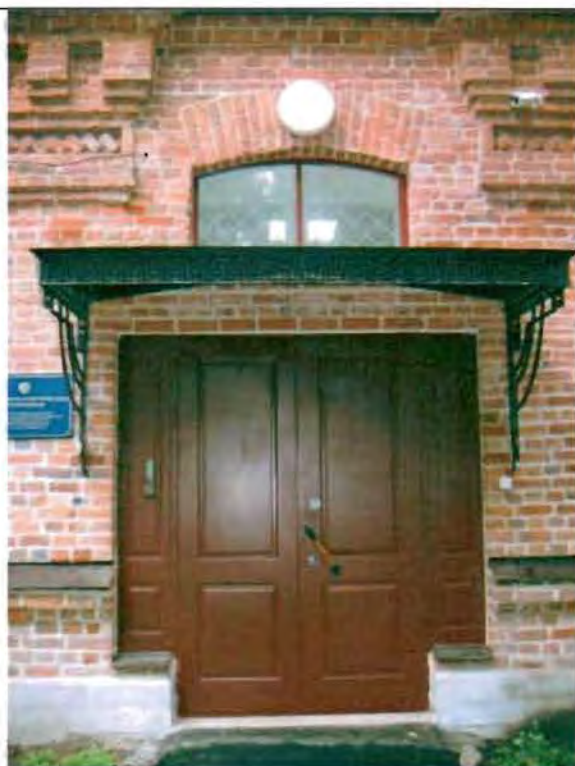
Фото 41. Дверной проем восточного фасада. Общий вид.
