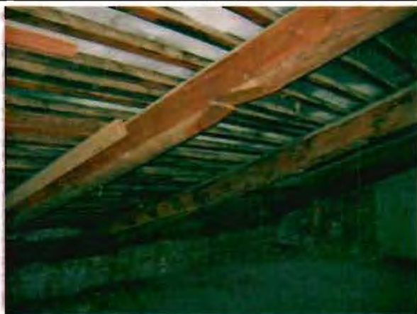
Фото 151. Конструкции крыши. Фрагмент.
