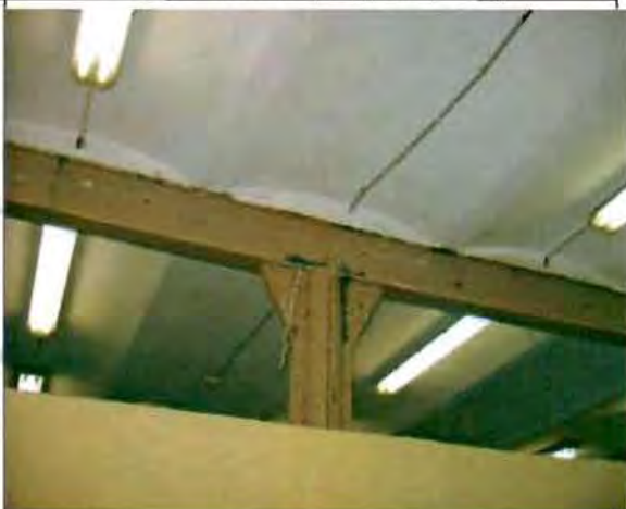
Фото 23. Интерьер. Металлические клепанные колонны и балки. Фрагмент.
