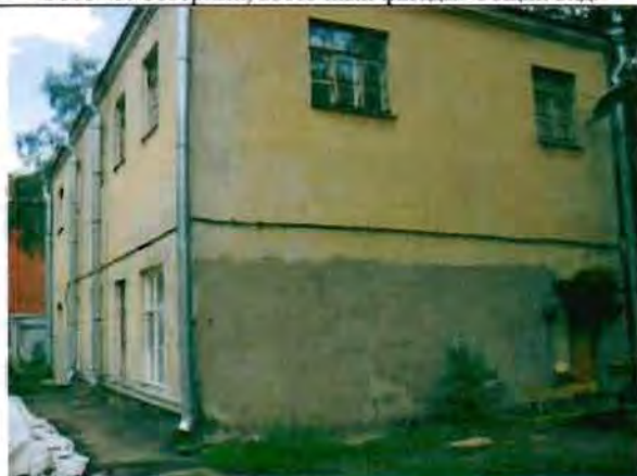
Фото 45. Южный, западный фасад. Общий вид.
