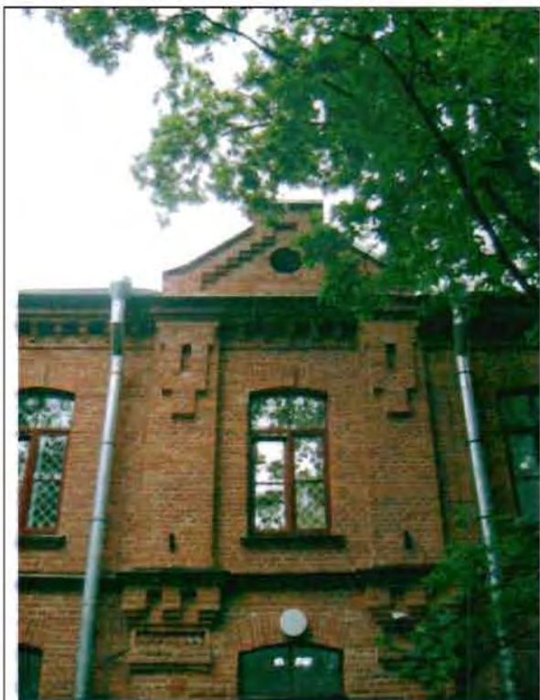
Фото 40. Восточный фасад. Фрагмент центральной части фасада.
