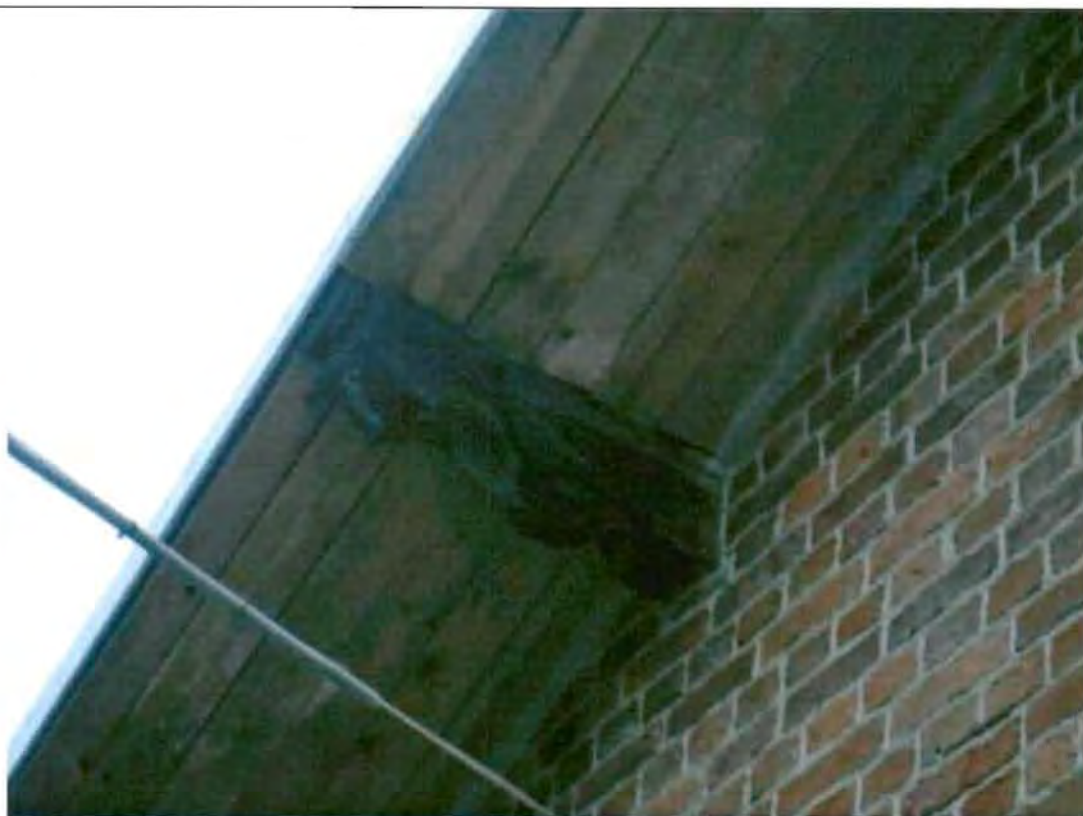
Деревянные кобылки. Съёмка 20.11.2012, Воронина Н.В.
