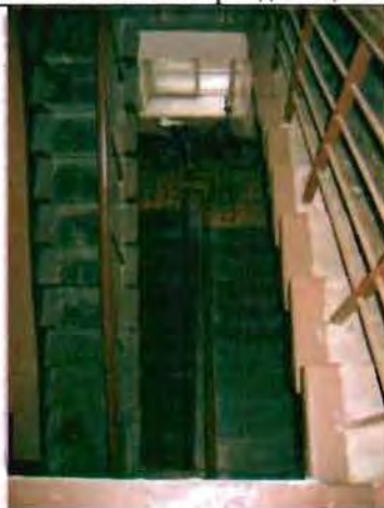
Фото 87. Лестница № 1. Общий вид.
