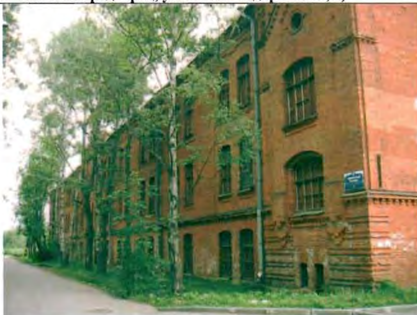
Фото 1. Западный фасад. Общий вид.
