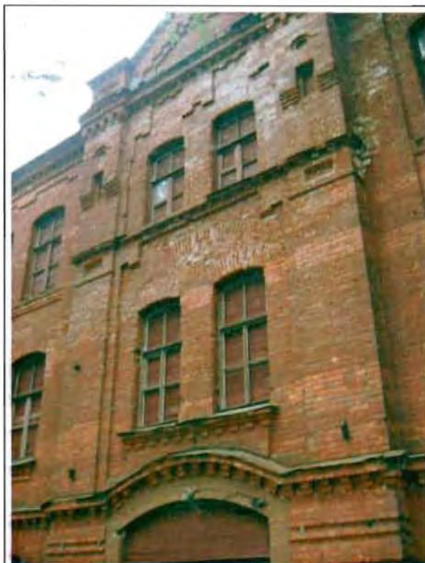
Фото 3. Западный фасад. Фрагмент центральной части фасада.
