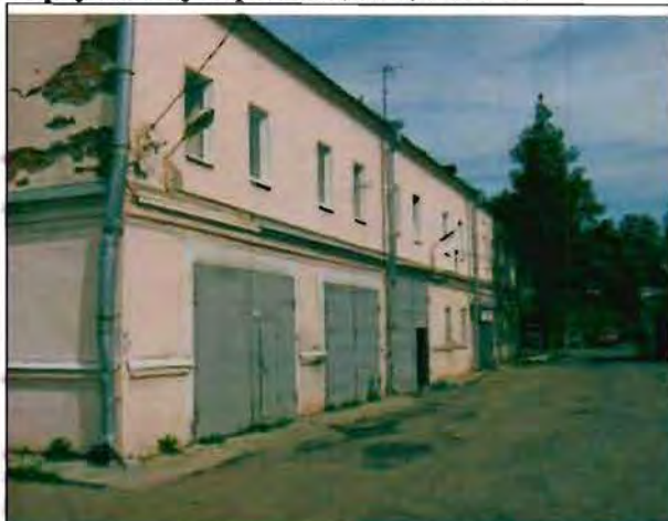
Фото 110. Восточный фасад. Общий вид.
