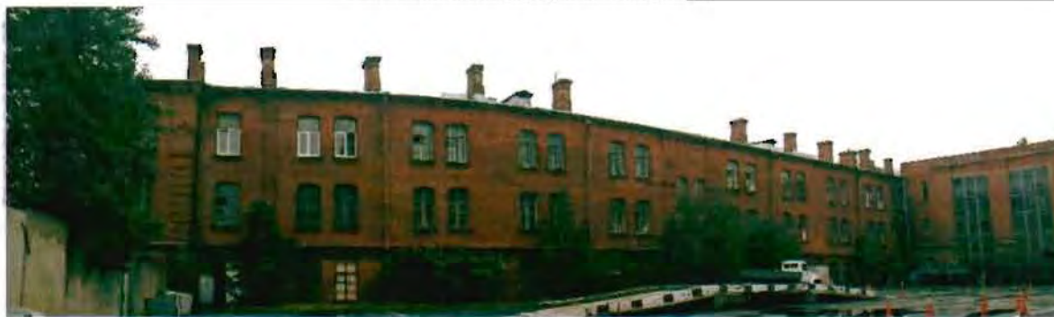
Фото 29. Западный фасад. Общий вид.
