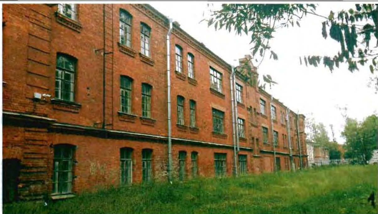
Фото 48. Западный фасад. Общий вид.
