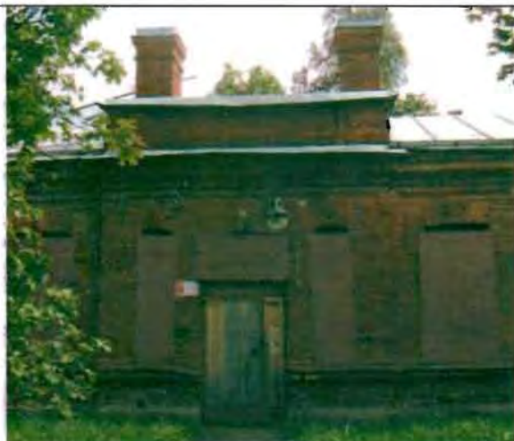
Фото 99. Западный фасад. Центральная часть. Общий вид.
