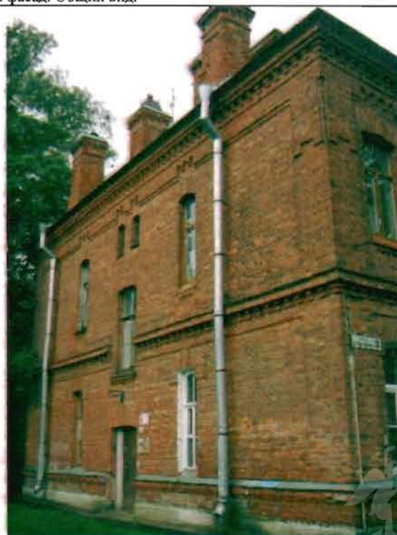
Фото 148. Северный фасад. Общий вид.
