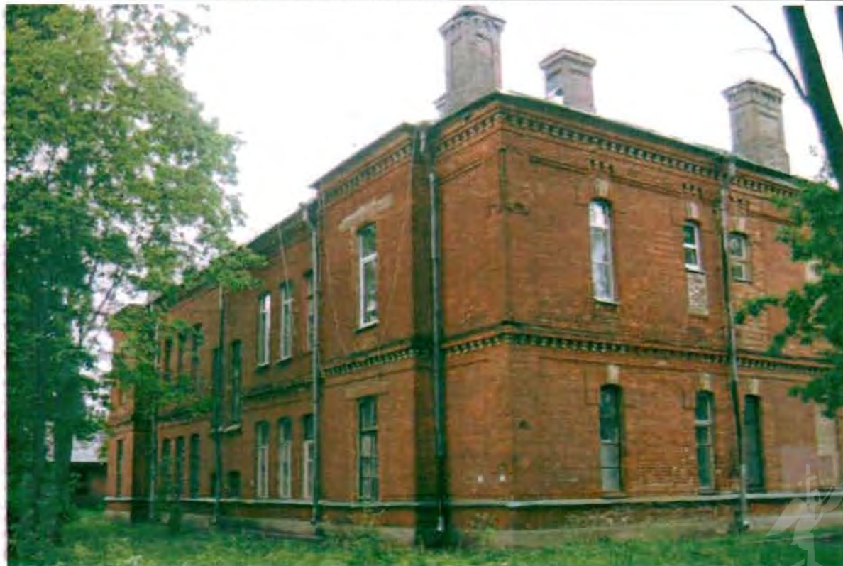
Фото 105. Западный, южный фасады. Общий вид.
