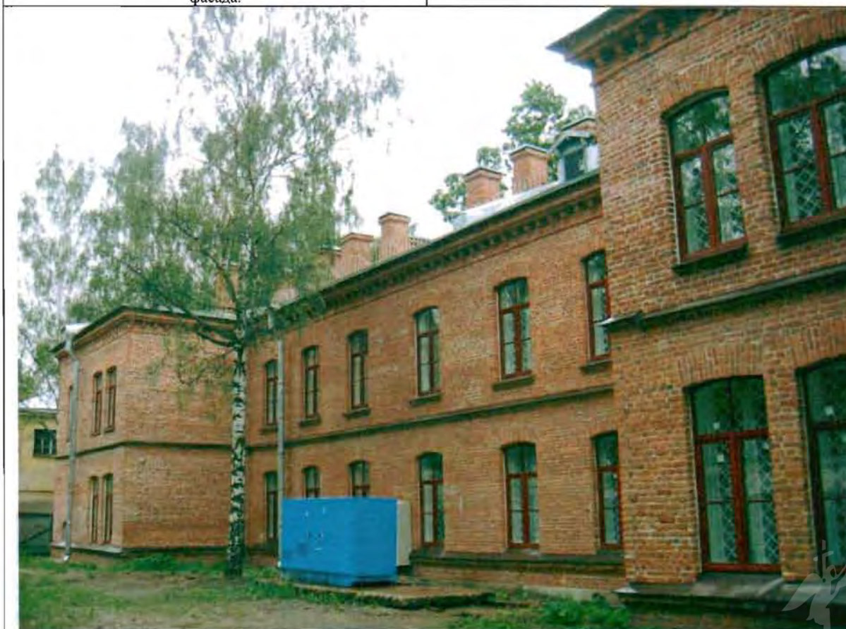
Фото 42. Западный фасад. Общий вид.
