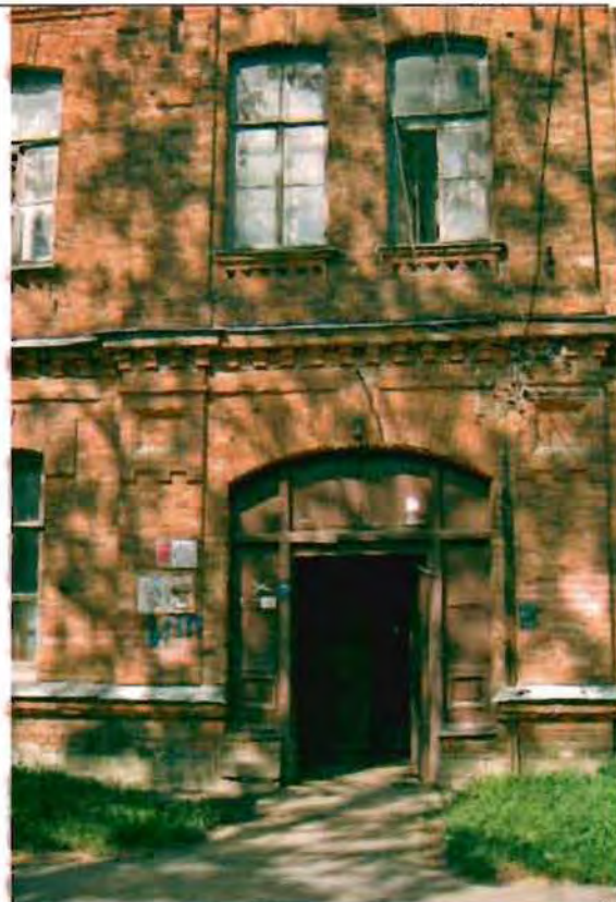
Фото 178. Восточный фасад. Центральная часть. Фрагмент.
