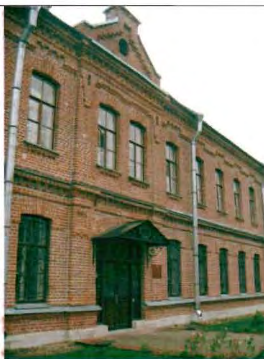
Фото 135. Западный фасад. Фрагмент центральной части фасада.
