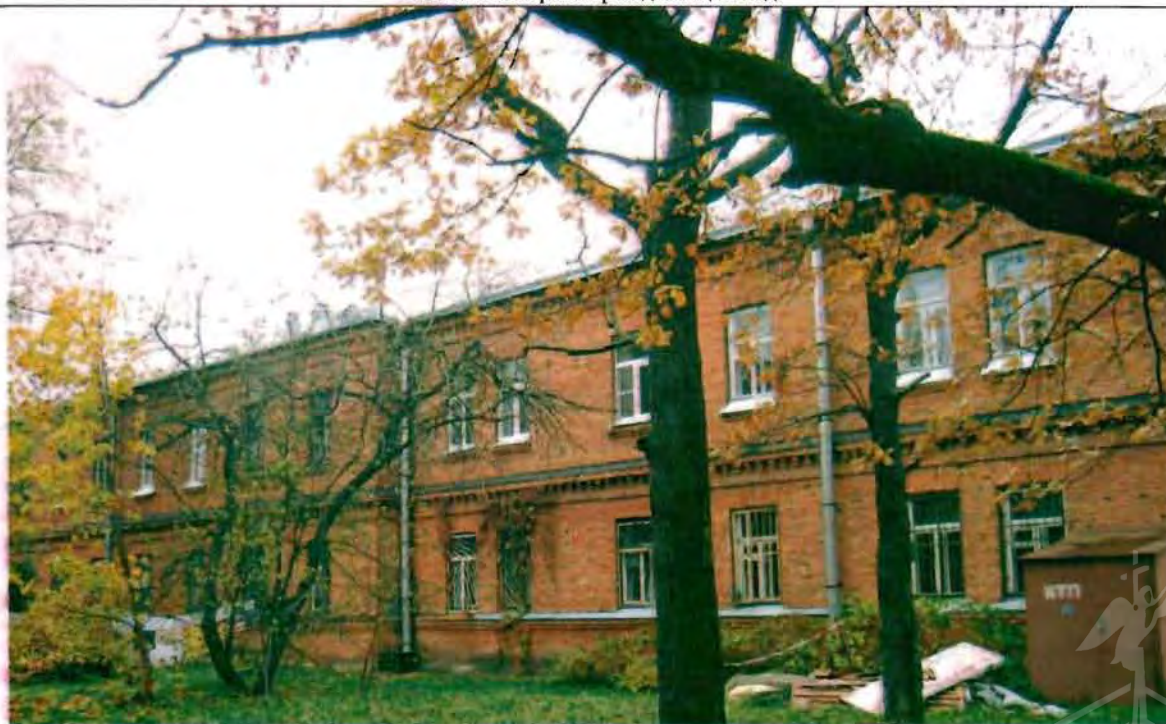
Фото 84. Южный фасад. Общий вид.
