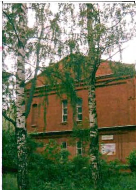
Фото 91. Северный фасад. Общий вид.
