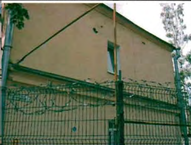
Фото 113. Северный фасад. Общий вид.
