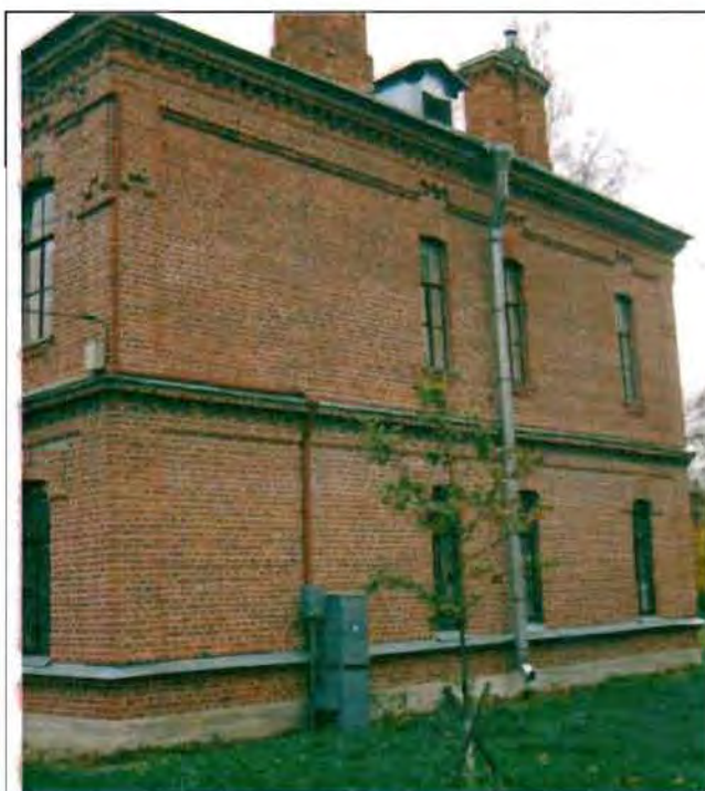
Фото 134. Южный фасад. Общий вид.
