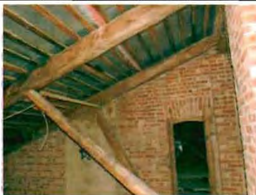
Фото 127. Конструкции крыши. Общий вид.
