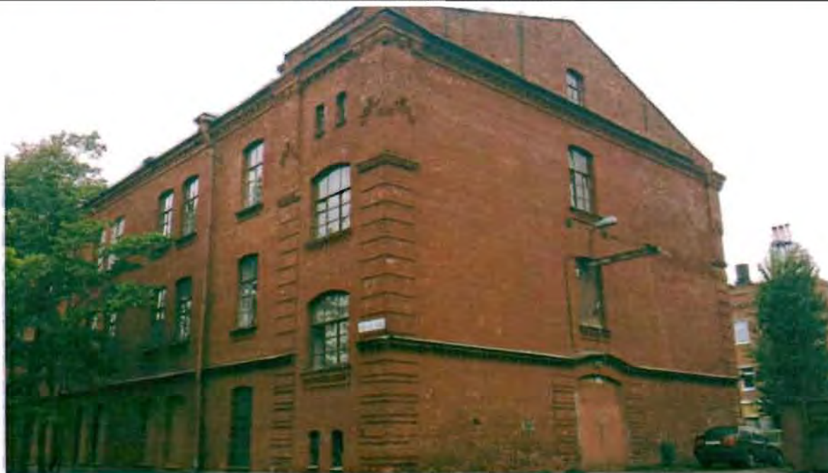
Фото 30. Северный фасад. Общий вид.
