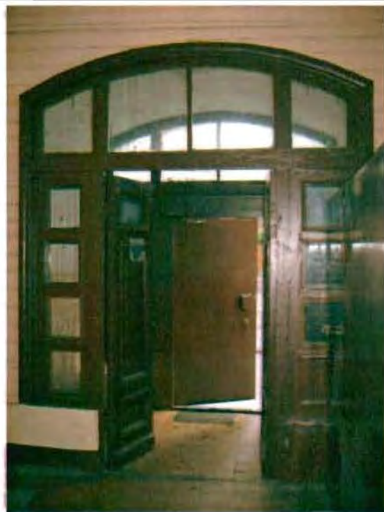
Фото 107. Дверной проем тамбура. Общий вид.
