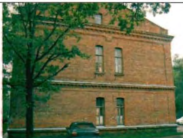
Фото 167. Северный фасад. Общий вид.
