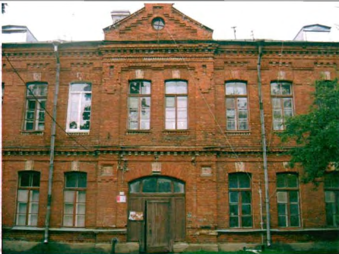
Фото 104. Восточный фасад. Центральная часть. Общий вид.
