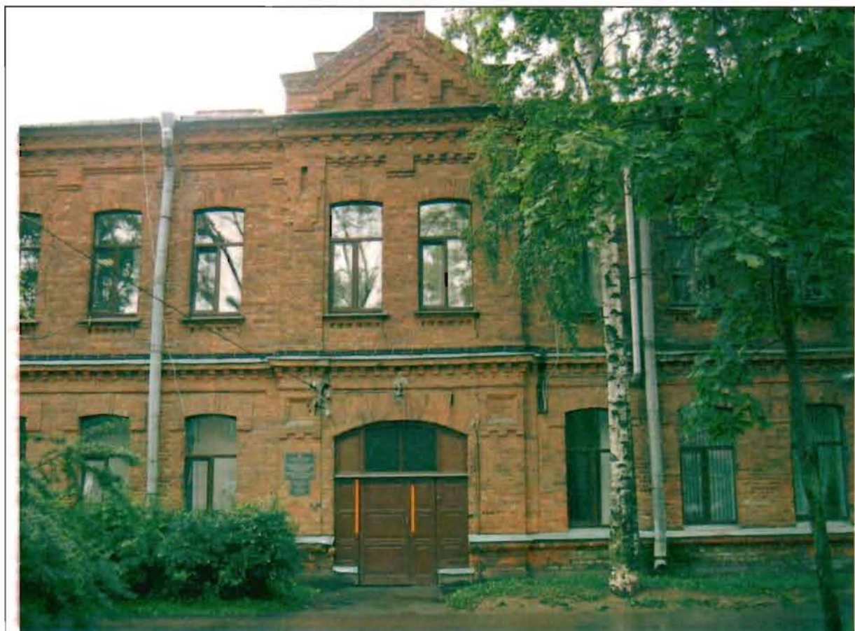
Фото 164. Восточный фасад. Фрагмент центральной части фасада.
