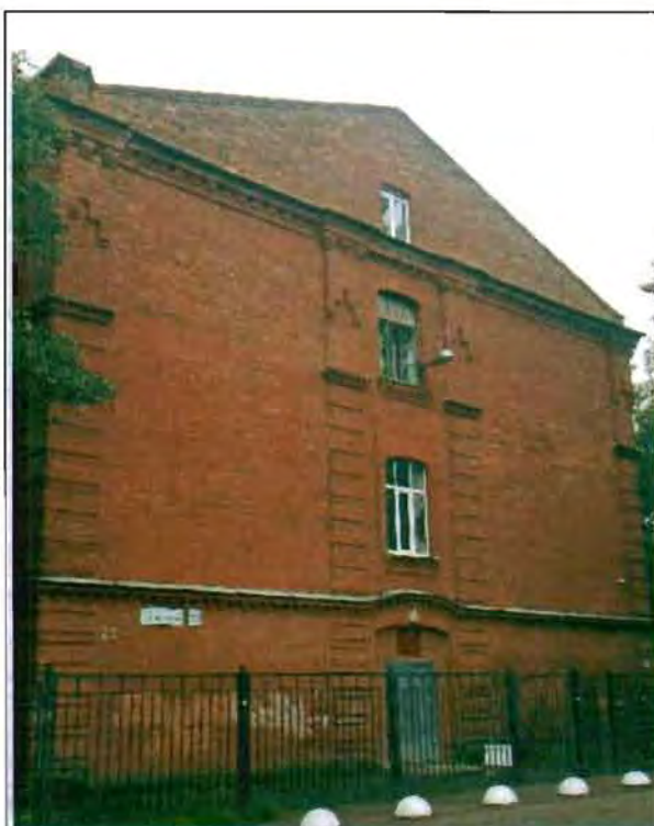
Фото 49. Северный фасад. Общий вид.
