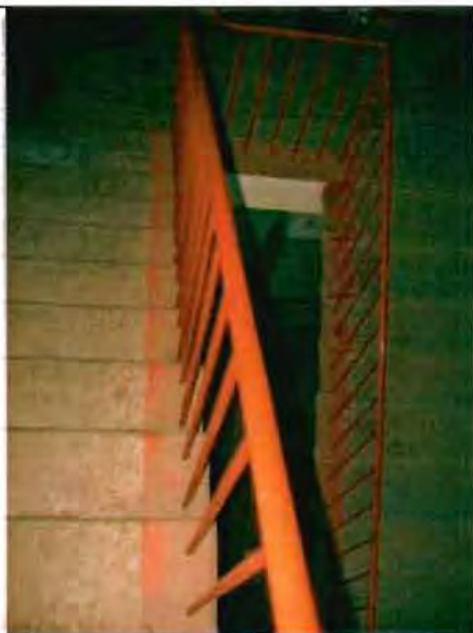
Фото 149. Лестница № 1 в северной части здания. Общий вид.
