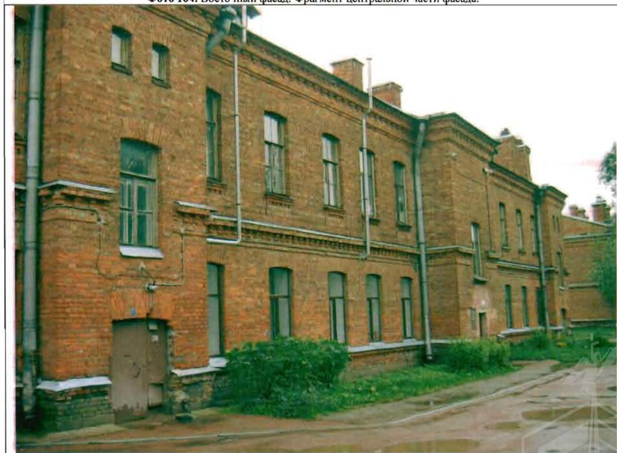
Фото 165. Западный фасад. Общий вид.
