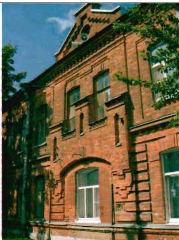
Фото 137. Восточный фасад. Фрагмент.
