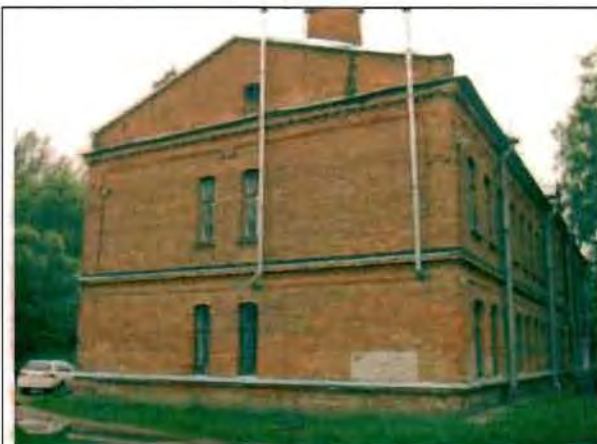
Фото 166. Южный фасад. Общий вид.
