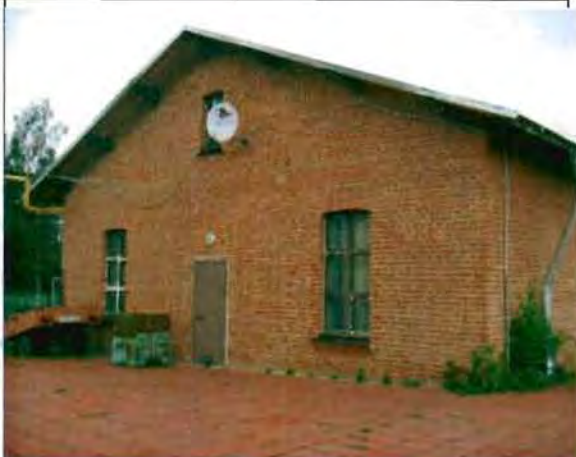
Фото 21. Южный фасад. Общий вид.
