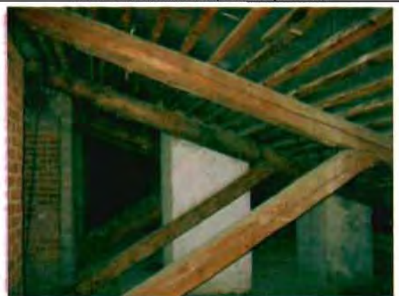
Фото 141. Конструкции крыши. Фрагмент.
