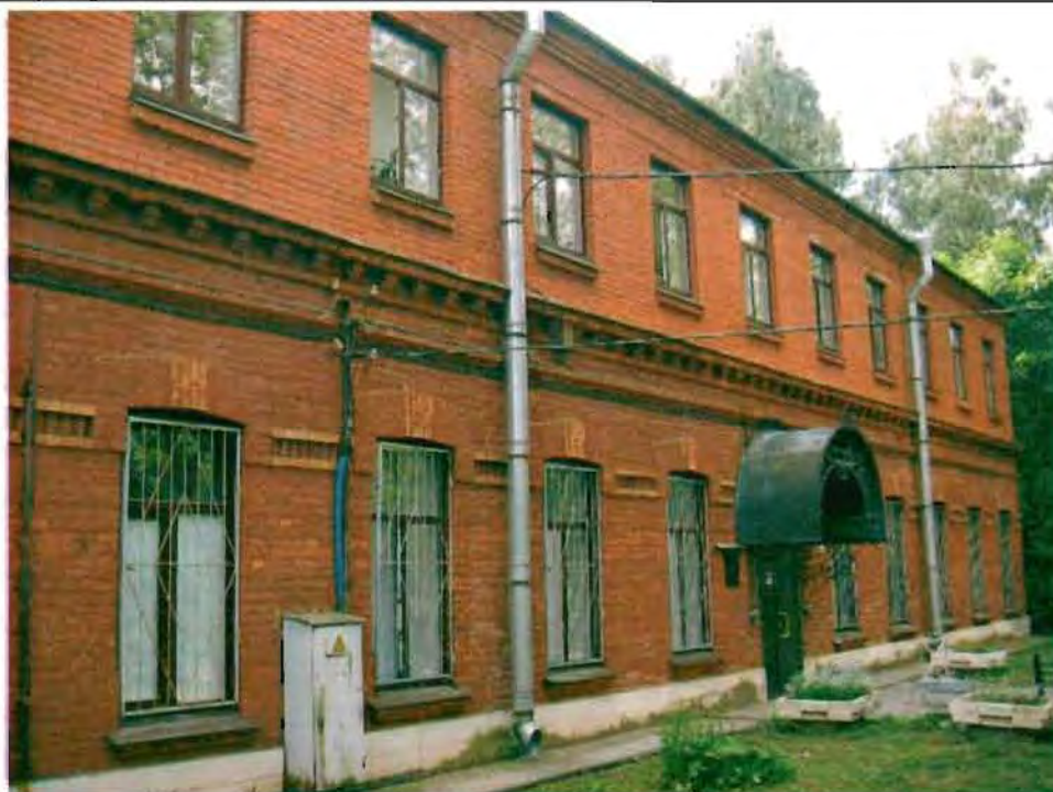
Фото 78. Западный фасад. Общий вид.
