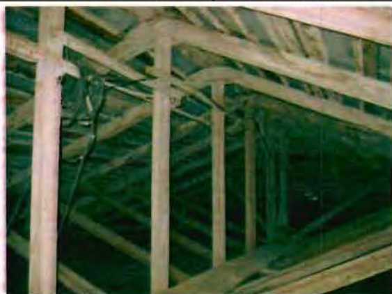
Фото 81 Конструкции крыши. Общий вид.
