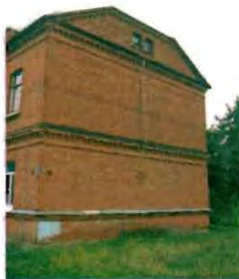
Фото 86. Западный фасад. Общий вид.
