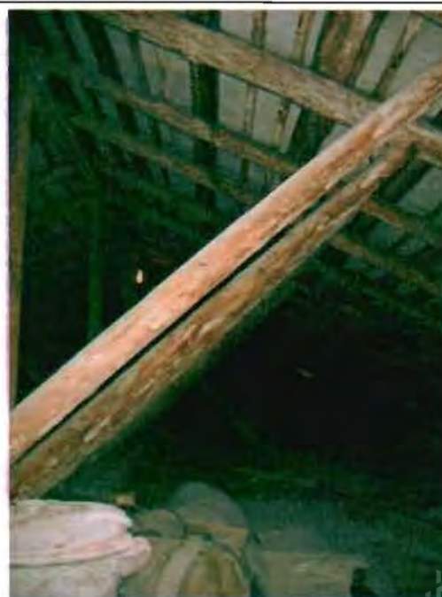
Фото 27. Конструкции крыши. Фрагмент.
