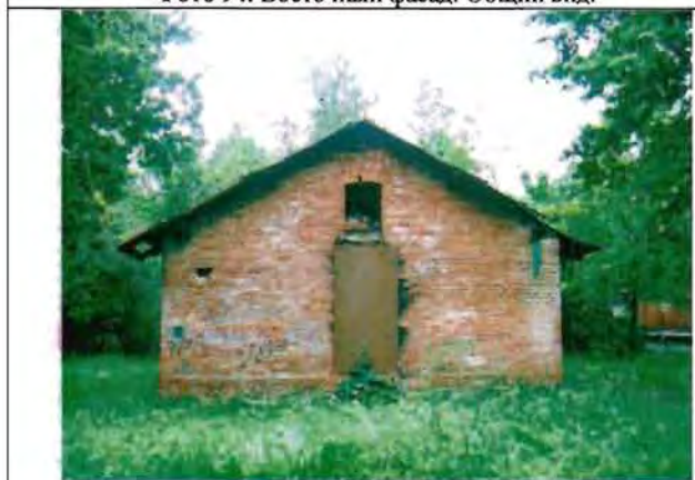
Фото 96. Западный фасад. Общий вид.
