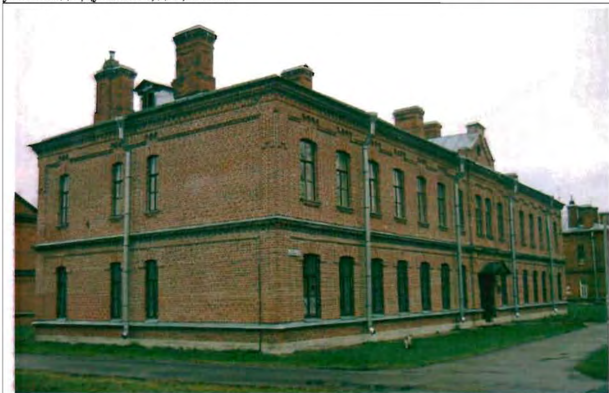
Фото 132. Западный, северный фасады. Общий вид.
