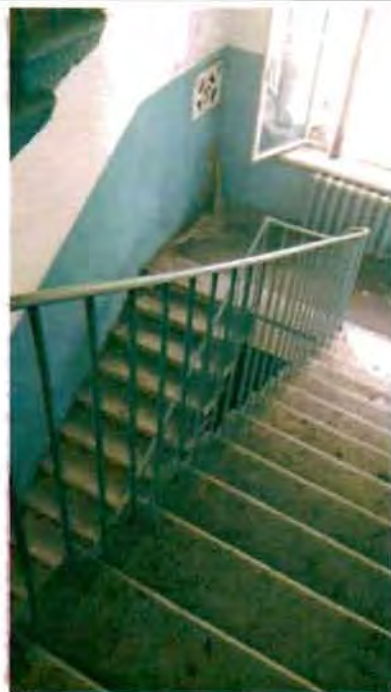
Фото 144. Лестница № 2 в южной части здания. Общий вид.
