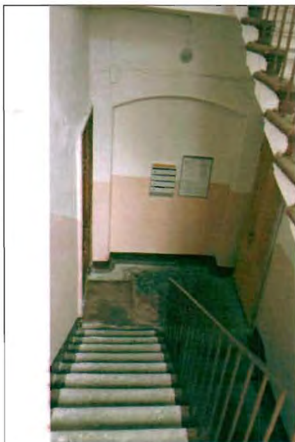
Фото 130. Лестница № 1 в южной части здания. Общий вид.
