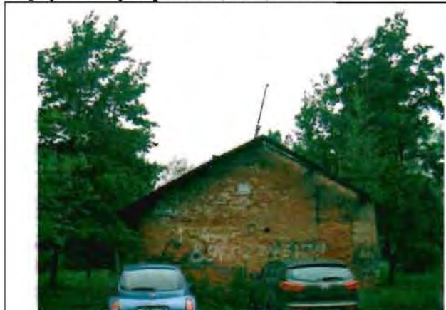
Фото 94. Восточный фасад. Общий вид.
