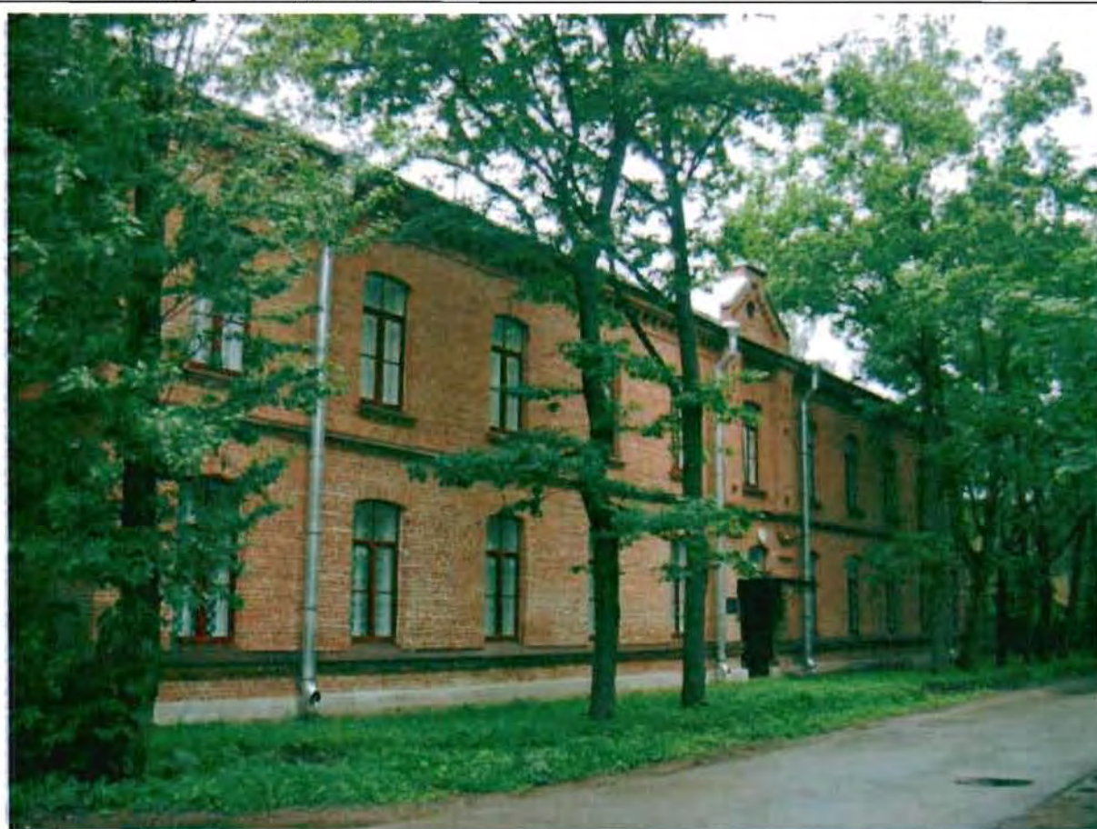
Фото 39. Восточный фасад. Общий вид.
