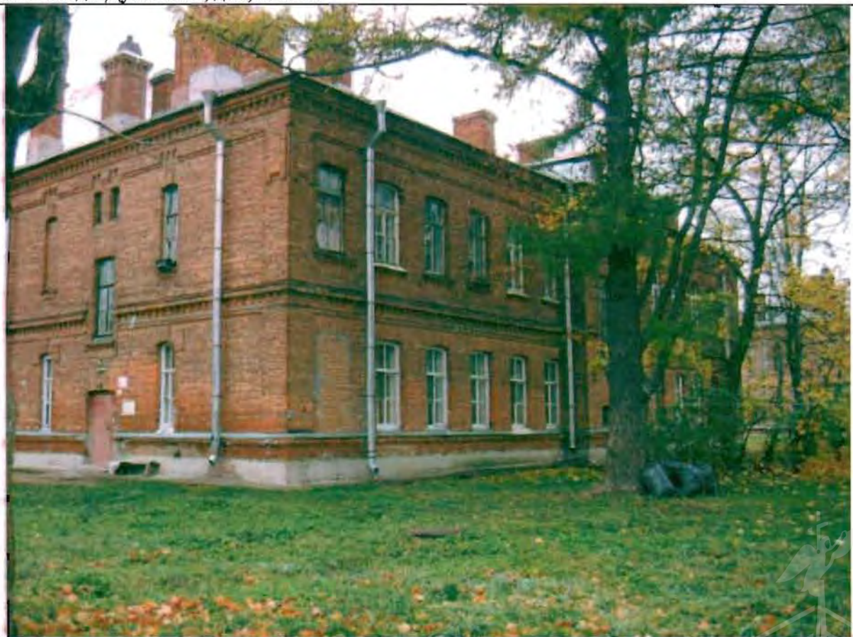
Фото 145. Восточный фасад. Общий вид.
