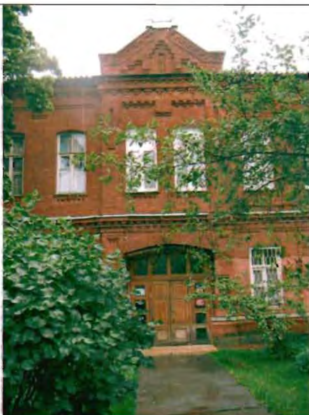
Фото 90. Восточный фасад. Центральная часть. Общий вид.
