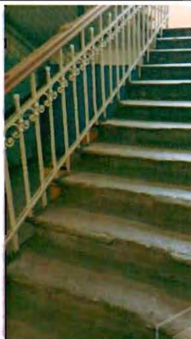
Фото 57. Лестница в центральной части здания. Фрагмент.
