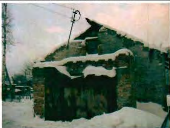
Фото 184. Восточный фасад. Общий вид. 14.01.2015.
