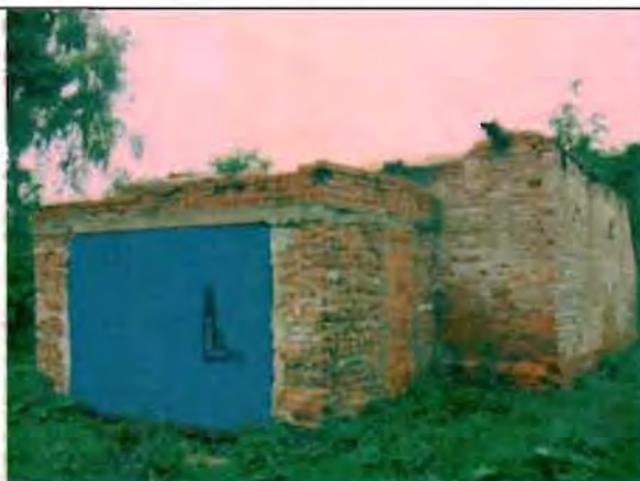
Фото 185. Восточный фасад. Общий вид.
