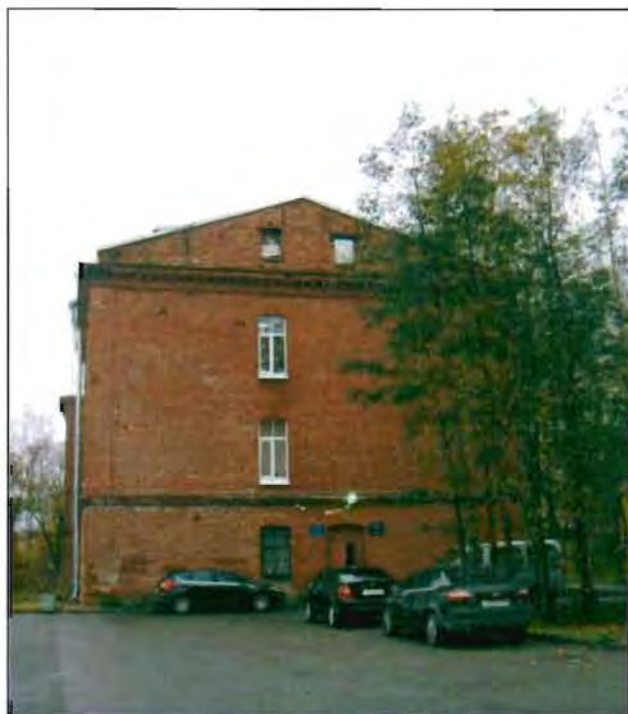
Фото 15. Северный фасад. Общий вид.
