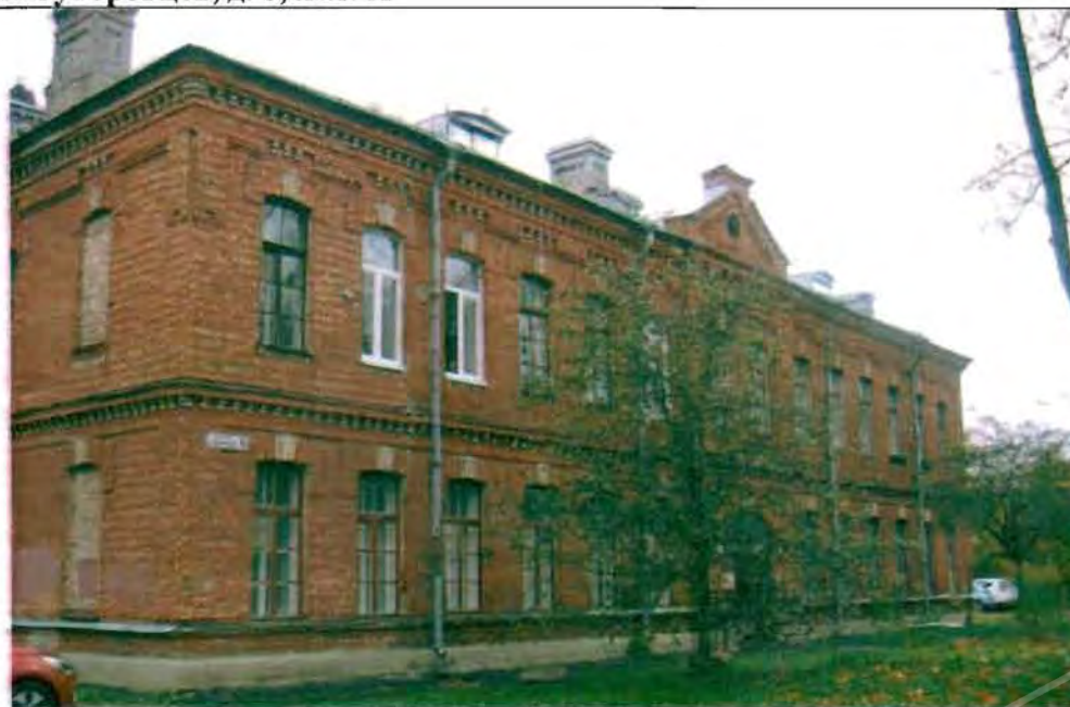
Фото 103. Восточный фасад. Общий вид.
