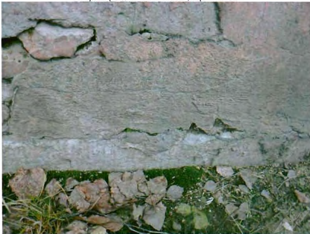
Цоколь, облицованный известняковой скобой. Съемка 27.11.2012, Воронина Н.В.
