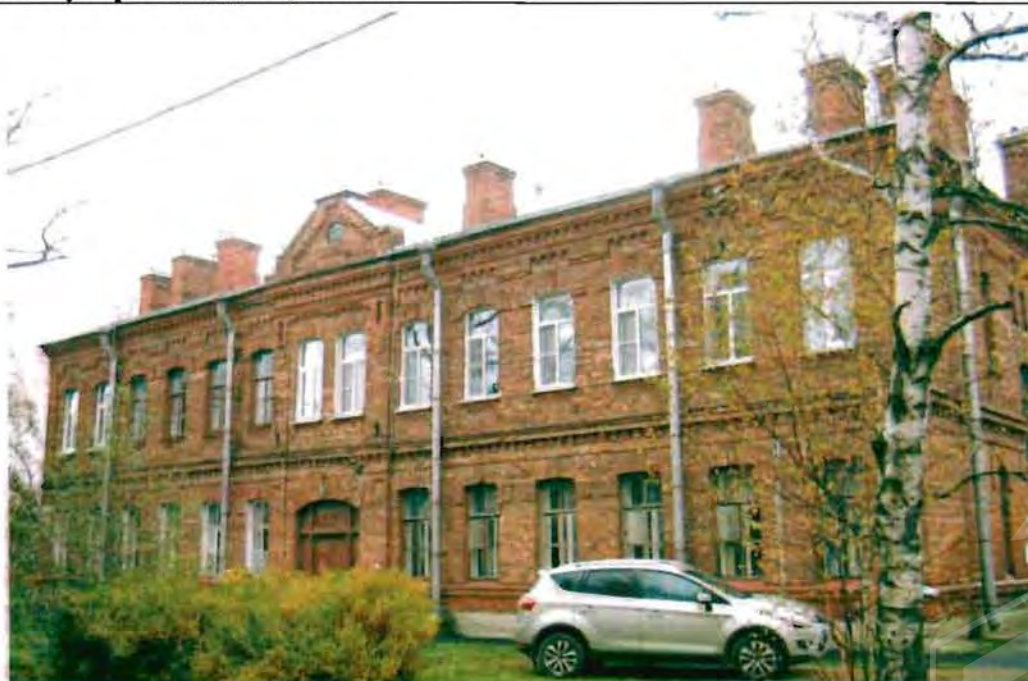
Фото 128. Восточный фасад. Общий вид.
