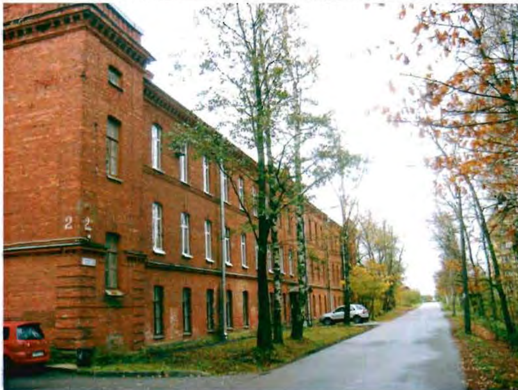
Фото 13. Западный фасад. Общий вид.
