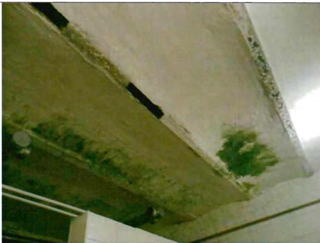
Своды по металлическим балкам. Съемка 27.11.2012, Воронина Н.В.
