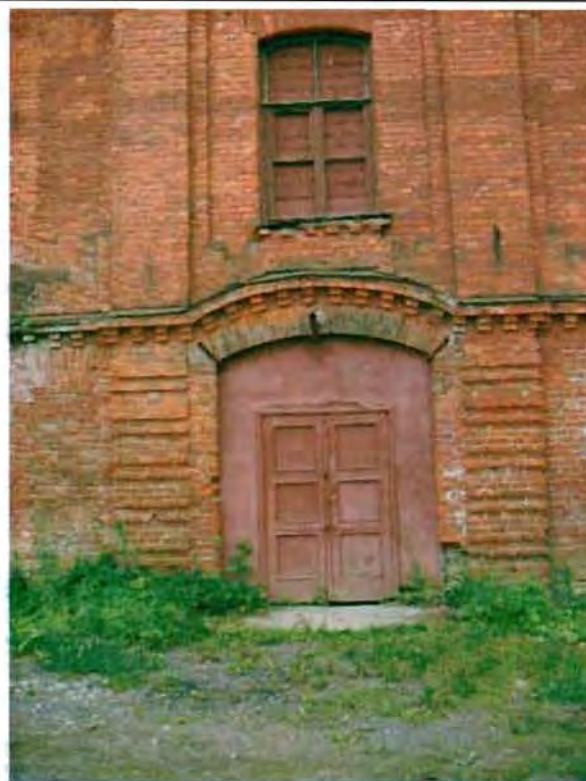
Фото 4. Западный фасад. Фрагмент центральной части фасада.
