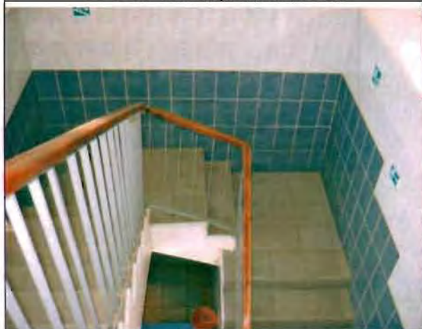
Фото 114. Лестница. Общий вид.
