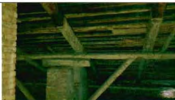
Фото 38. Конструкции крыши. Фрагмент.
