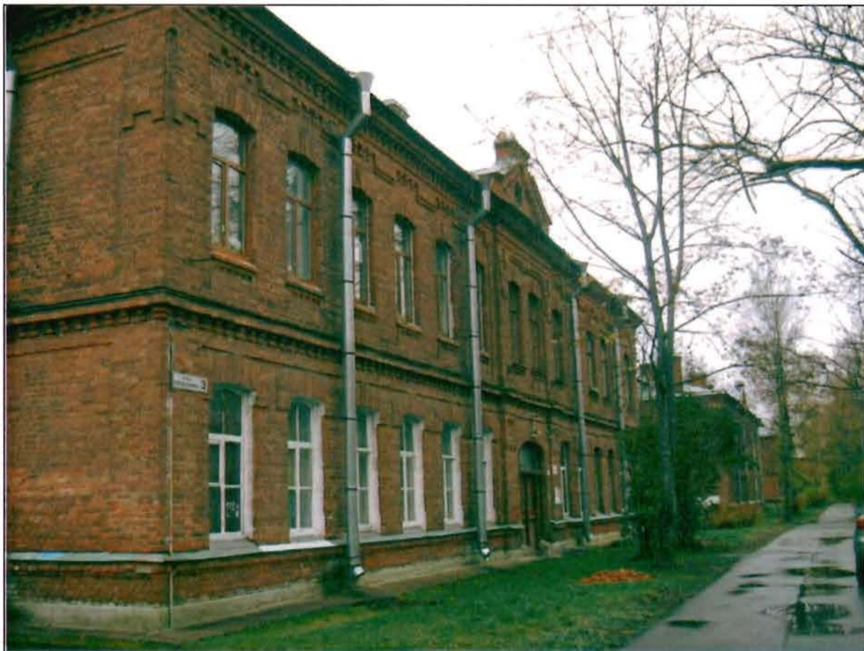
Фото 146. Западный фасад. Общий вид.
