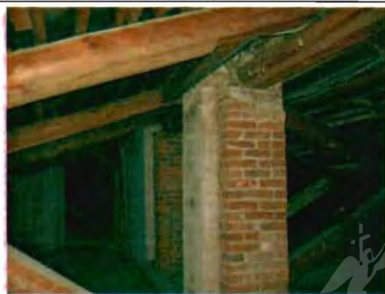
Фото 142. Конструкции крыши. Фрагмент.
