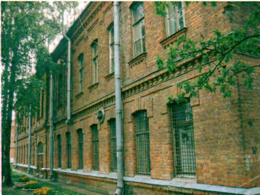
Фото 163. Восточный фасад. Общий вид.
