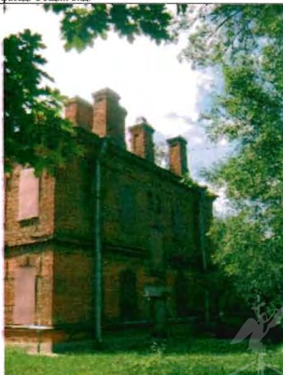
Фото 118. Северный фасад. Общий вид.
