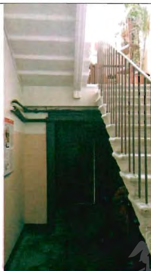
Фото 131. Лестница № 2 в северной части здания. Общий вид.
