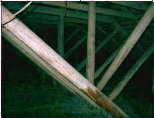
Фото 88. Конструкции крыши. Общий вид.
