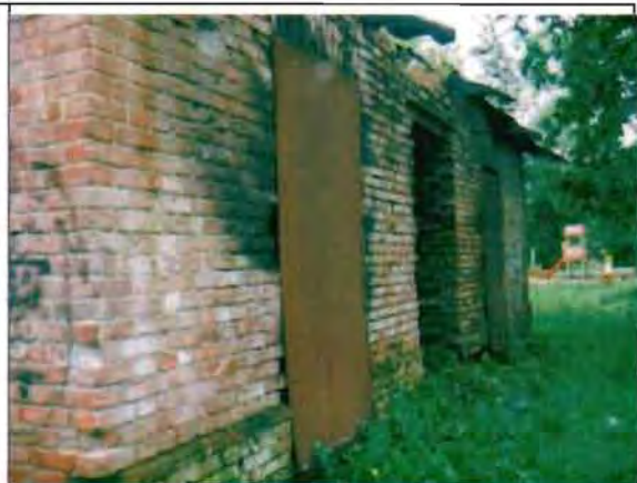
Фото 95. Северный фасад. Общий вид.
