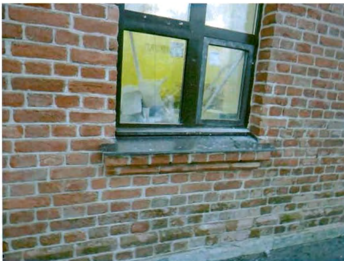
Ступенчатые подоконные доски. Съемка 20.11.2012, Воронина Н.В.
