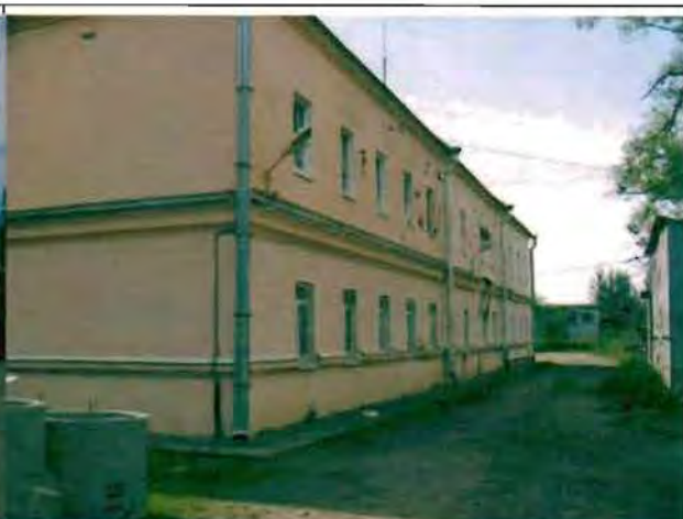
Фото 111. Западный фасад. Общий вид.
