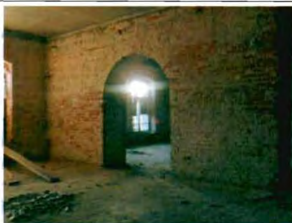
Фото 8. Интерьер. Общий вид. 29.12.2015.
