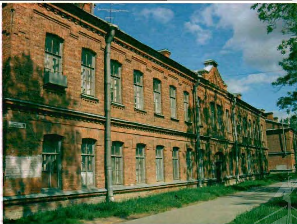
Фото 176. Восточный фасад. Общий вид.
