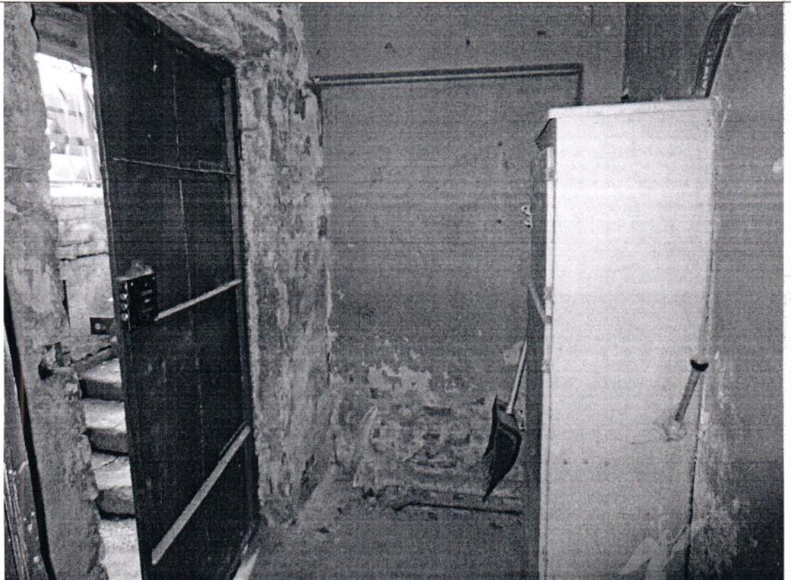
Описание: в ч.п. 8 Объекта оборудована ниша
