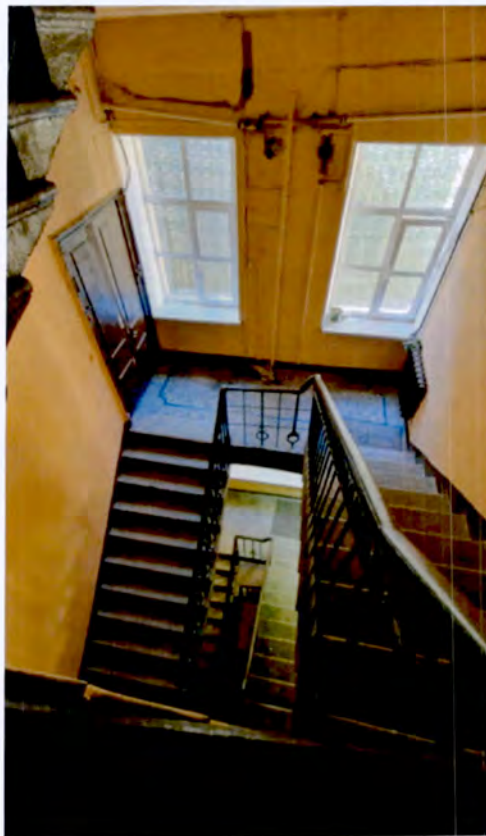
4. Лестница Л-1 (Фотография от 24.05.2024).
