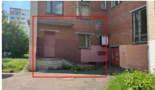
Фото 6. Отдельный вход со двора и окно
