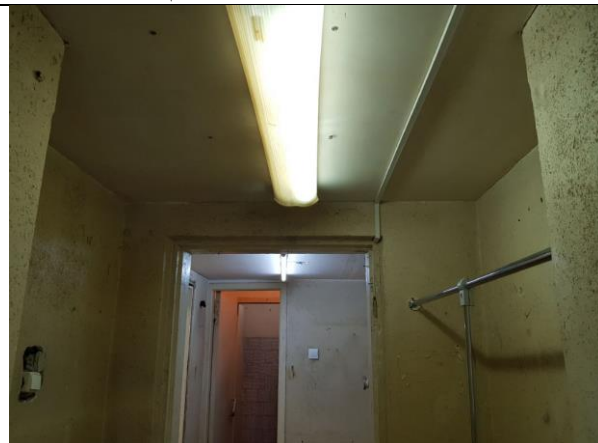
Фото 10. Внутреннее состояние Объекта оценки
