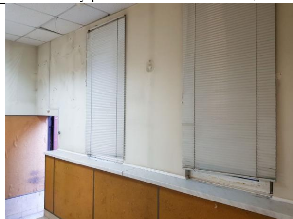
Фото 11. Внутреннее состояние Объекта оценки
