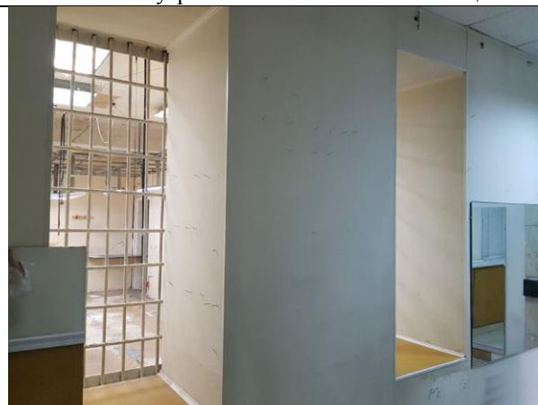
Фото 12. Внутреннее состояние Объекта оценки
