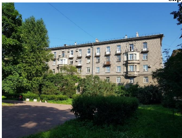
Фото 1. Вид здания Объекта оценки
