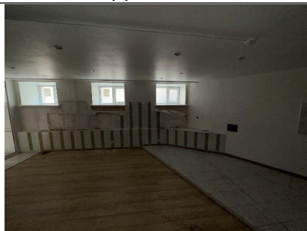
Фото № 18 – Внутреннее состояние помещения
