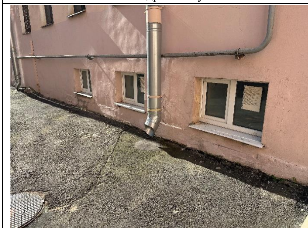
Фото № 7 – Расположение окон помещения
