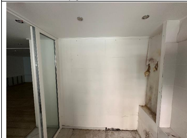
Фото № 11 – Внутреннее состояние помещения
