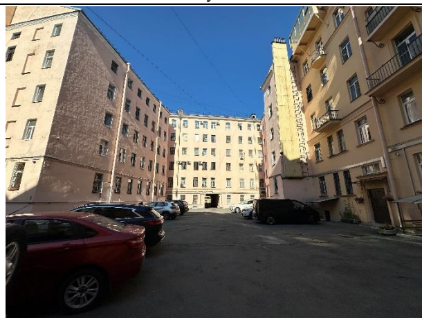
Фото № 3 – Подъездные пути
