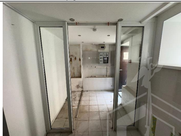
Фото № 20 – Внутреннее состояние помещения
