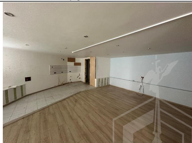
Фото № 12 – Внутреннее состояние помещения
