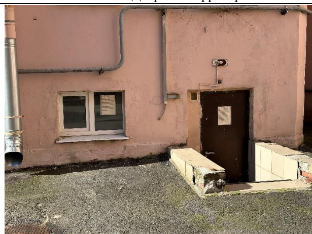
Фото № 8 – Вход в помещение со двора
