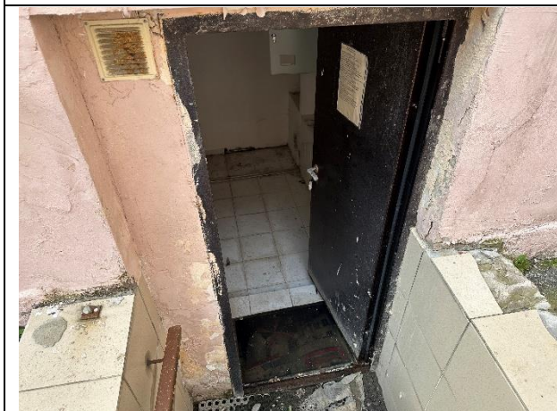
Фото № 9 – Внутреннее состояние помещения
