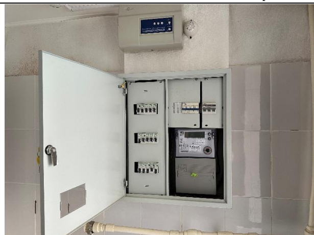
Фото № 10 – Внутреннее состояние помещения
