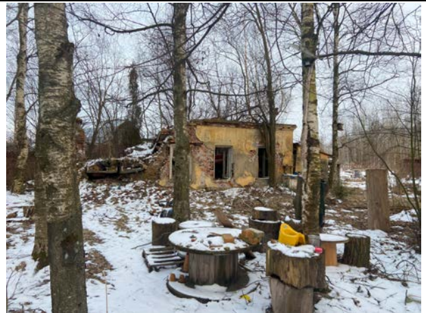
Фото № 12. Внешний вид здания литеры Д
