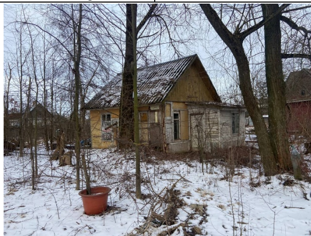
Фото № 13. Внешний вид здания литеры Е
