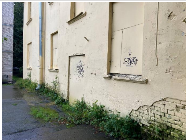
Фото № 9. Внешний вид здания
