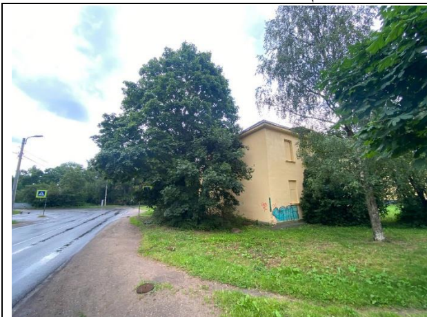
Фото № 1. Подъездные пути и окружение объекта
