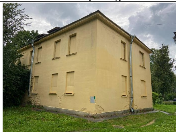
Фото № 4. Внешний вид здания
