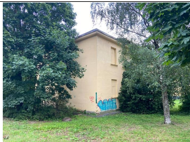
Фото № 2. Подъездные пути и окружение объекта
