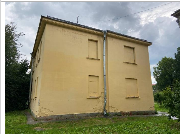
Фото № 5. Внешний вид здания
